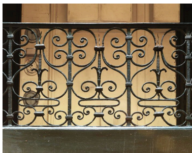
panneau droit à l'étage. Phot. Laurent Kruszyk IVR11_20107500902NUC4A
