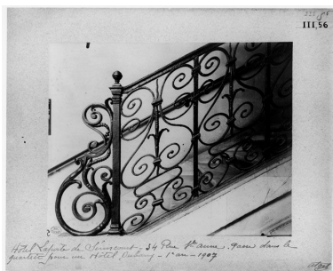
Vue de la console de départ et des premiers balustres. Photographie. (Commission du Vieux Paris, photographies Atget III, 56) Phot. Laurent Kruszyk, Autr. Eugene Atget IVR11_20097500342NUC2B
