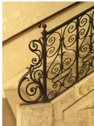
console et départ de l'escalier. Phot. Laurent Kruszyk IVR11_20107500901NUC4A
