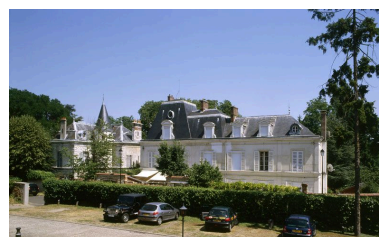
Facade sur rue. Phot. Laurent Kruszyk IVR11_20067800832XA
