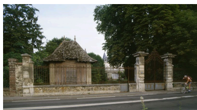
Fabrique de jardin placée du côté de la Seine. Phot. Laurent Kruszyk IVR11_20067800833XA
