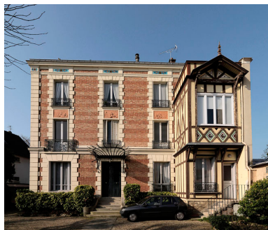
Vue d'ensemble de la façade antérieure.
