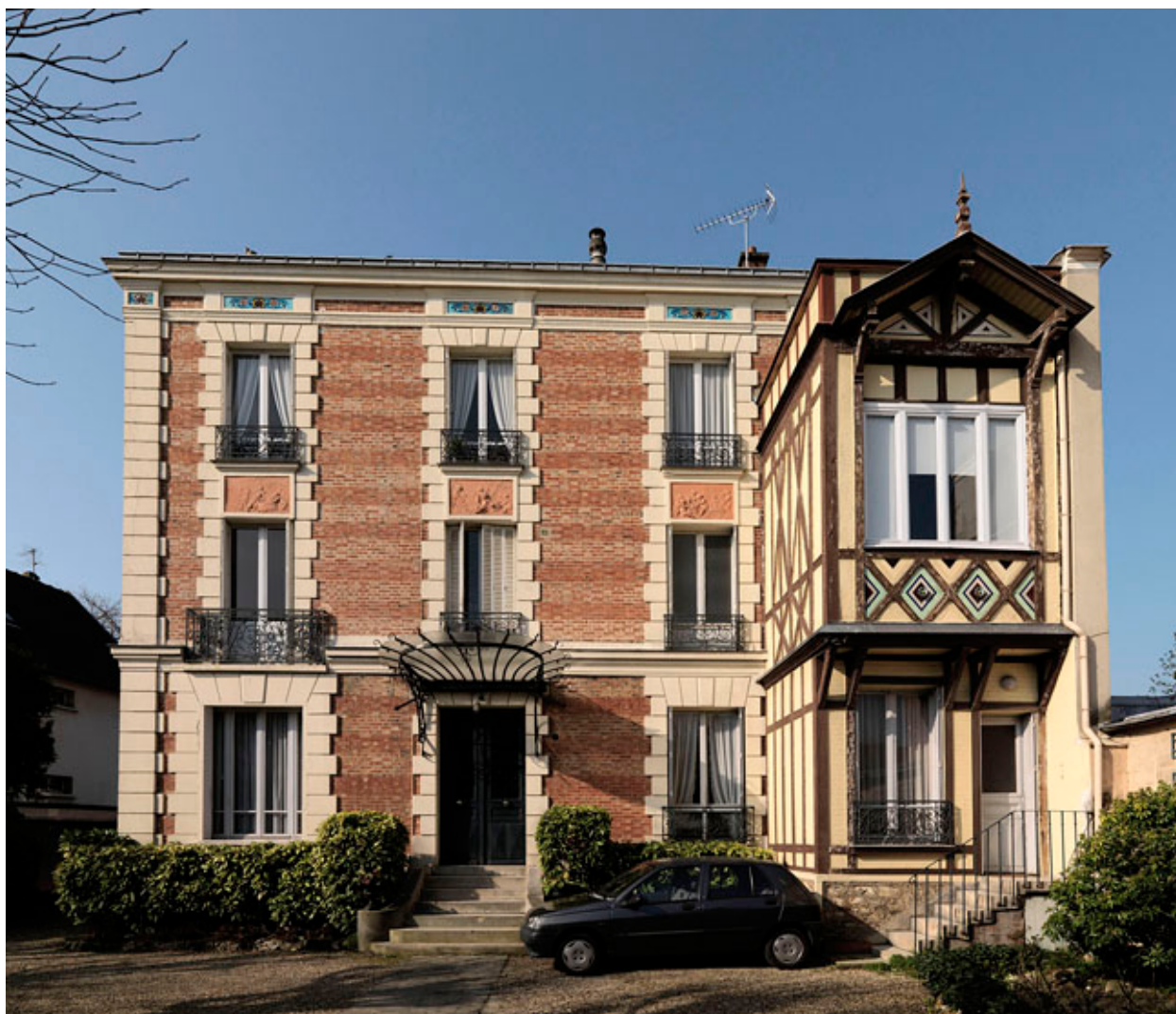
Vue d'ensemble de la façade antérieure.
