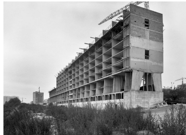
Vue du chantier de construction des barres G et H. Photographie, 1961. (Ministère de l'Ecologie, MRU 38113001) Phot. MEEDDAT-DICOM IVR11_20109100157NUC1B
