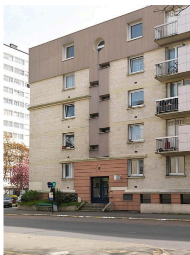
Vue d'une façade réhabilitée : l'entrée a été entièrement refaite,
