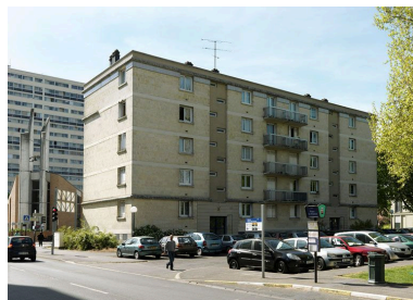
Façade principale sur parking de la barre B. Phot. Jean-Bernard Vialles IVR11_20109100049NUC4A
