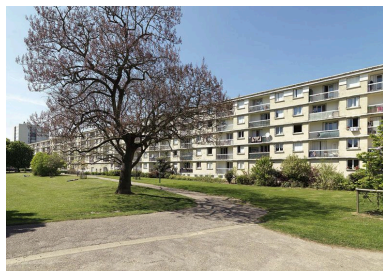
Façade arrière sur jardin de la barre A. Phot. Jean-Bernard Vialles IVR11_20109100048NUC4A
