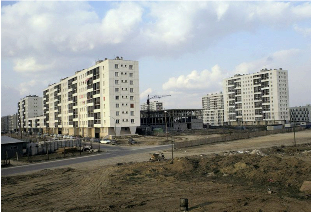
Le chantier de construction des barres F, G, H et J depuis l'avenue du Noyer Lambert. Photographie, 1965. (Ministère de l'Écologie, STU00336)
