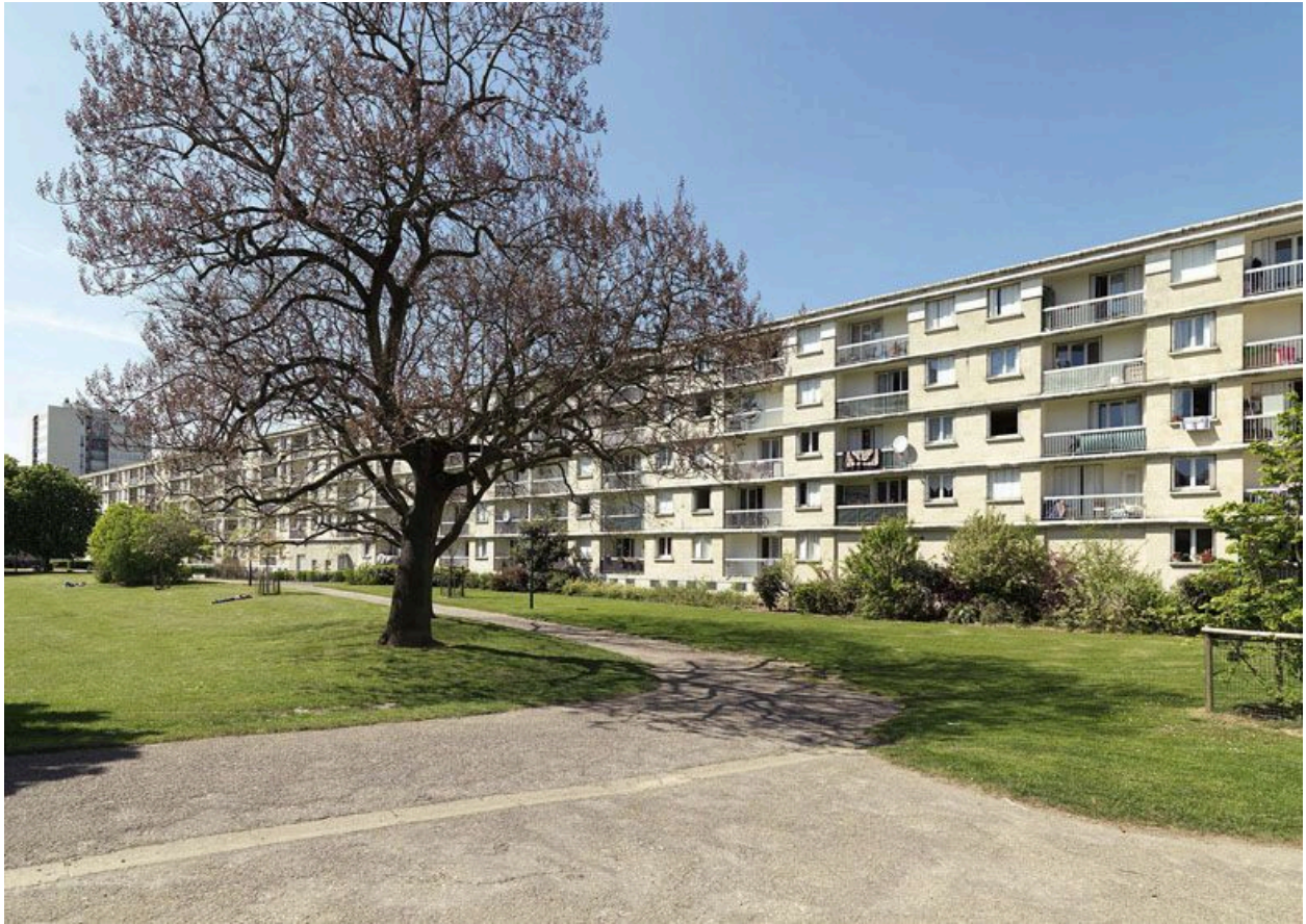
Façade arrière sur jardin de la barre A.
