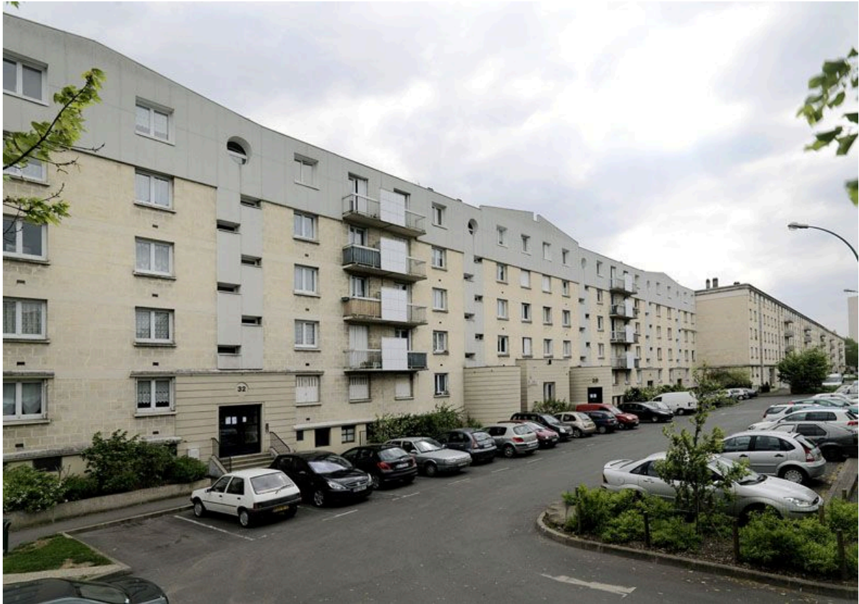
La barre A après rénovation.
