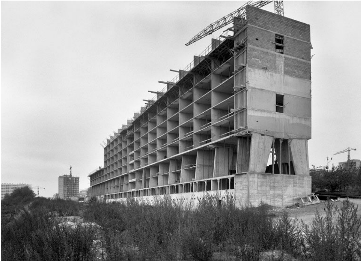
Vue du chantier de construction des barres G et H. Photographie, 1961. (Ministère de l'Ecologie, MRU 38113001)
