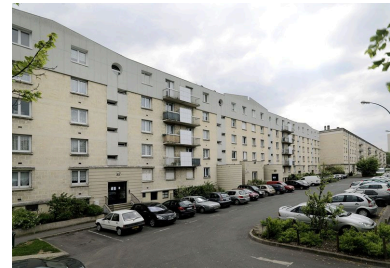
La barre A après rénovation. Phot. Jean-Bernard Vialles IVR11_20109100046NUC4A
