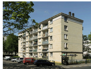
façade arrière sur parking de la barre D. Phot. Jean-Bernard Vialles IVR11_20109100050NUC4A
