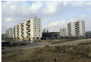
Le chantier de construction des barres F, G, H et J depuis l'avenue du Noyer Lambert. Photographie, 1965. (Ministère de l'Ecologie, STU00336) Phot. DICOM MEEDDAT IVR11_20109100166NUC2AB
