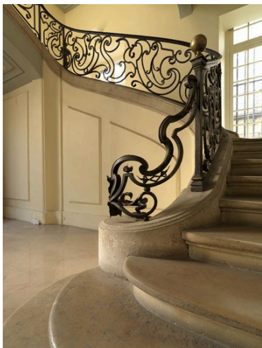
La console de départ et la deuxième volée. Phot. Laurent Kruszyk IVR11_20097500181NUC4A
