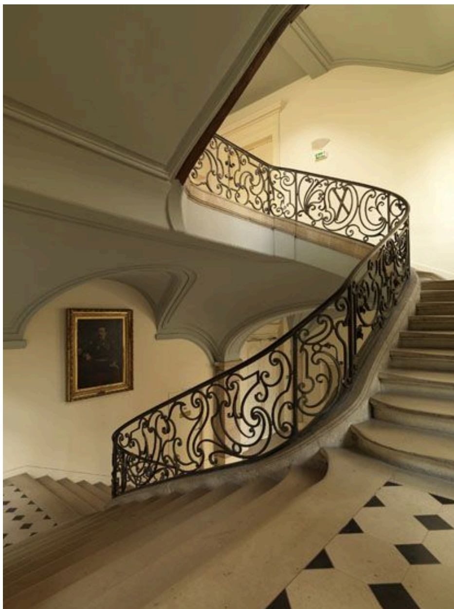
Vue d'ensemble depuis le 2e repos.
