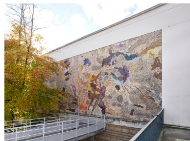
Une grande composition en ciment teinté dans la masse et en mosaïque d'ardoise, pâte de verre et marbre, d'une superficie totale d'environ 116 m 2 , épousant les contours du mur latéral du gymnase, vient égayer la sévérité des élévations du lycée. Cette œuvre, réalisée au titre du 1%
