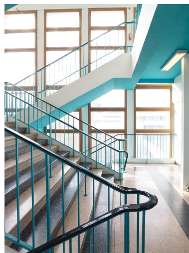
Détail de la cage d'escalier, avec les menuiseries d'origine des baies, en niangon (bois exotique clair).
