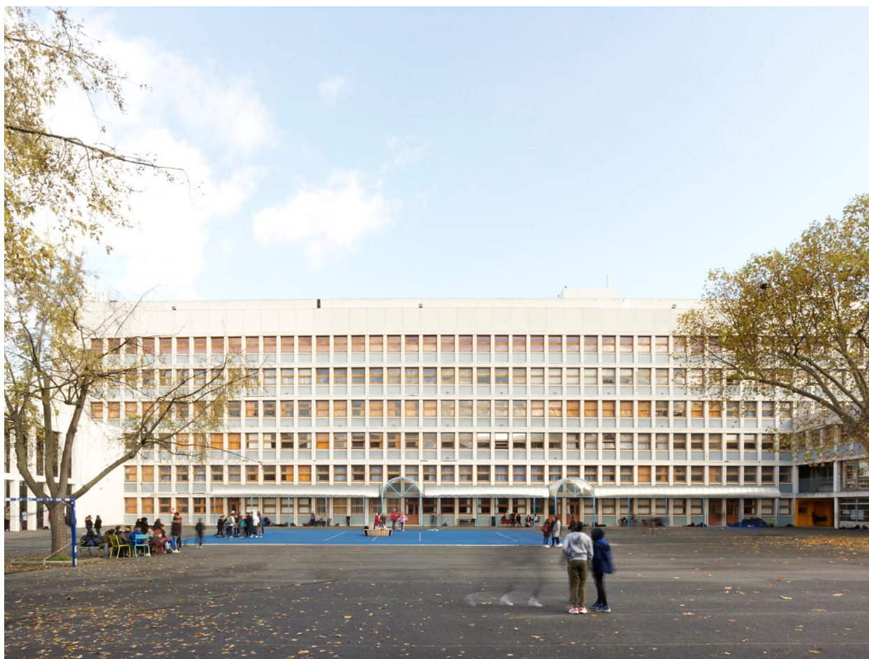
Vue générale du bâtiment principal des salles de classes, livré en 1962.
