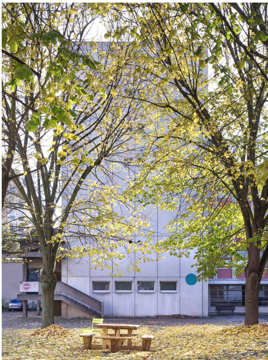
Détail du soubassement du bâtiment de l'administration et des logements, perpendiculaire à la rue Pailleron.
