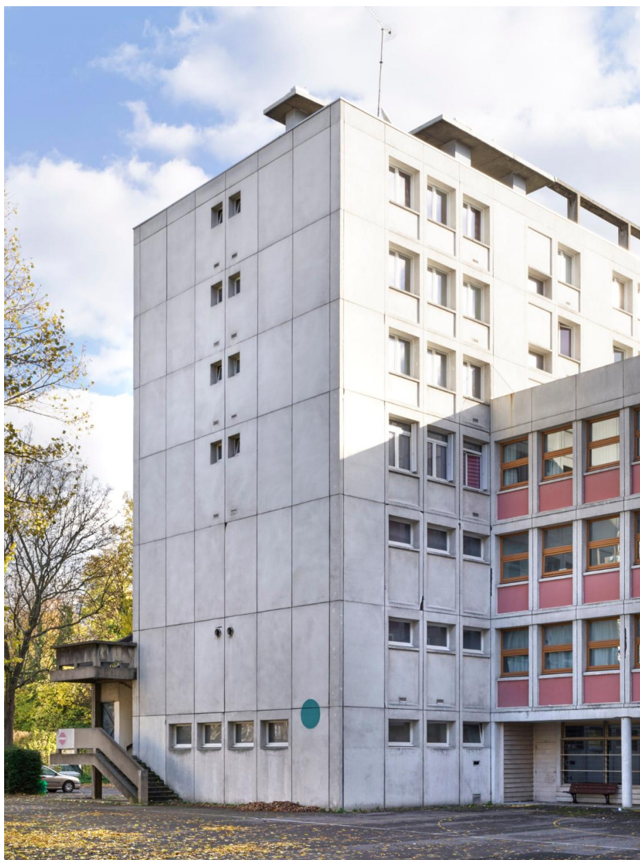
Vue générale du bâtiment abritant les logements et l'administration du lycée.
