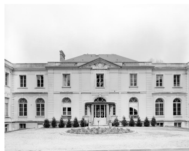
Façade postérieure, corps central. Phot. Décamps Christian IVR11_19877800247V
