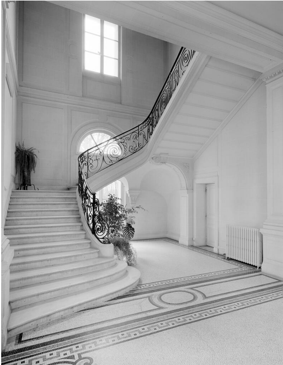
Escalier, départ de la première volée.
