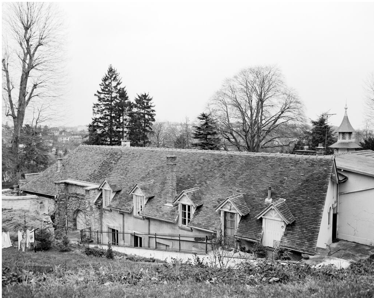
Communs, vue des toits.
