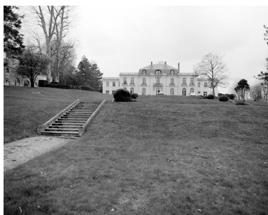
Façade antérieure, vue générale. Phot. Décamps Christian IVR11_19877800246X
