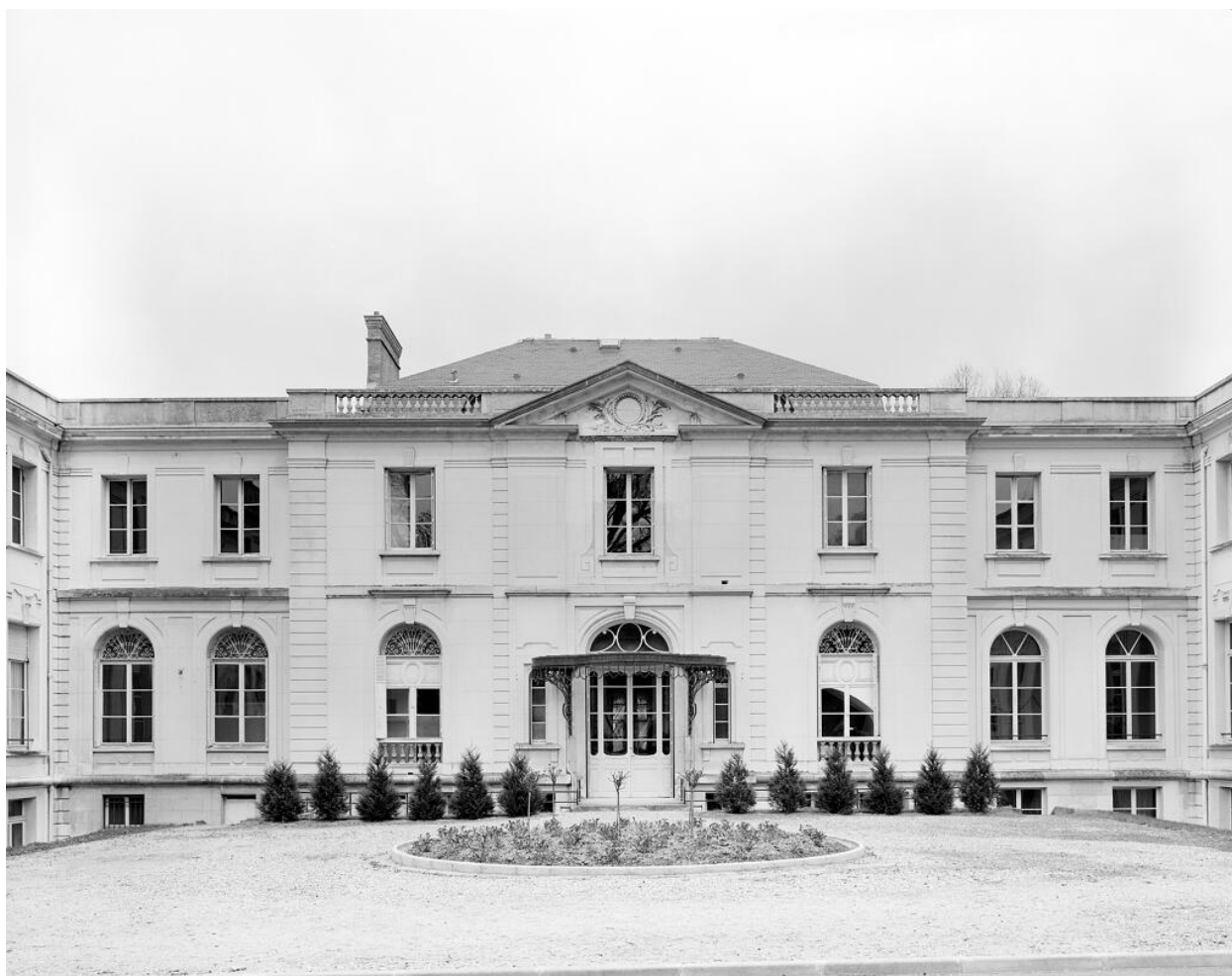
Façade postérieure, corps central.
