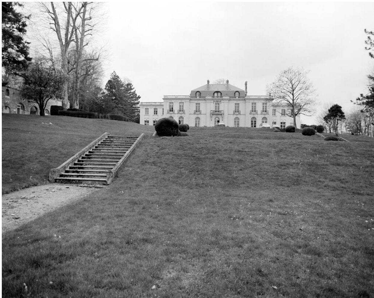
Façade antérieur, vue générale.
