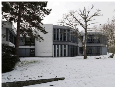
Vue des façades donnant sur le parc de la Préfecture. Phot. Philippe Ayrault IVR11_20129500041NUC4A
