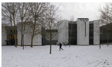
Vue des façades donnant sur le parc de la Préfecture. Phot. Philippe Ayrault IVR11_20129500044NUC4A
