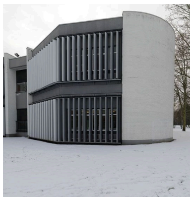
Vue des façades donnant sur le parc de la Préfecture. Phot. Philippe Ayrault IVR11_20129500043NUC4A
