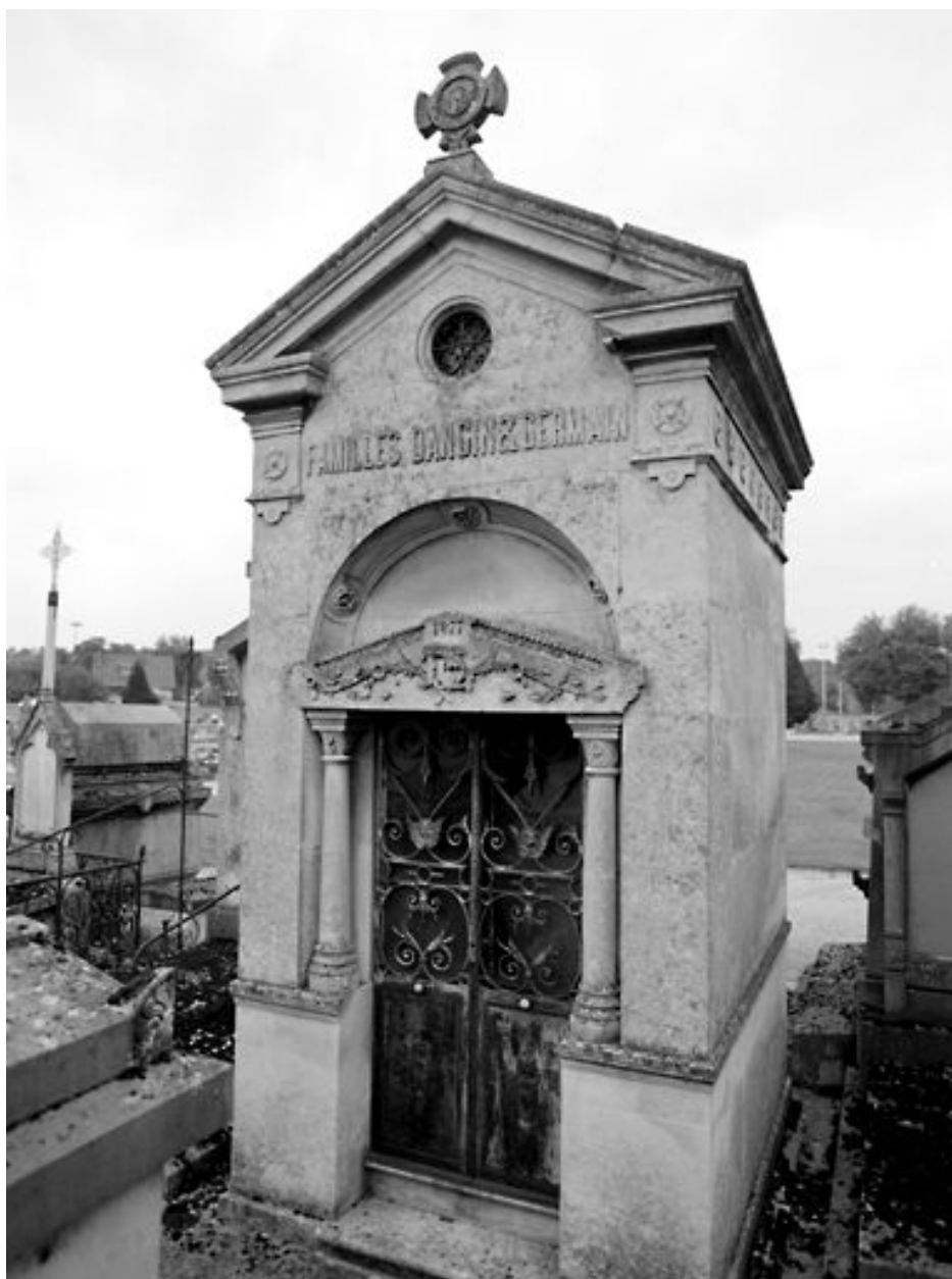
Vue d'ensemble de la chapelle. Date portée au linteau : 1877.
