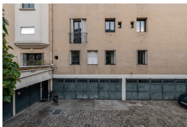
Immeuble, cour anglaise donnant accès aux garages Phot. Kruszyk Laurent IVR11_20249200979NUC4A
