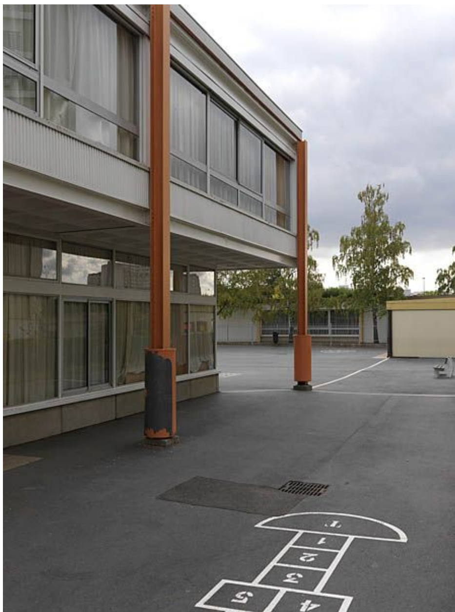
Vue des cadres rigides en profilés orange et des piliers de maintien dans le sol.
