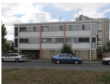
Les logements R+2 du personnel et des enseignants du groupe scolaire Alain. Les modules de bases sont plus étroits et les fenêtres possèdent des persiennes. Phot. Stéphane Asseline IVR11_20097701495NUC4A
