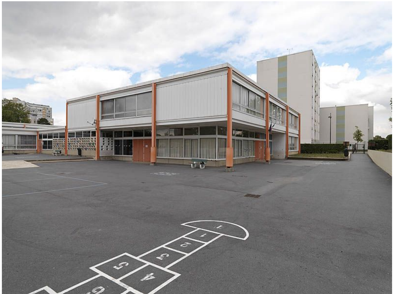
Les bâtiments de l'école primaire Alain. Vue de la façade principale et du préau sur cour. Structure de profilés oranges en acier et aluminium anodisé définissant les modules de chaque classe. Décor de claustra en béton.
