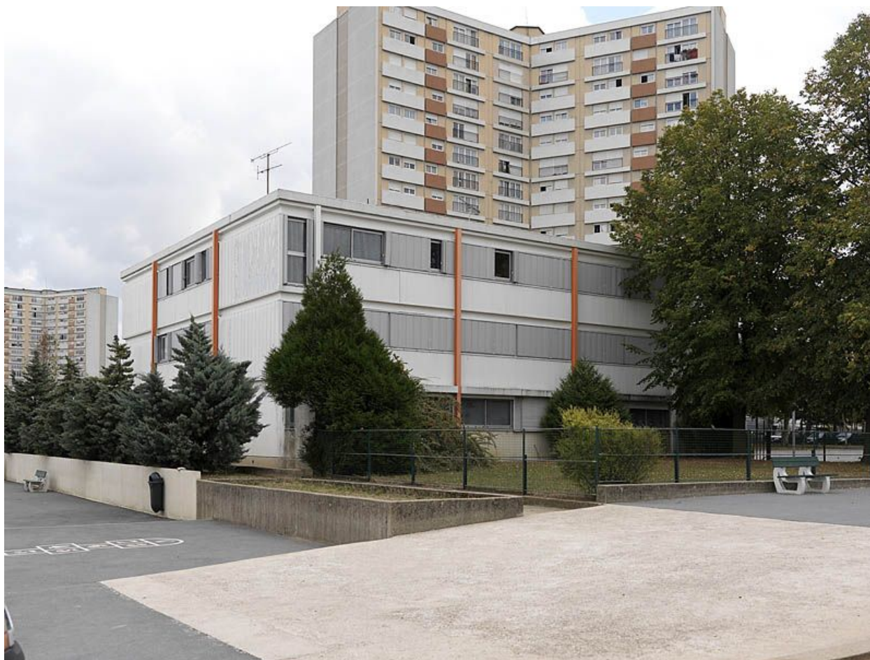
Les logements R+2 du personnel et des enseignants du groupe scolaire Alain, avec une tour tripode en second plan.
