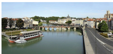
Le quai Victor-Hugo prolongé par le quai Jacques-Prévert, en bordure de Marne. Vue panoramique, prise depuis un ballon captif, depuis l'est. Phot. delage.balloide-photo.com IVR11_20127701196NUC4A
