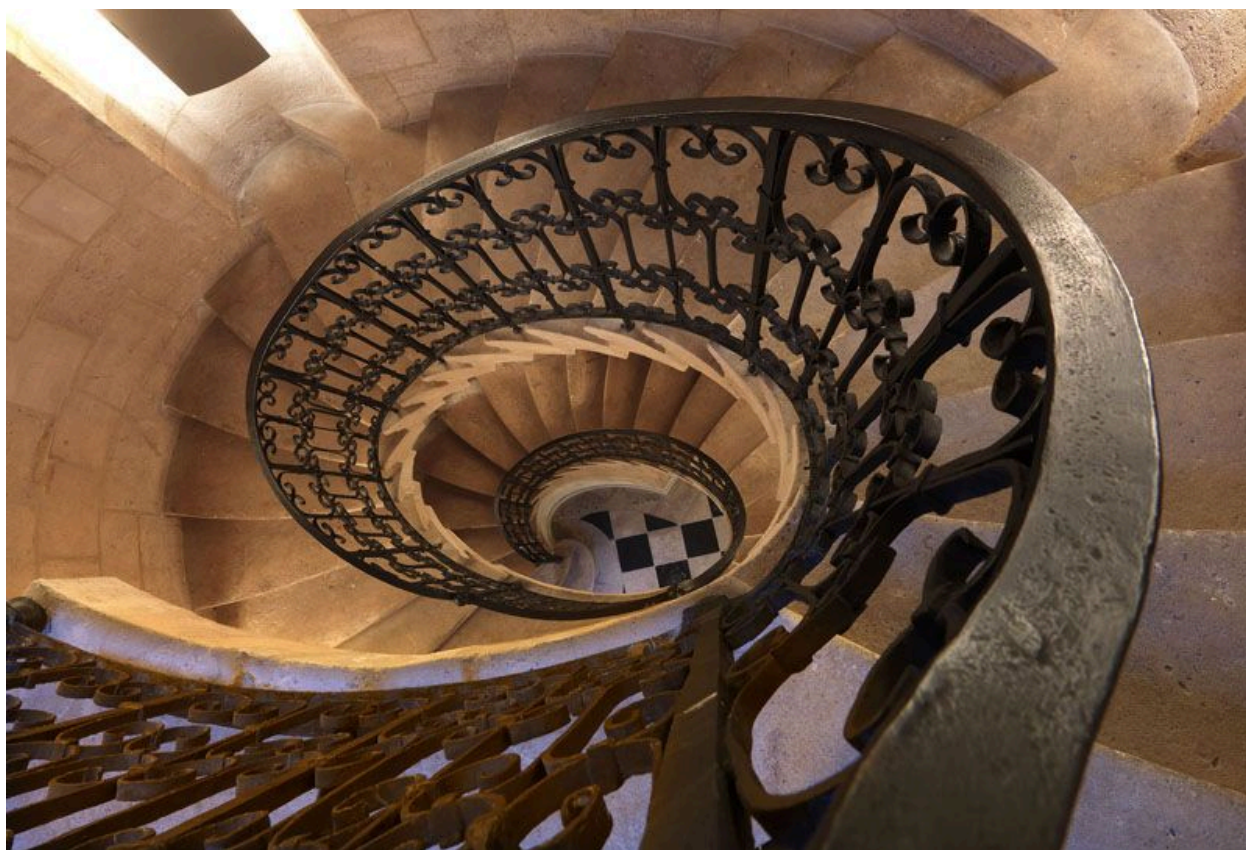
Vue en plongée du vide central de l'escalier de la chapelle.
