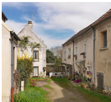
Vue d'ensemble. Phot. Laurent Kruszyk IVR11_20189500074NUC4A
