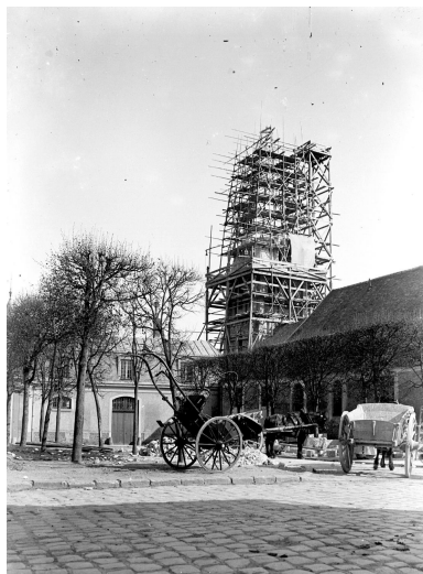
Le clocher échafaudé en 1900. Autr. A. (architecte en chef des monuments historiques) Chaine IVR11_20039101310NUC
