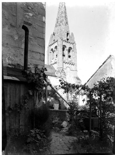
Le clocher avant restauration. Les ouvertures percées dans quatre faces de la flèche portent encore un fronton triangulaire à tympan vide. Autr. Chaine. A. (architecte en chef des monuments historiques) IVR11_20039101314NUC
