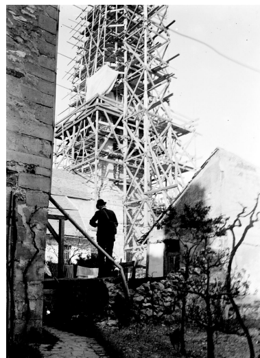
Le clocher échafaudé en 1900, depuis le parc du château. Autr. A. (architecte en chef des monuments historiques) Chaine IVR11_20039101311NUC
