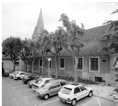
Vue d'ensemble du côté nord de l'église. Phot. Philippe Ayrault IVR11_20029100768X
