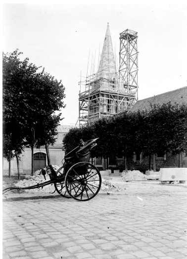
Le clocher échafaudé en 1900, depuis la place de l'église. Autr. A. (architecte en chef des monuments historiques) Chaine IVR11_20039101312NUC
