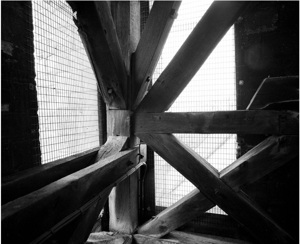
Détail de l'enrayure de la charpente du clocher.
