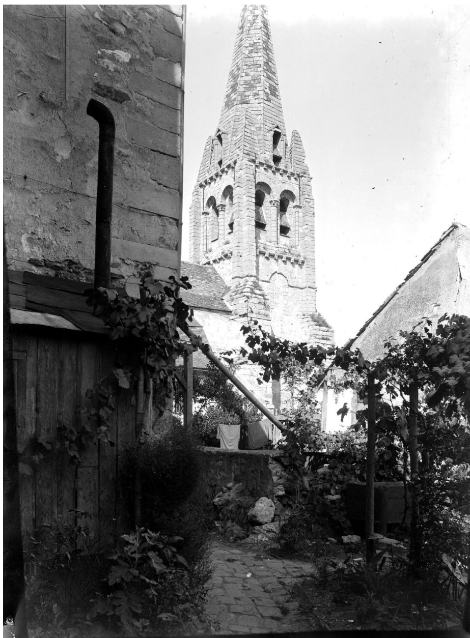
Le clocher avant restauration. Les ouvertures percées dans quatre faces de la flèche portent encore un fronton triangulaire à tympan vide.
