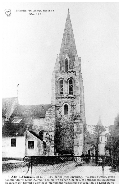
Vue latérale sud du clocher et du chœur. IVR11_20019100151X
