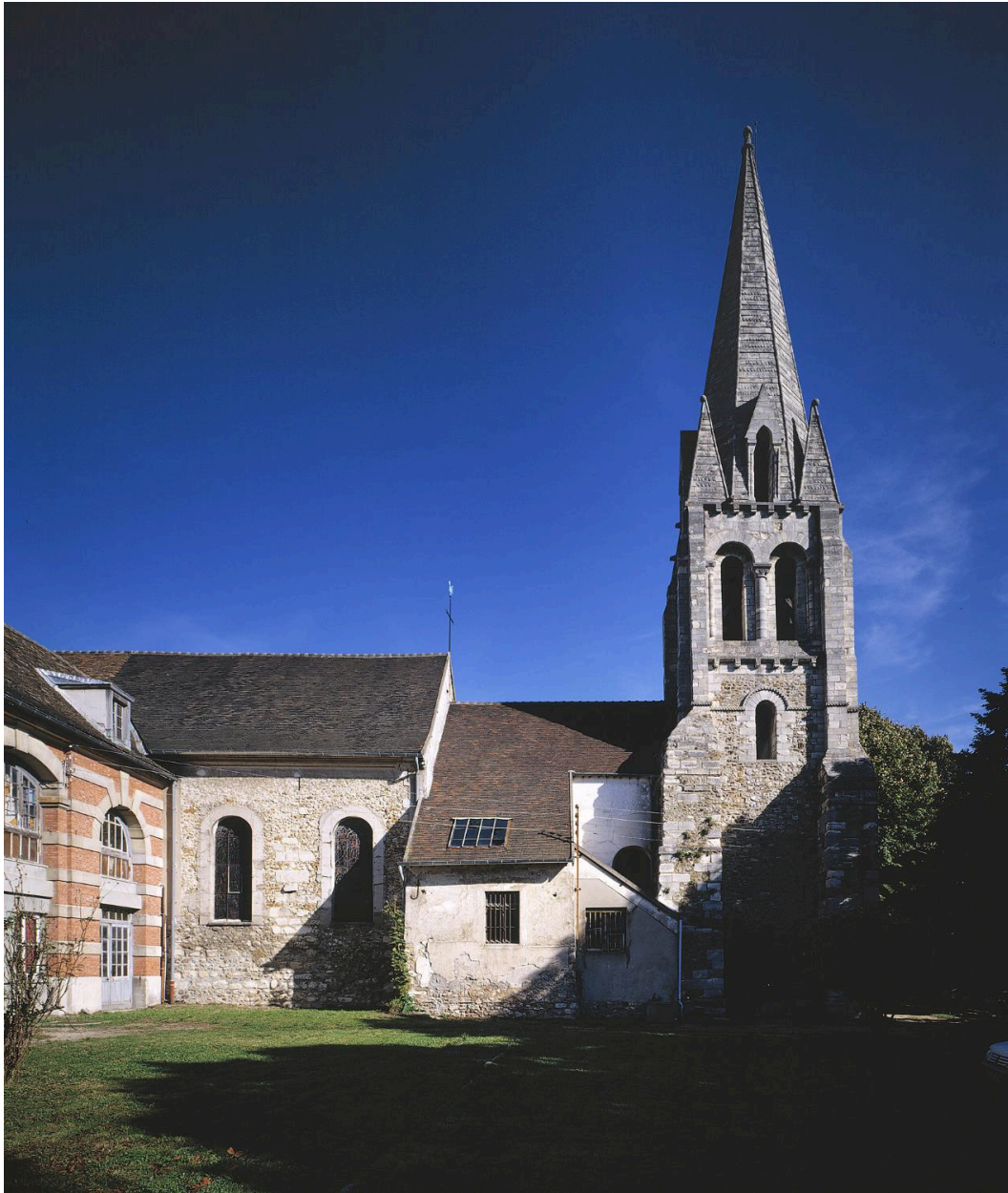
Vue d'ensemble de la façade sud donnant sur le parc du lycée Saint-Charles.
