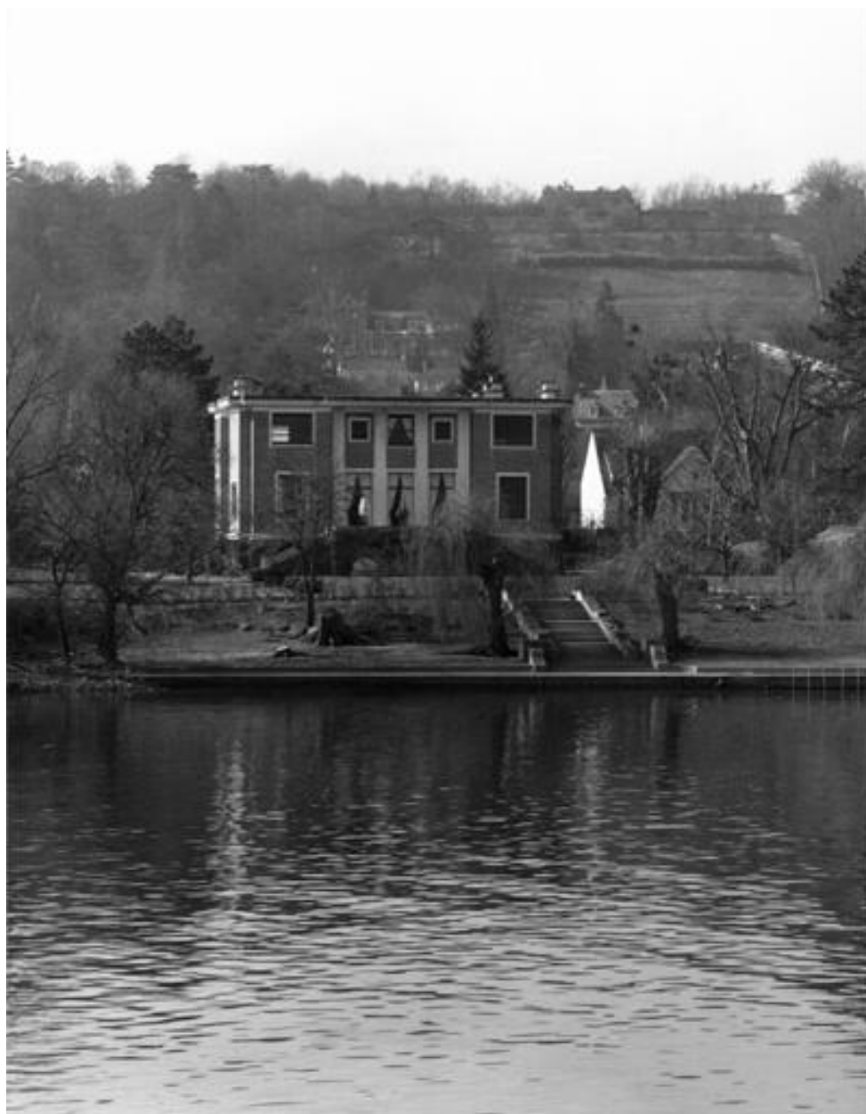
Vue de situation prise depuis la Seine.
