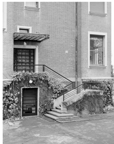
Détail de la façade Ouest : perron et marquise. Phot. Vialles Jean-Bernard IVR11_19927800942X
