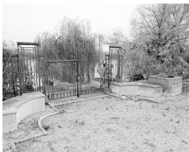
Grille d'accès à l'escalier de l'embarcadère. Phot. Vialles Jean-Bernard IVR11_19927800947X
