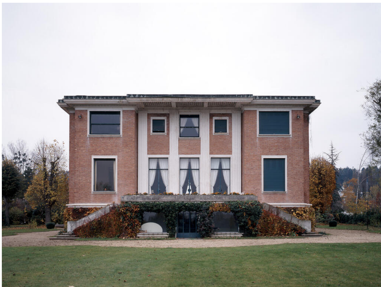
Vue de la façade est (vers la Seine).
