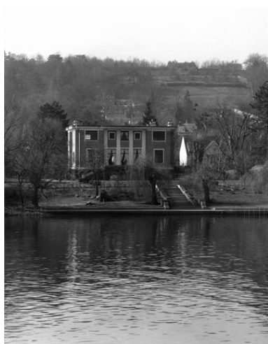
Vue de situation prise depuis la Seine. Phot. Vialles Jean-Bernard IVR11_19937800384X
