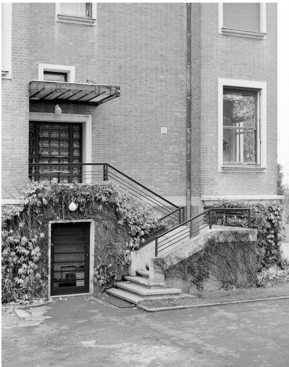
Détail de la façade Ouest : perron et marquise.
