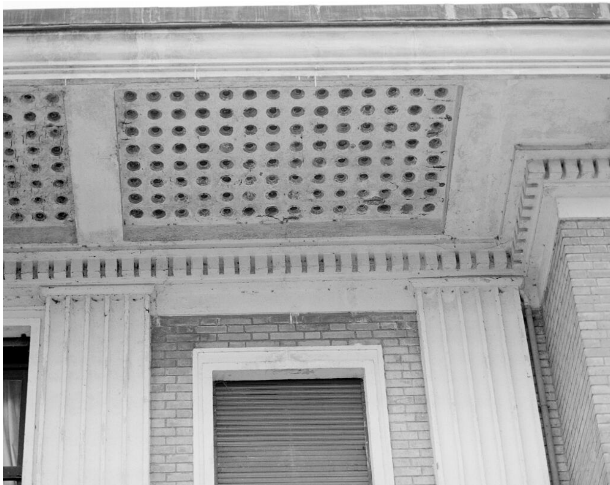
Détail de la façade Est : Modénature et auvent de béton avec petits éléments de verre. Une réfection de la terrasse a supprimé la transparence.
