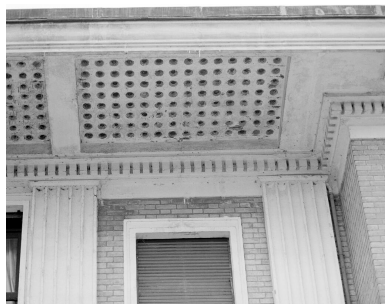
Détail de la façade Est : Modénature et auvent de béton avec petits éléments de verre. Une réfection de la terrasse a supprimé la transparence. Phot. Vialles Jean-Bernard IVR11_19927800943X
