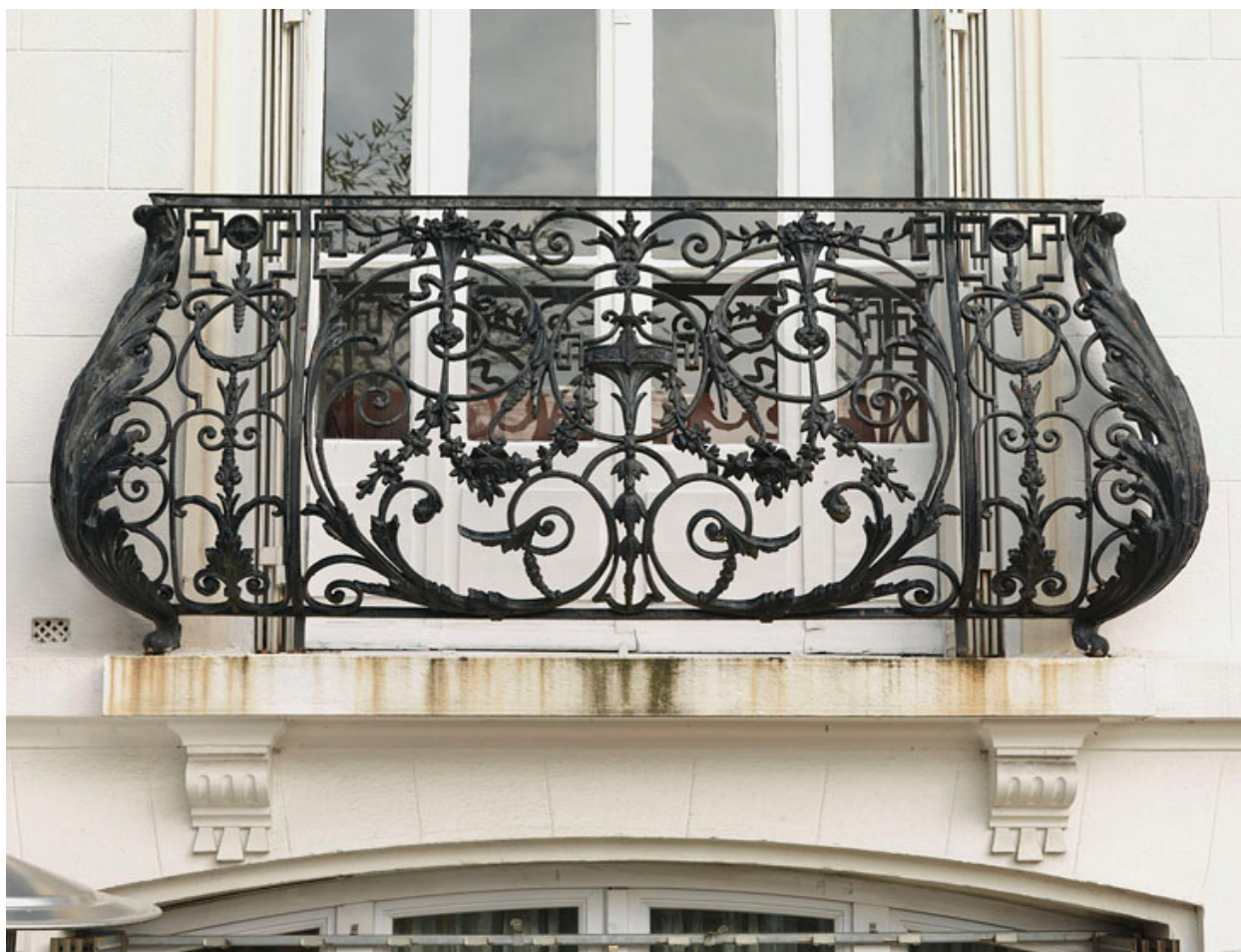
Vue d'ensemble du balcon en ferronnerie, sur la façade latérale donnant sur le boulevard du Lac.
