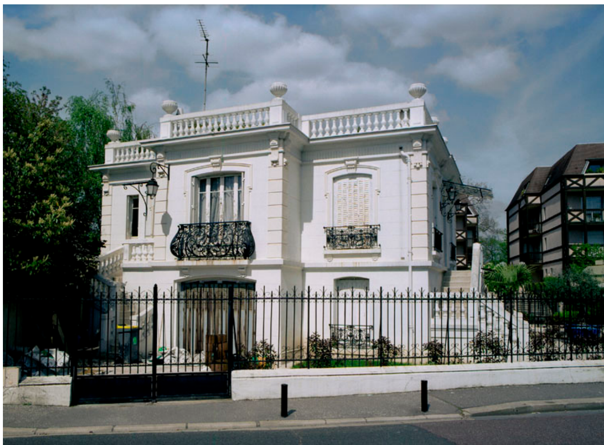
Vue de la façade antérieure donnant sur l'avenue de Ceinture
