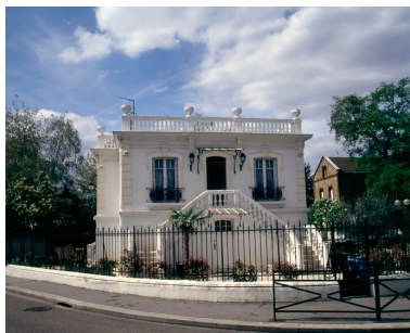
Vue de la façade latérale donnant sur le boulevard du Lac Phot. Jean-Bernard Vialles IVR11_20069500204XA
