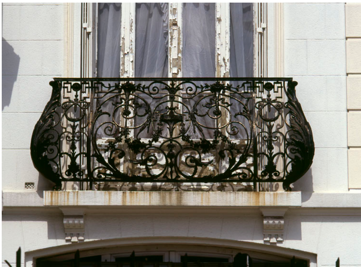
Détail du balcon en ferronnerie de la façade latérale, orné de guirlandes, de vases et de feuillages d'acanthé dans un style néo-dix-huitième siècle.
