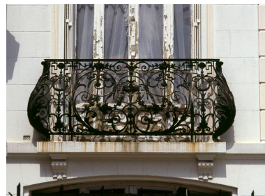
Détail du balcon en ferronnerie de la façade latérale, orné de guirlandes, de vases et de feuillages d'acanthé dans un style néo-dix-huitième siècle. Phot. Jean-Bernard Vialles IVR11_20069500207XA
