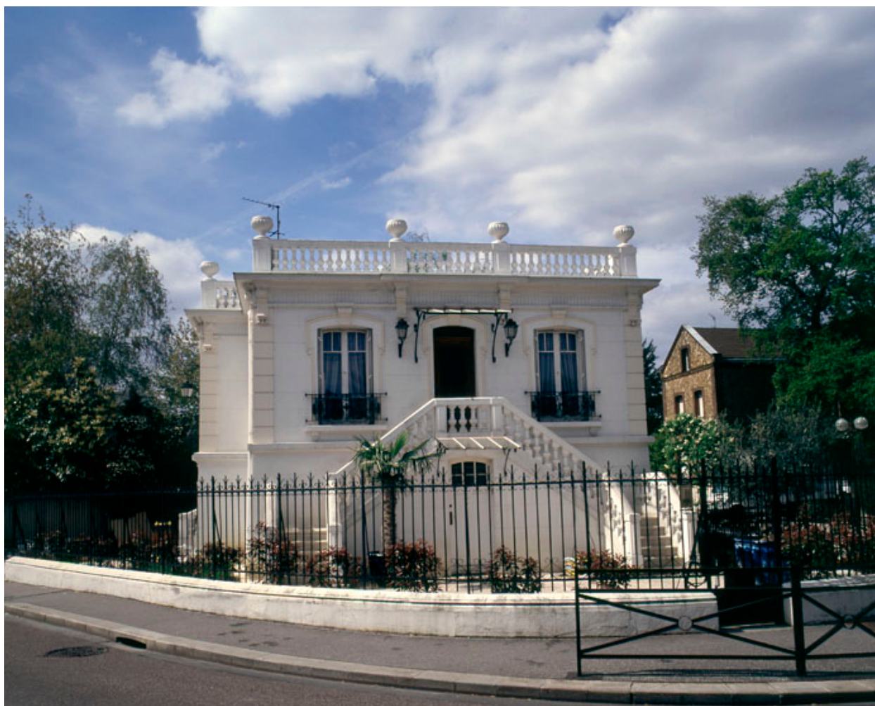
Vue de la façade latérale donnant sur le boulevard du Lac
