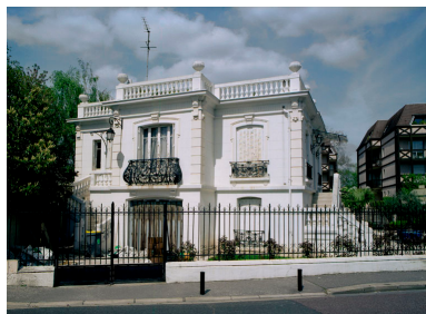
Vue de la façade antérieure donnant sur l'avenue de Ceinture Phot. Jean-Bernard Vialles IVR11_20069500206XE
