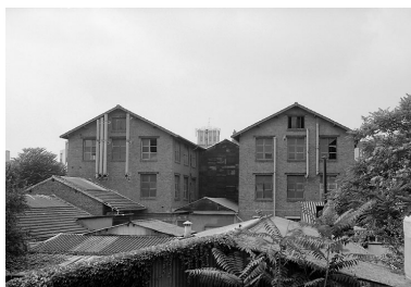
Vue générale depuis la rue Edouard Vaillant. Phot. Jean-Bernard Vialles IVR11_20019300416X
