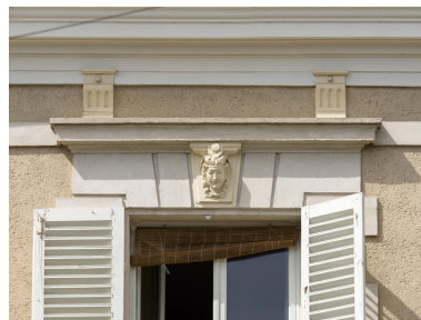
Vue de détail d'une baie de l'étage. Phot. Asseline Stéphane IVR11_20259100586NUC4A
