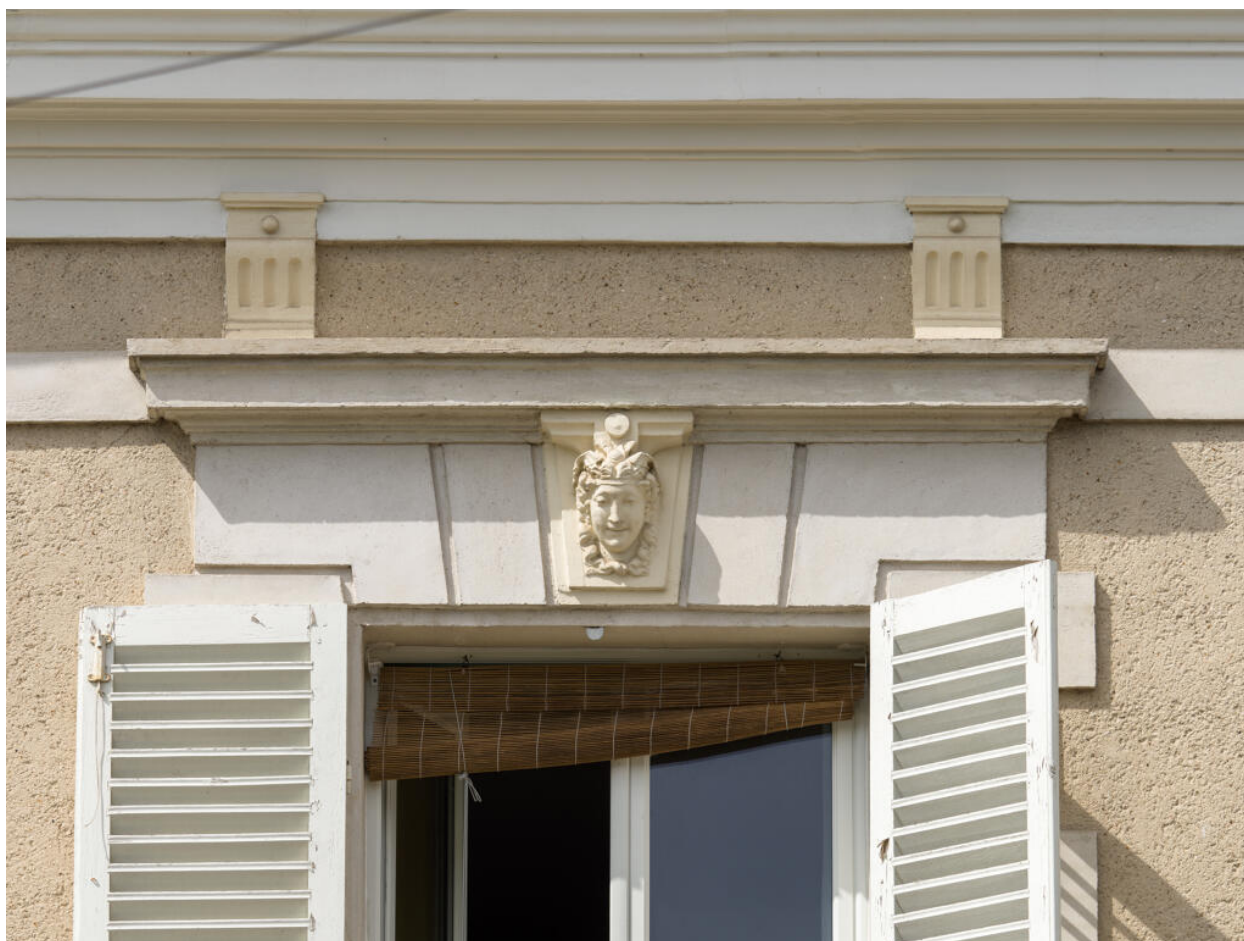
Vue de détail d'une baie de l'étage.
