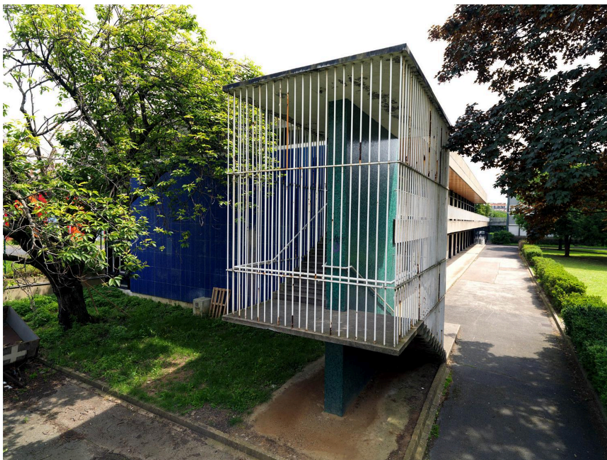
L'escalier du réfectoire avec sa cage toute en transparence.
