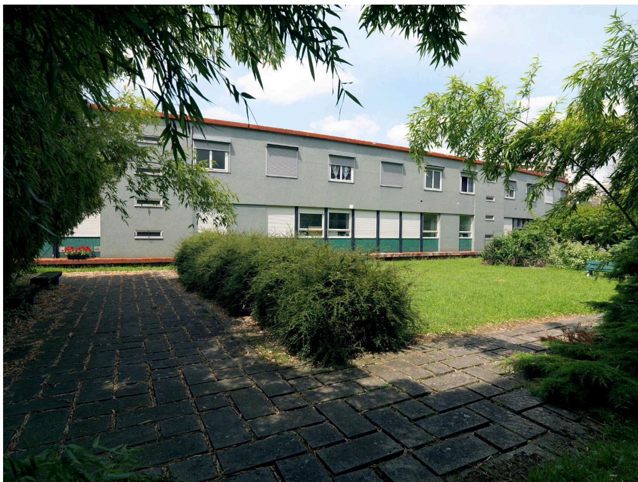
Les bureaux du lycée Paul-Valéry.
