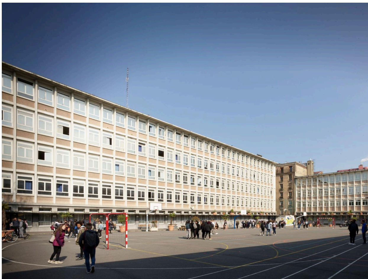
Le lycée Ravel, vue d'ensemble depuis la cour de l'établissement.
