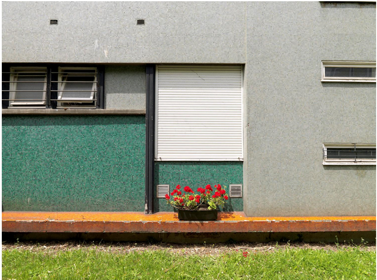
Détail des panneaux de mosaïque sur les façades des bureaux du lycée Paul-Valéry.
