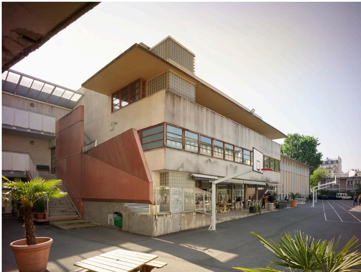
Vue générale du réfectoire, plus tardif que le reste du lycée (1972).
