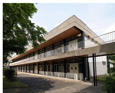
Le bâtiment du réfectoire et des cuisines du lycée Paul-Valéry. Phot. Jean-Bernard Vialles IVR11_20167500712NUC4S
