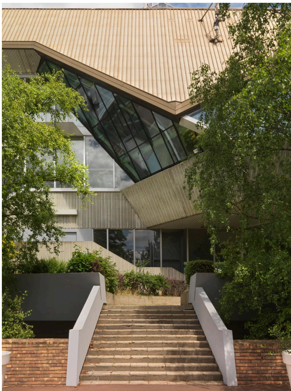
Détail de la tribune depuis l'esplanade sud, avec son esthétique brutaliste mettant en avant le béton strié.
