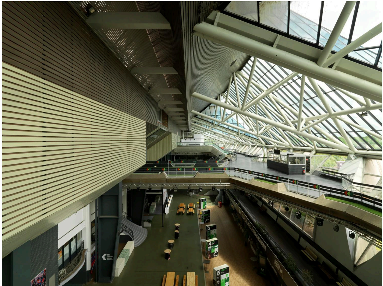
Vue intérieure des tribunes de l'hippodrome avec en contre-bas les accès à la piste et les guichets pour les parieurs.
