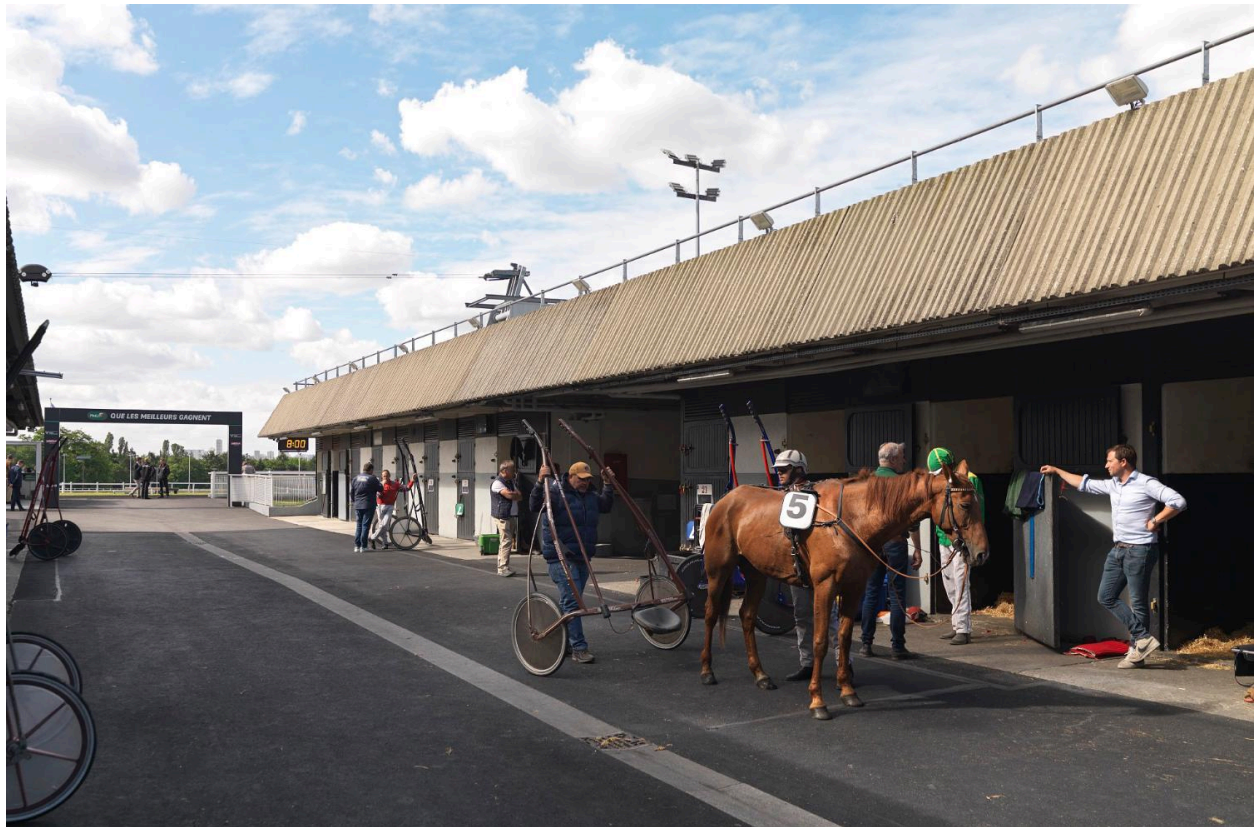
Le quartier des écuries et l'accès aux pistes.
