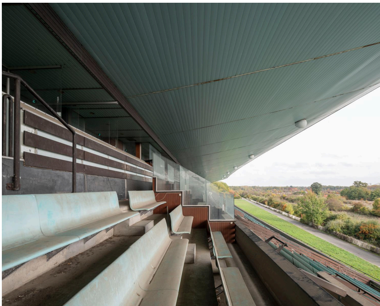
Détail du porte-à-faux de la tribune.
