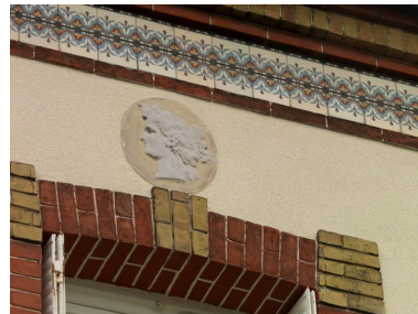
Vue d'un médaillon à buste féminin surplombant la fenêtre droite du premier étage. Phot. Laurent Kruszyk IVR11_20167800632NUC4A
