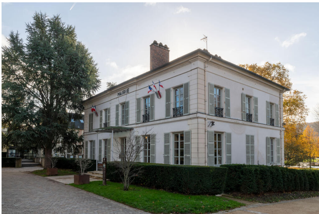
Vue de trois-quarts, façades nord et ouest.
