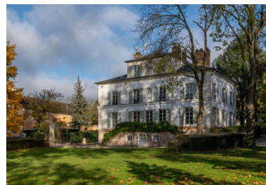
Vue de trois-quart des façades sud et est. IVR11_20239100446NUC4A
