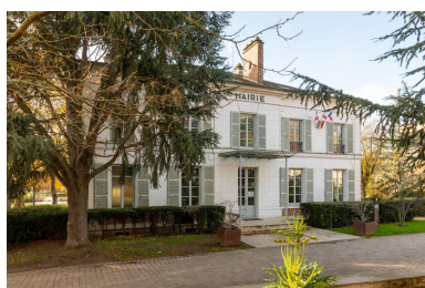
L'entrée se trouve en façade nord, malgré son extrême sobriété. IVR11_20239100448NUC4A
