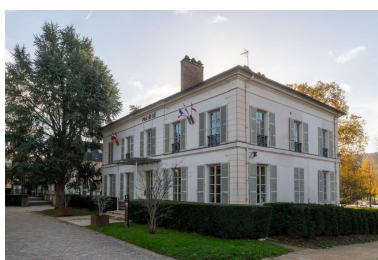
Vue de trois-quarts, façades nord et ouest. IVR11_20239100449NUC4A
