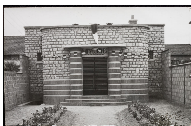
Carte postale montrant l'établissement de bains-douches au moment de l'inauguration (Coll. particulière). IVR11_20269100250NUC4A
