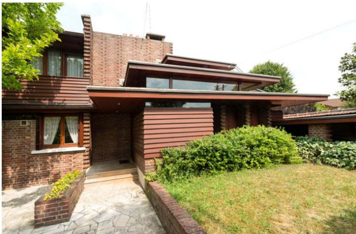
Vue générale de la façade principale.
