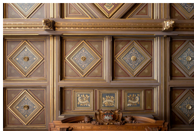
Détail du plafond à caissons. Phot. Laurent Kruszyk IVR11_20157500166NUC4A
