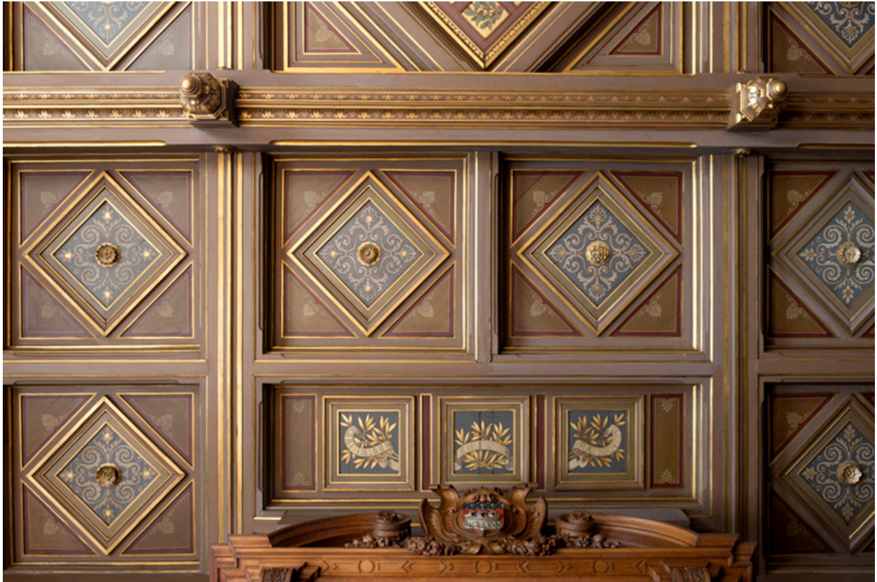
Détail du plafond à caissons.
