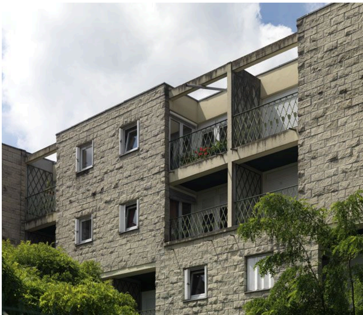
Vue rapprochée d'un des bâtiments, détail de la composition géométrique des quatre loggias.
