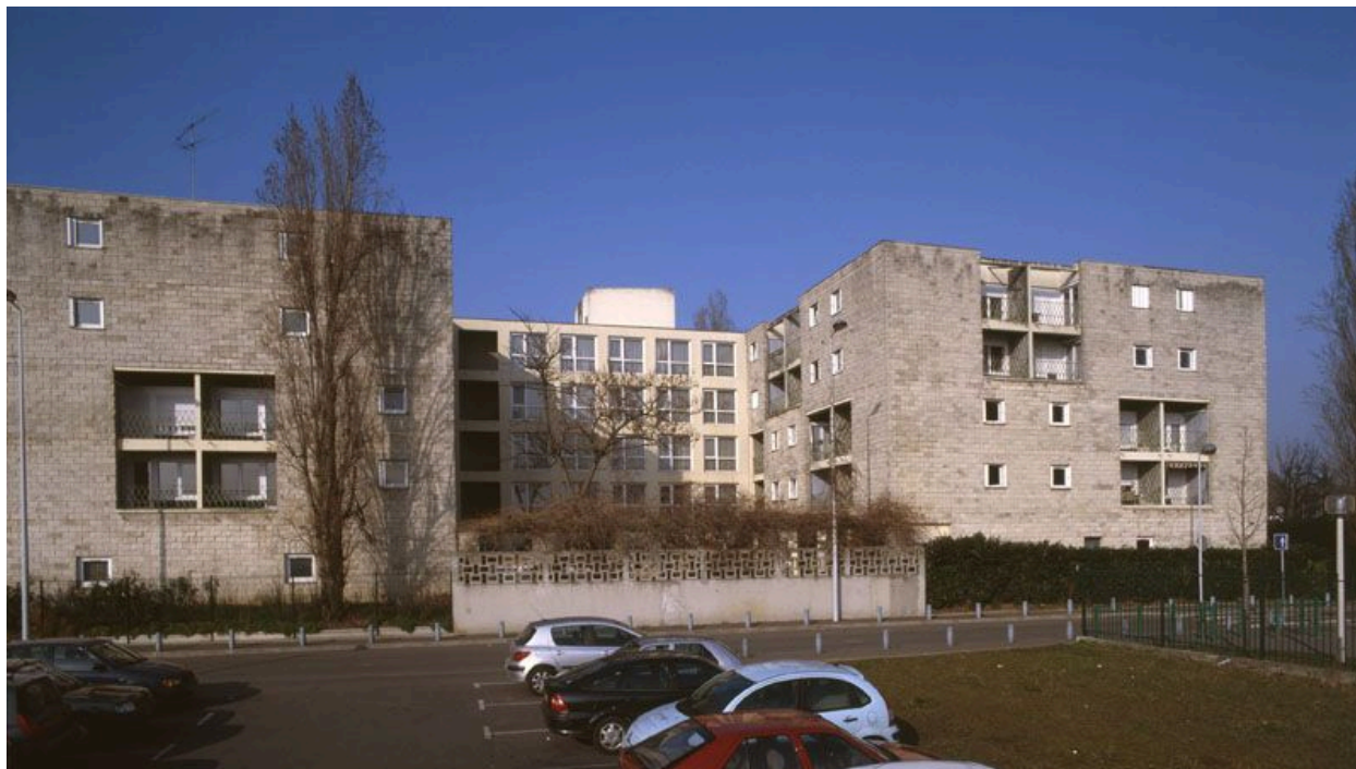
Vue d'ensemble depuis la rue.
