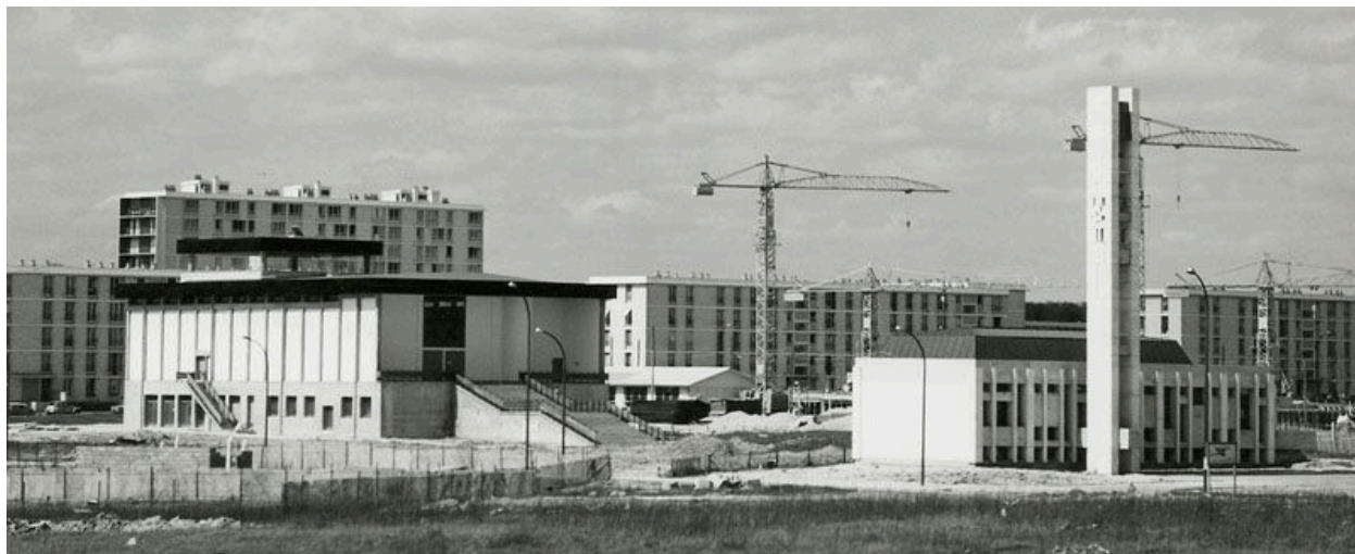
Les chantiers de construction des églises Saint-Paul et Saint-Marc. Photographie. (AM Le Havre, fonds Le Donné, 337W 20)
