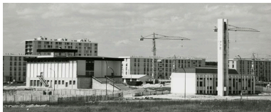
Les chantiers de construction des églises Saint-Paul et Saint-Marc. Photographie. (AM Le Havre, fonds Le Donné, 337W 20) Phot. Archives municipales du Havre, Autr. Yves Guillemaut IVR11_20109100173NUC1AB
