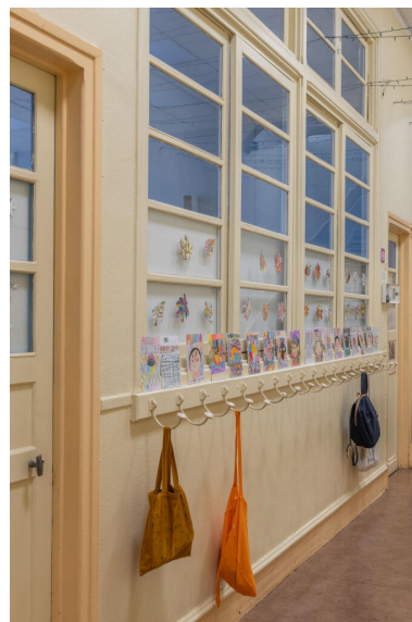
École des Coteaux, bâtiment de 1938, fenêtre de second-jour d'une classe Phot. Kruszyk Laurent IVR11_20249200947NUC4A
