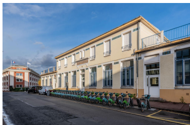
École des Coteaux, bâtiment de 1922, façade ouest Phot. Kruszyk Laurent IVR11_20249200963NUC4A
