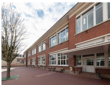
École des Coteaux, bâtiment de 1938, façade est Phot. Kruszyk Laurent IVR11_20249200939NUC4A
