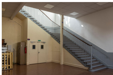
École des Coteaux, bâtiment de 1938, escalier principal Phot. Kruszyk Laurent IVR11_20249200945NUC4A
