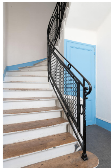
École des Coteaux, bâtiment de 1922, départ de l'escalier conduisant aux appartements de fonction Phot. Kruszyk Laurent IVR11_20249200960NUC4A
