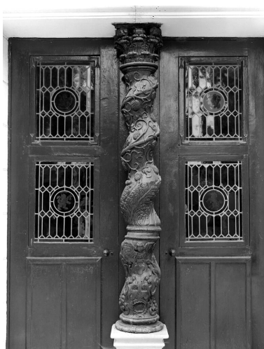
Détail de l'une des deux portes du rez-de-chaussée. D'impressionnantes colonnes torsées en bois sculpté séparent les deux battants. Au nombre de quatre, ces colonnes pourraient provenir d'une église avec leur décor sculpté de pampres en partie supérieure, angelot et coquille saint Jacques en partie inférieure. D'une seule pièce, elles sont surmontées d'un chapiteau corinthien. Phot. Décamps Christian IVR11_19849400893X
