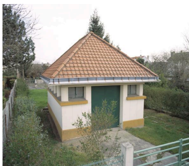
Vue d'ensemble de la station de pompage située 38, avenue du 18 Avril. Phot. Philippe Ayrault IVR11_20029100389XA
