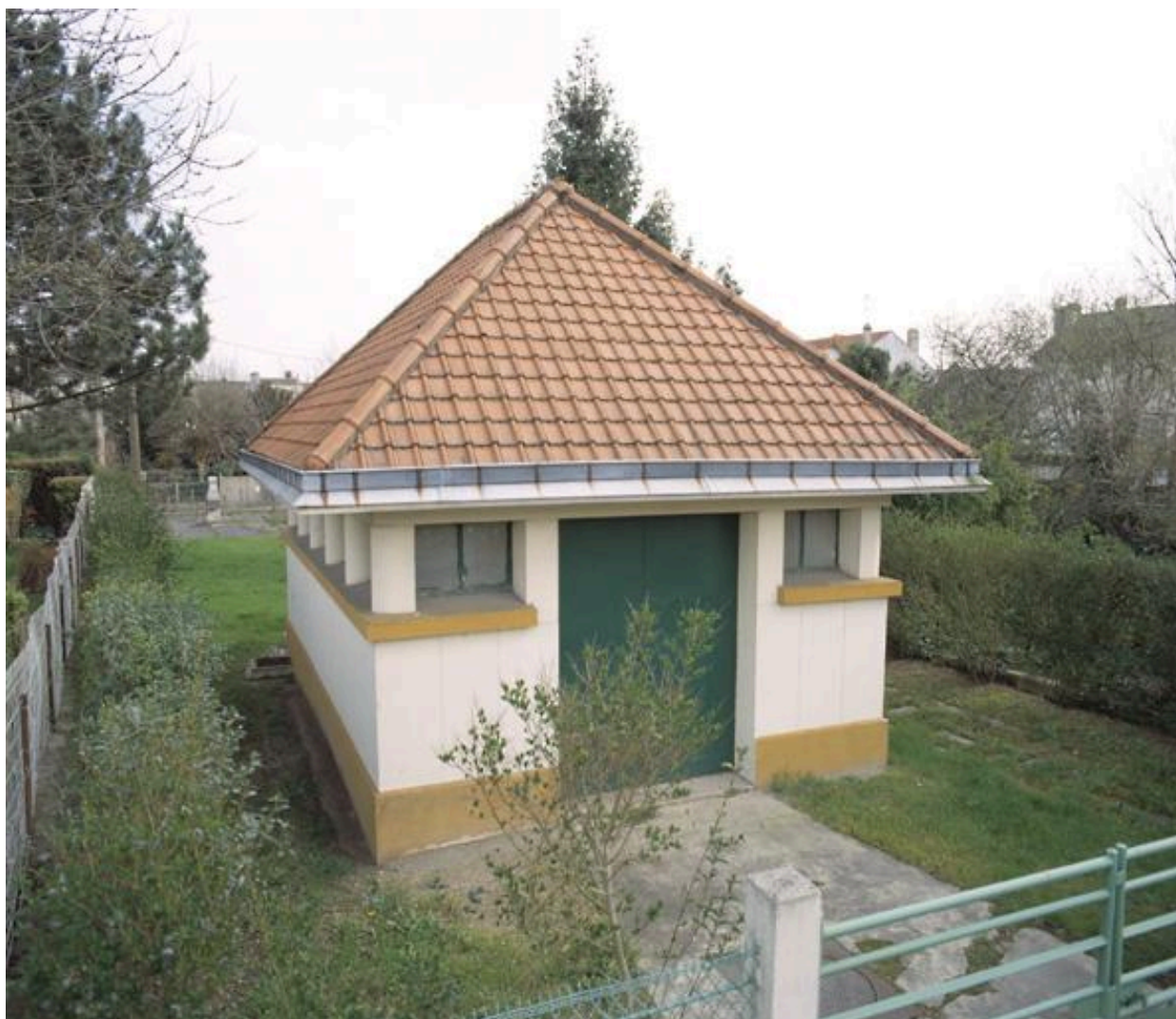
Vue d'ensemble de la station de pompage située 38, avenue du 18 Avril.
