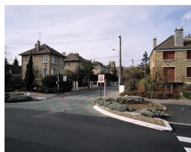
Vue perspective de la rue du Docteur Calmette. Phot. Philippe Ayrault IVR11_20029101644XA
