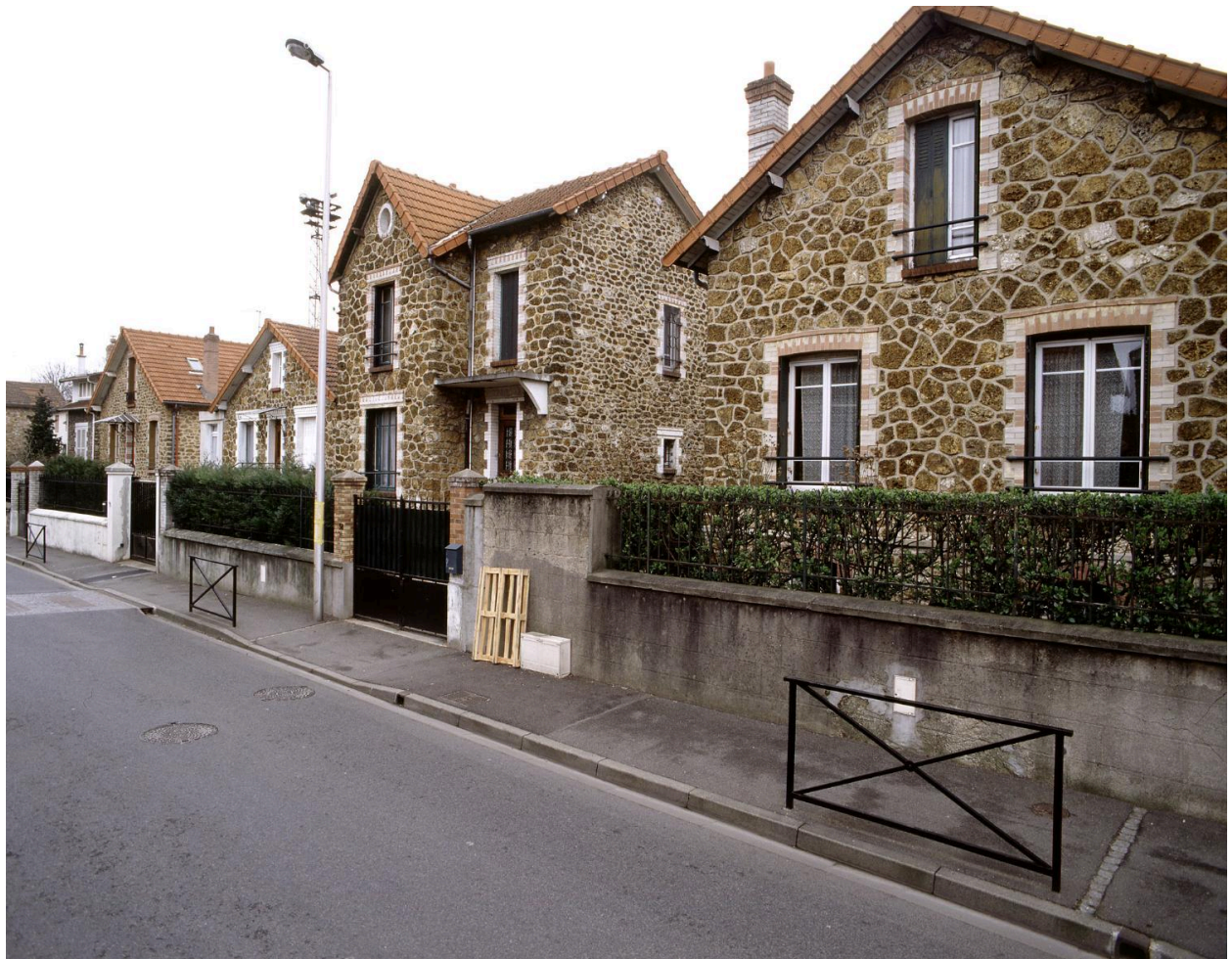
Ensemble de pavillons (36bis à 40, rue de Juvisy) ayant survécu au bombardement du 18 avril 1944.
