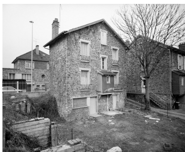
Vue prise à l'arrière de la maison située 8, rue de Juvisy : elle montre la différence de hauteur entre les zones surélevées par l'apport de remblais et le niveau d'origine ; à gauche, murets de soutènement des remblais.
