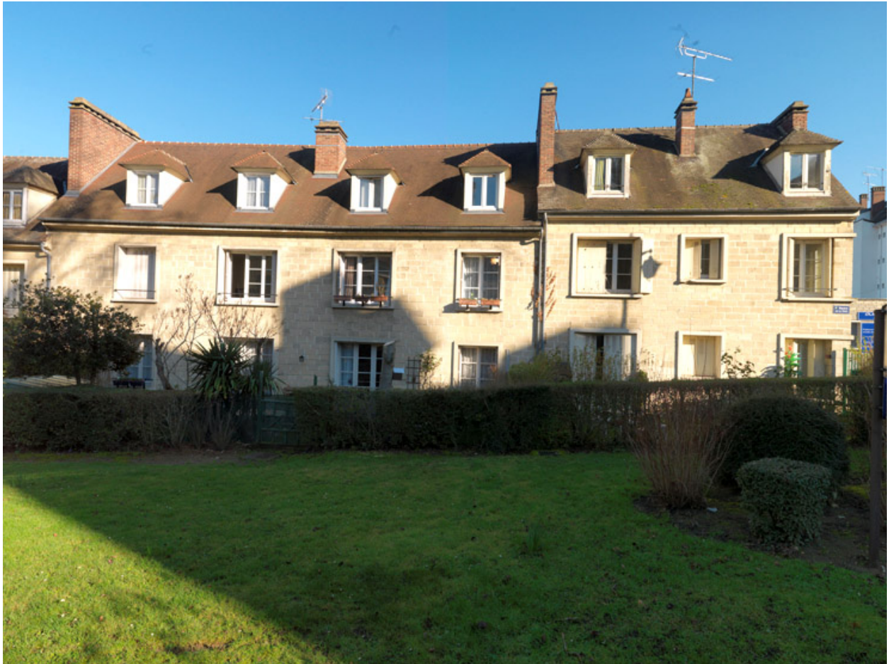
Les façades arrière des maisons de la rue Louis Cauzard.
