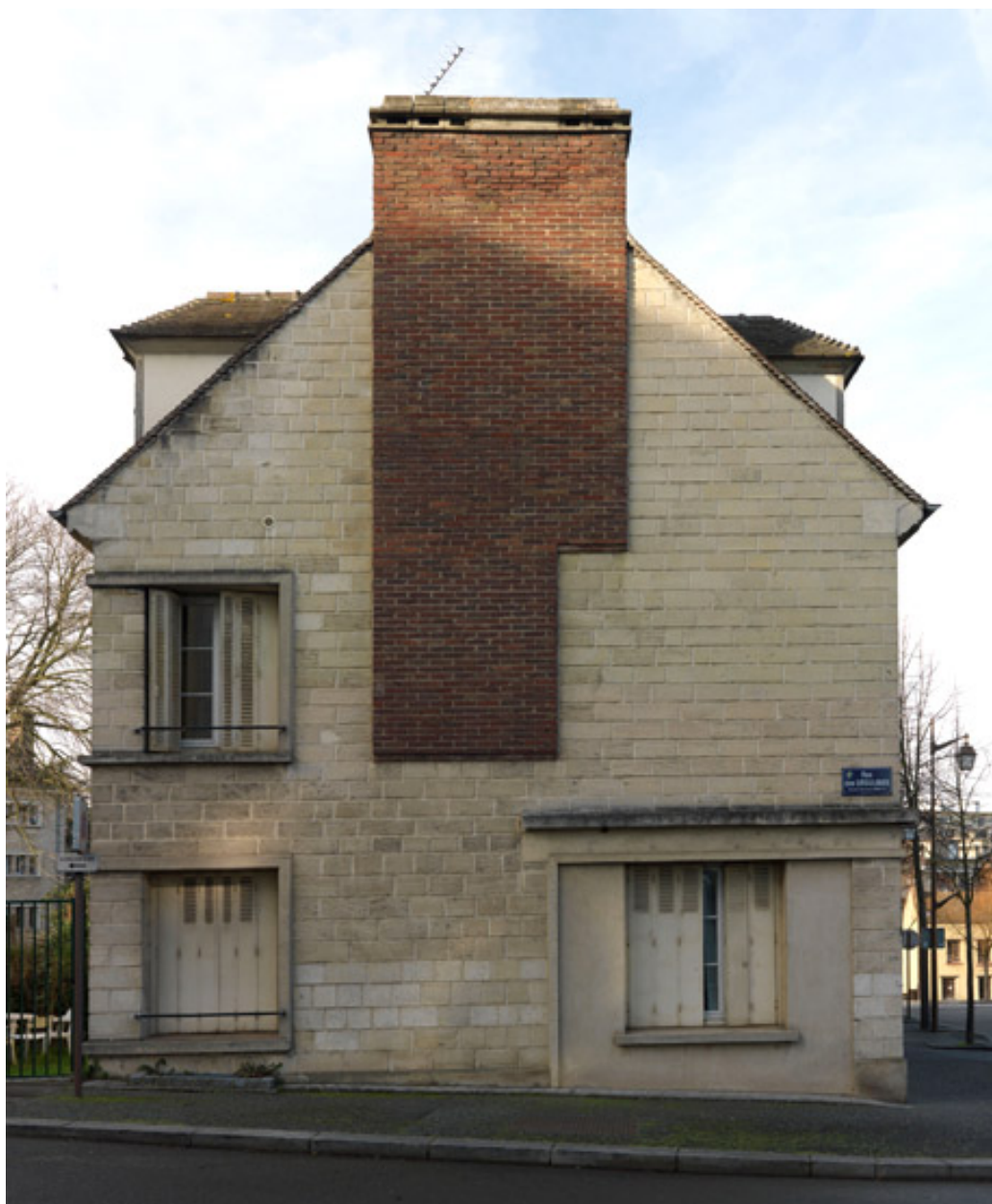
Le pignon de la première maison, rue Louis Cauzard et sa cheminée de brique.
