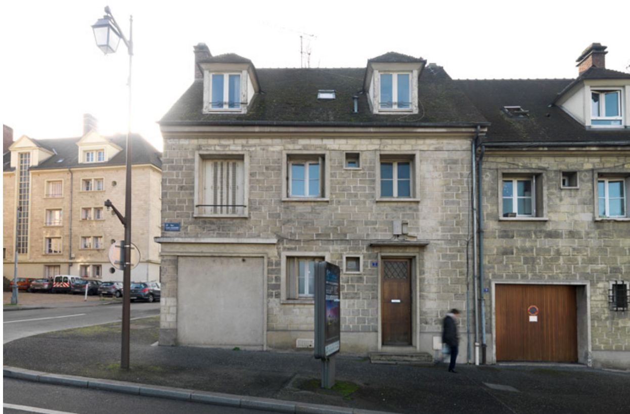
Façade sur rue de la maison de la première maison de bourg, 7, rue Louis Cauzard. La boutique au rez-de-chaussée a été supprimée.
