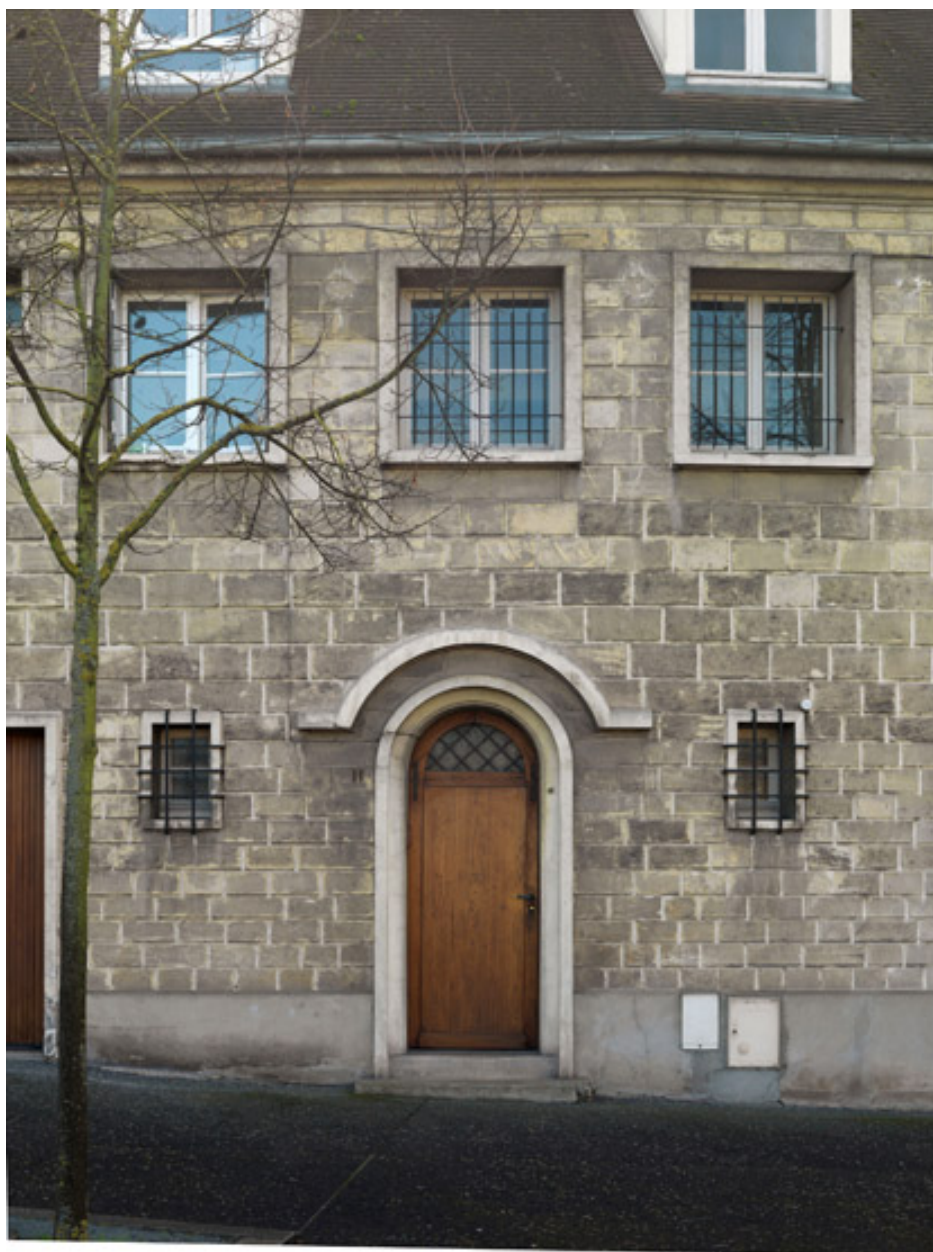
Détail de la porte d'entrée du 11, rue Louis Cauzard. Le décor, très sobre, se concentre sur les moulures entourant les baies.
