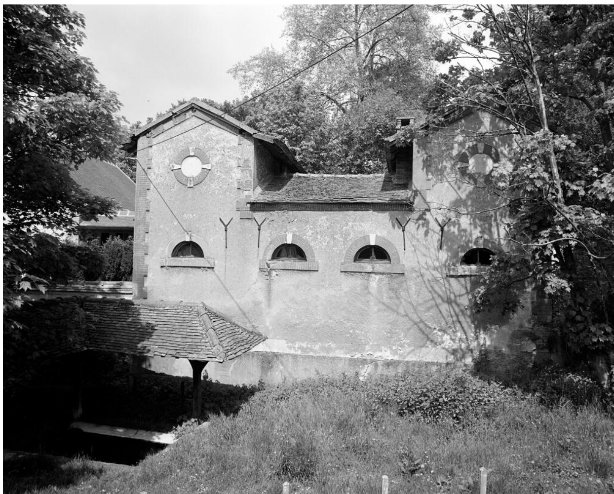
Façade postérieure de la bergerie.
