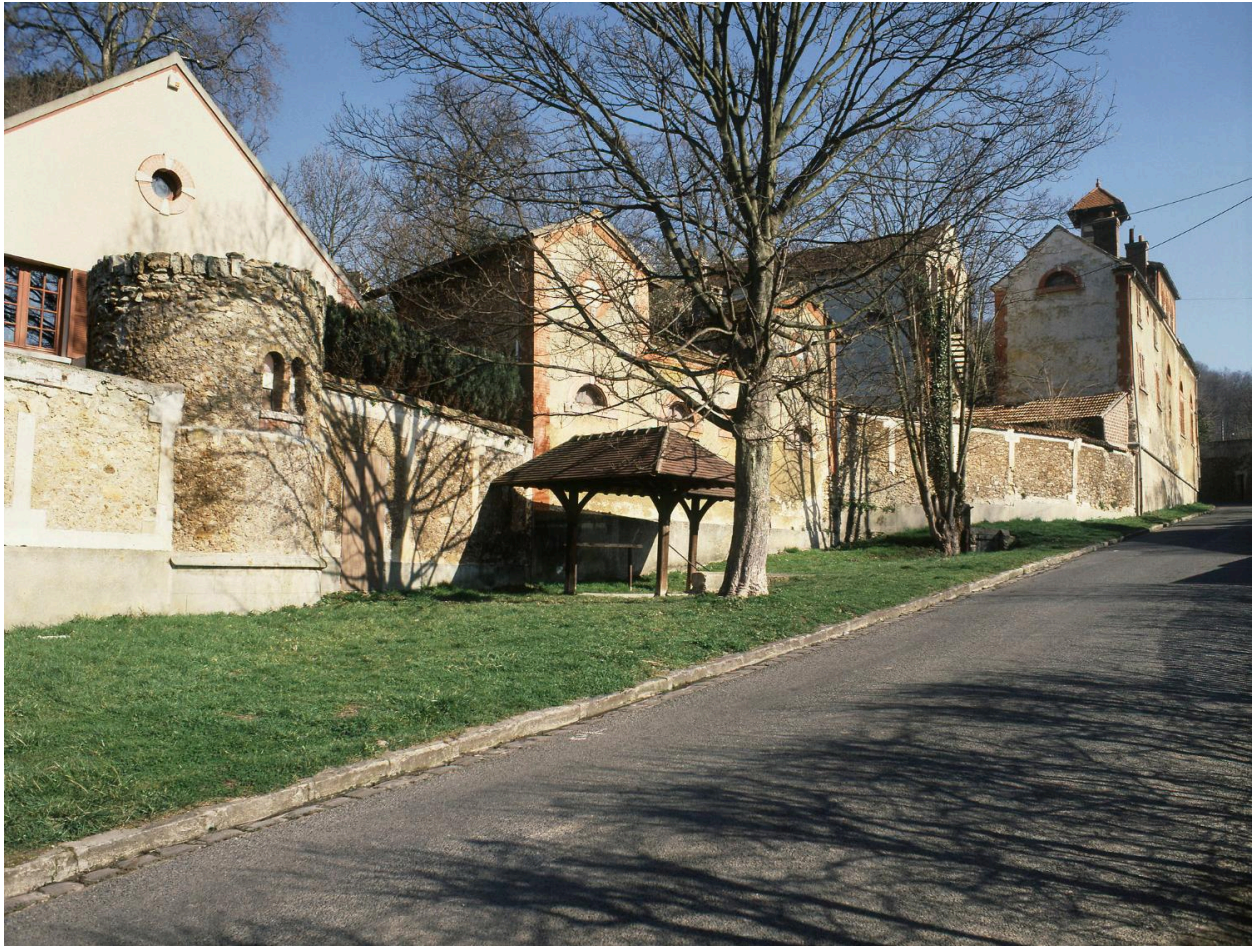
Les communs vus depuis la rue de Vauboyen.
