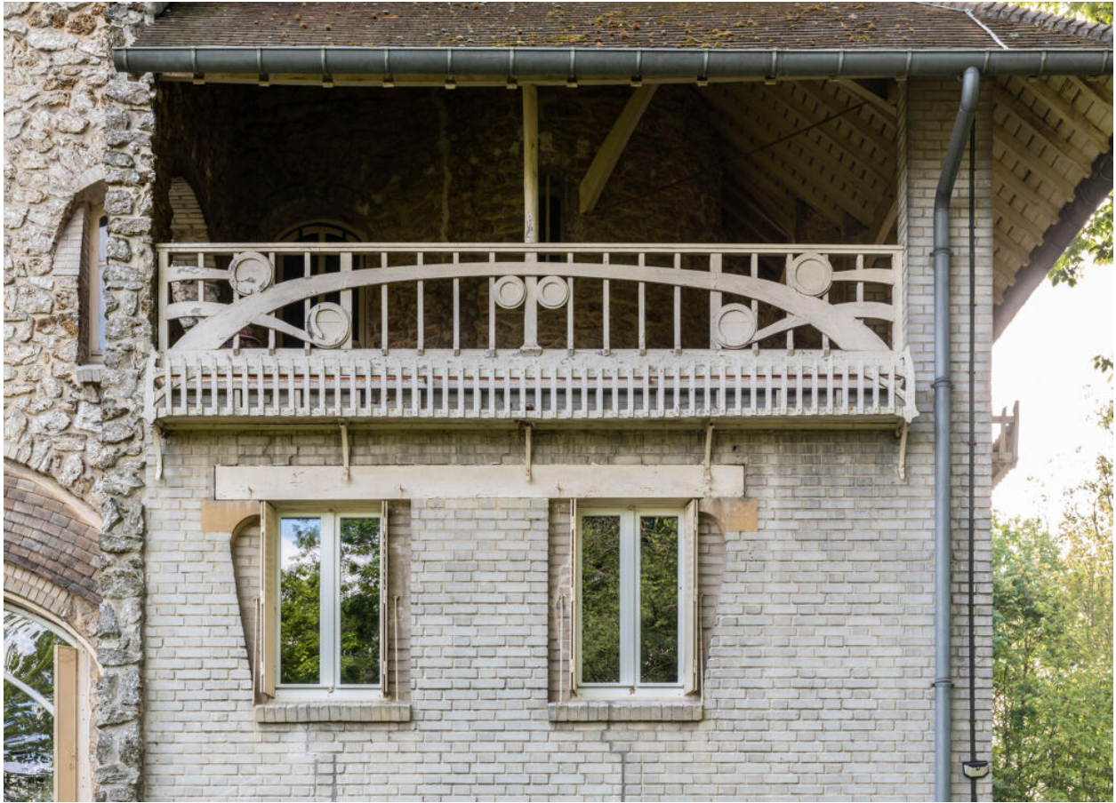
Détail du balcon. Le garde-corps est en bois comme dans les villas balnéaires de Guimard.
