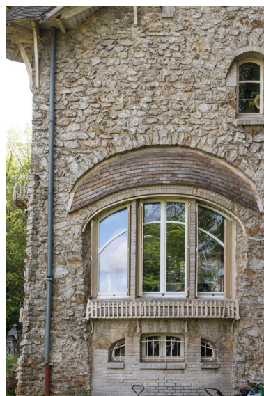
Détail de fenêtres de la façade ouest.
