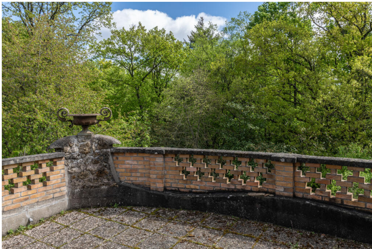
Le balcon de la façade est. La balustrade est en brique et s'élève au-dessus d'une vague en béton.
