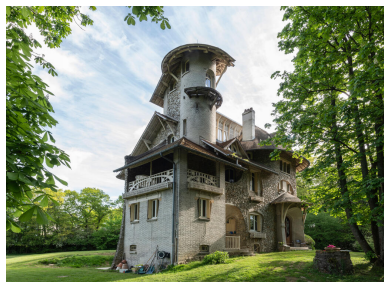
L'angle sud-ouest. La tourelle abritant un belvédère lui vaut sa dénomination de castel.
