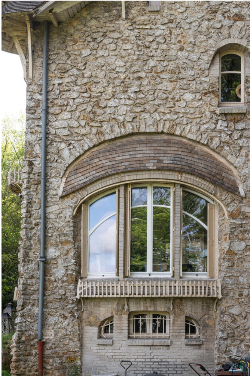
Détail de fenêtres de la façade ouest. Un toit arrondi est placé au-dessus des fenêtres et semble sortir du mur.
