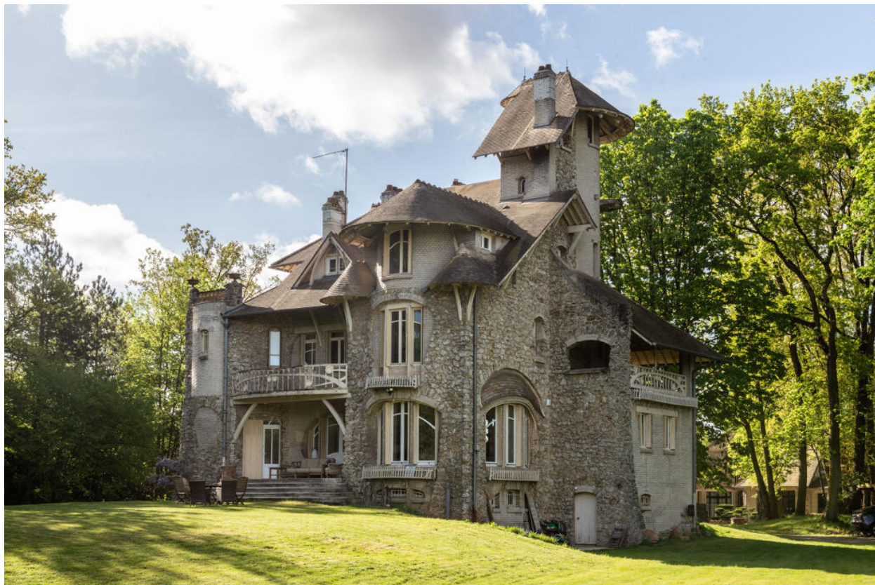
Vue des façades nord et ouest.
