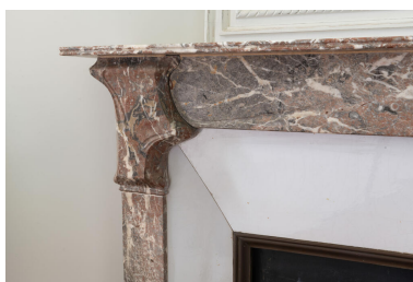
Cheminée d'une chambre de l'étage. Détail de la pénétration du jambage dans le linteau.
