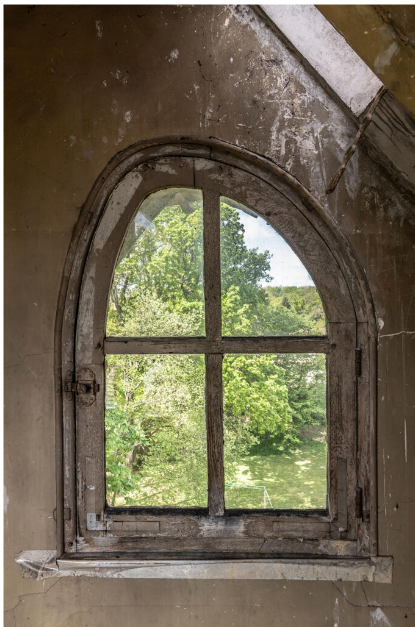
Fenestron en biais dans le belvédère.
