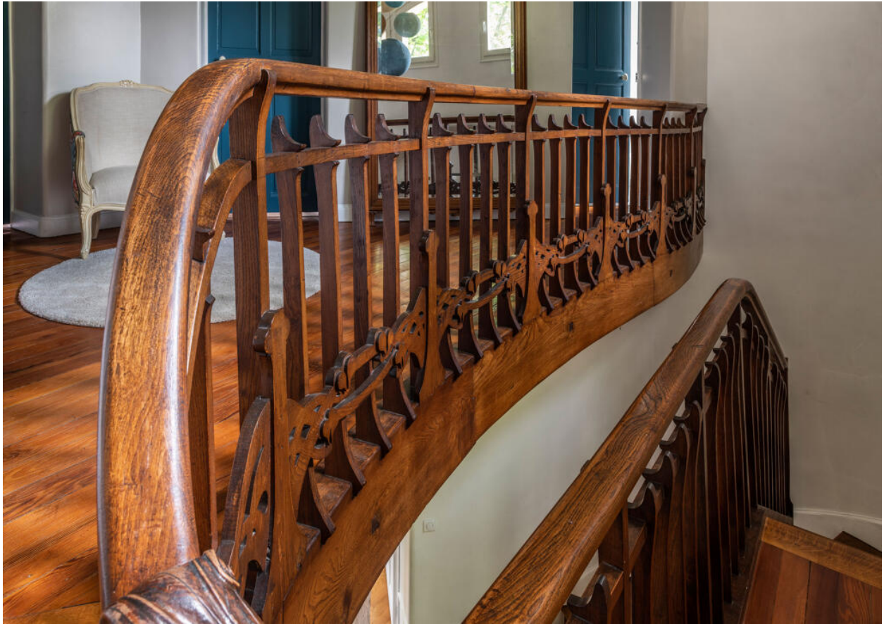
Détail du garde-corps du palier du premier étage.
