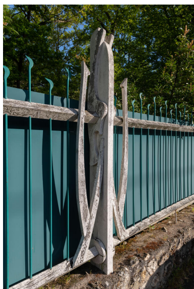
Détail de la clôture sur la rue. Phot. Kruszyk Laurent IVR11_20249100006NUC4A
