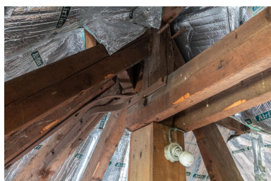
Détail de la charpente du belvédère. Phot. Kruszyk Laurent IVR11_20249100059NUC4A
