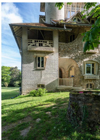
L'avant-corps de la façade sud. L'usage de la brique et la forme rectangulaire contrastent avec la pierre meulière et les formes arrondies du corps principal.
