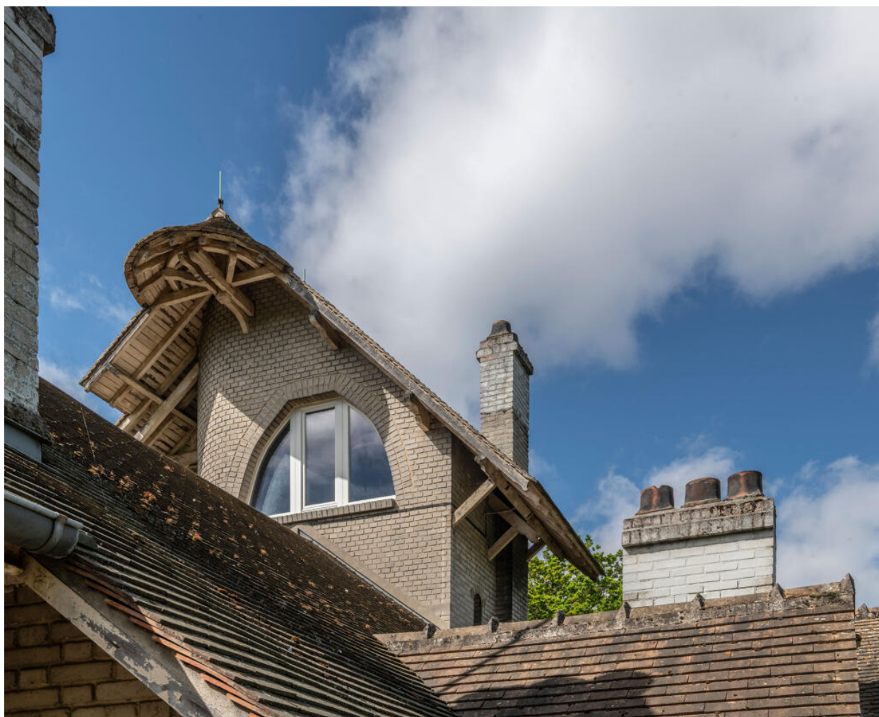
Détail de la tourelle vue de l'ouest.
