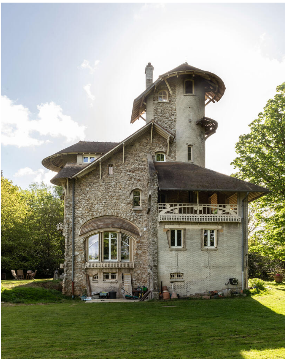
Vue de la façade ouest. Elle semble divisée en deux par la juxtaposition de la brique claire et de la pierre meulière.
