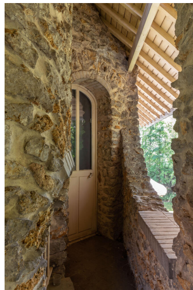
Recoin de balcon en façade sud.
