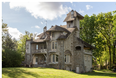
Vue des façades nord et ouest. Phot. Kruszyk Laurent IVR11_20249100030NUC4A
