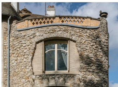
Détail d'une fenêtre et de la balustrade de brique de la façade est. Phot. Kruszyk Laurent IVR11_20249100033NUC4A
