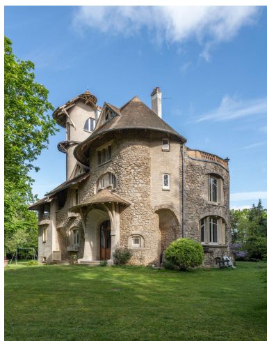
La façade antérieure, à gauche, orientée vers le sud, et la façade latérale est, à droite. L'arrondi des murs permet une continuité entre les plans. Phot. Kruszyk Laurent IVR11_20249100015NUC4A
