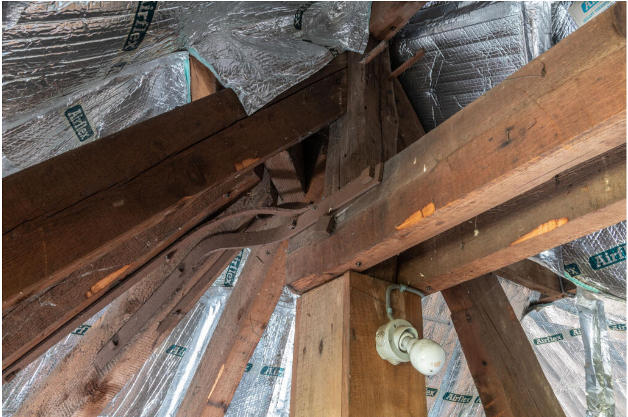
Détail de la charpente du belvédère.
