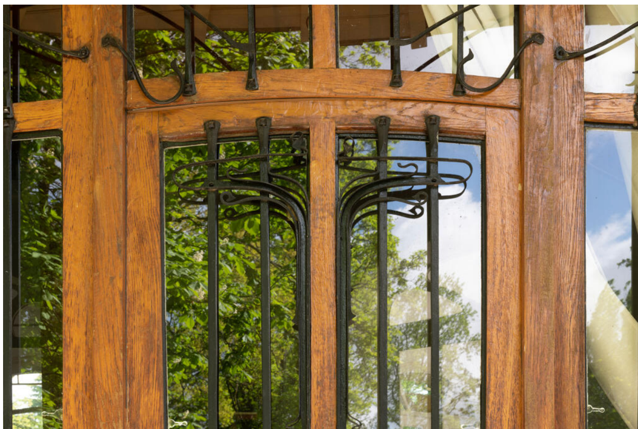
Détail de la ferronnerie de la porte d'entrée avec des arabesques.
