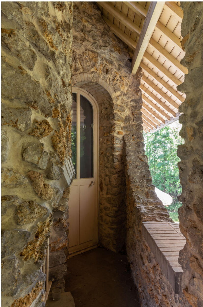
Recoin de balcon en façade sud.
