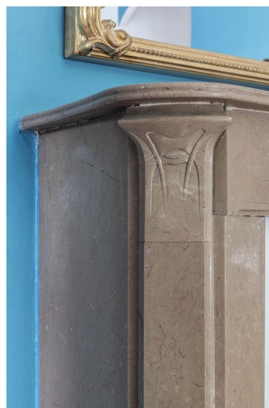
Détail d'un jambage de cheminée, dans une chambre du premier étage.
