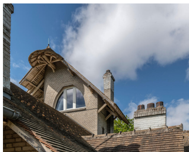
Détail de la tourelle vue de l'ouest. Phot. Kruszyk Laurent IVR11_20249100034NUC4A
