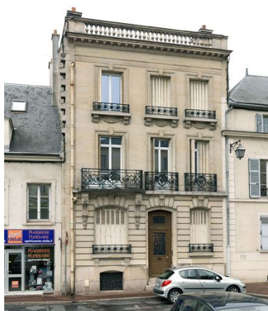
Vue d'ensemble, depuis la place. Phot. Jean-Bernard Vialles IVR11_20147700333NUC4A
