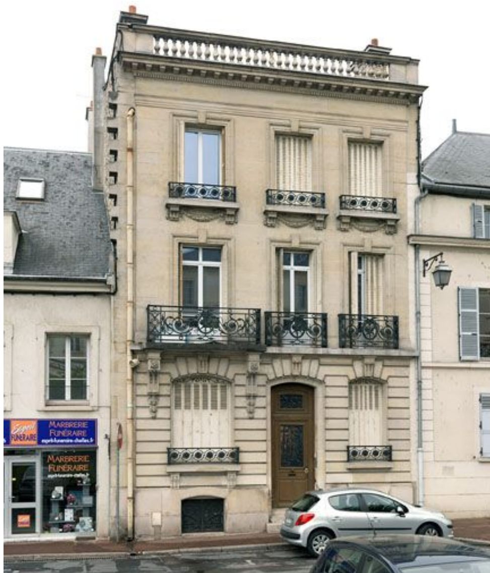
Vue d'ensemble, depuis la place.
