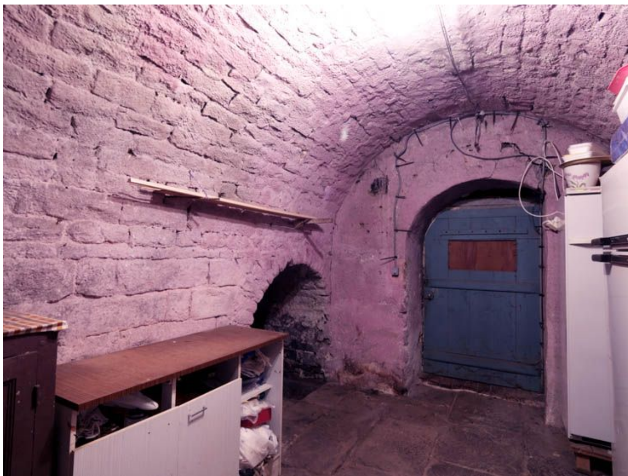
Pièce voûtée, depuis le sud.
