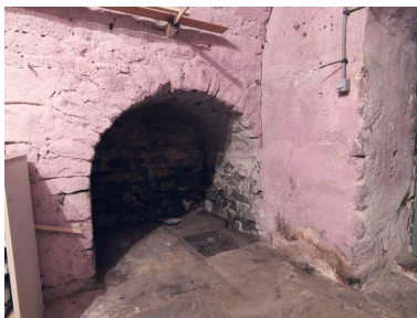
Niche voûtée, ménagée dans le mur occidental de la pièce. Phot. Chloé Bazaud IVR11_20097700336NUC4A
