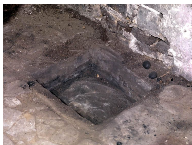
Détail du sol de la niche occidentale, creusé et cimenté après l'abandon de la production de plâtre. Phot. Chloé Bazaud IVR11_20097700338NUC4A
