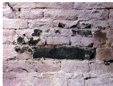
Détail de la maçonnerie, sous l'enduit récent, les moellons de grès sont recouverts de suie. Phot. Chloé Bazaud IVR11_20097700339NUC4A
