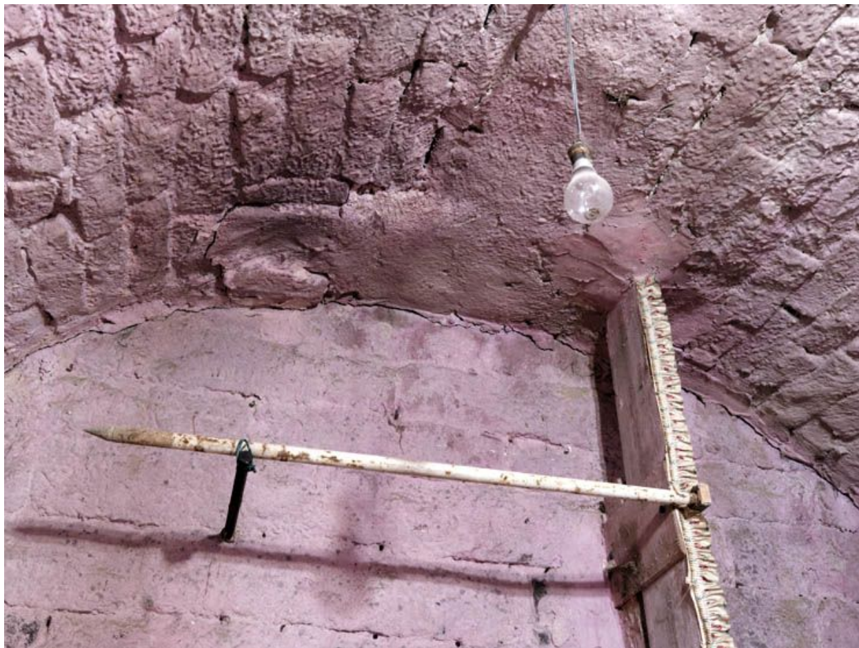
Détail de la voûte, à cet endroit remaniée, peut-être pour boucher un ancien conduit de cheminée.
