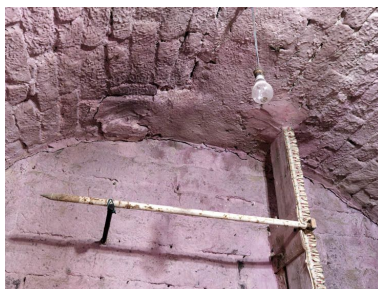
Détail de la voûte, à cet endroit remaniée, peut-être pour boucher un ancien conduit de cheminée. Phot. Chloé Bazaud IVR11_20097700333NUC4A
