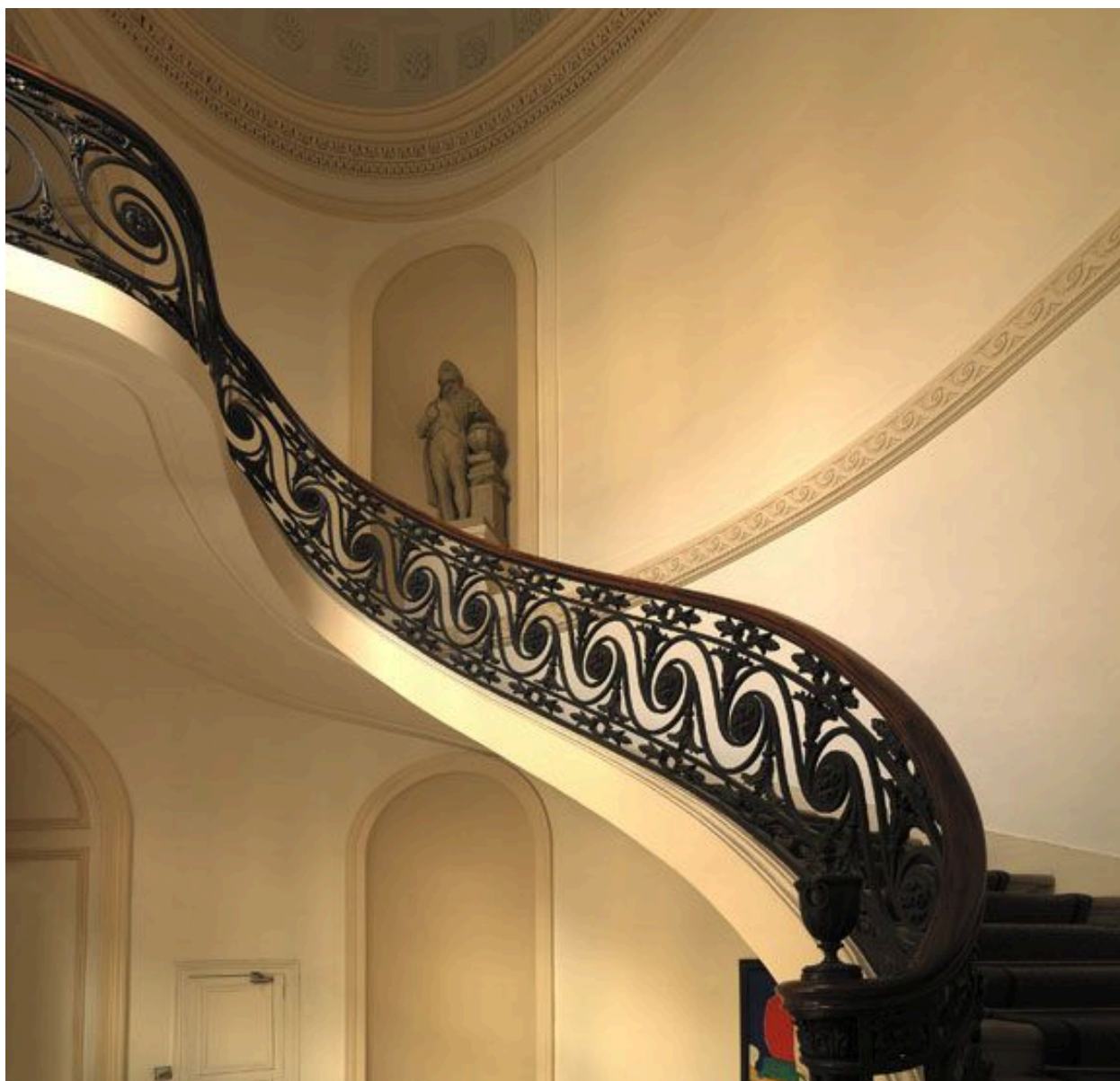
Vue d'ensemble de la rampe.
