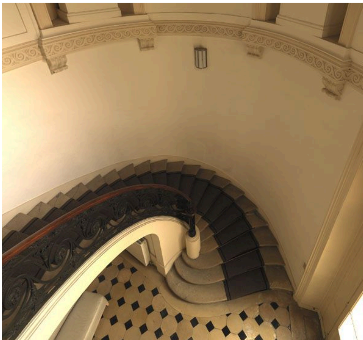
Partie de l'escalier en plongée.
