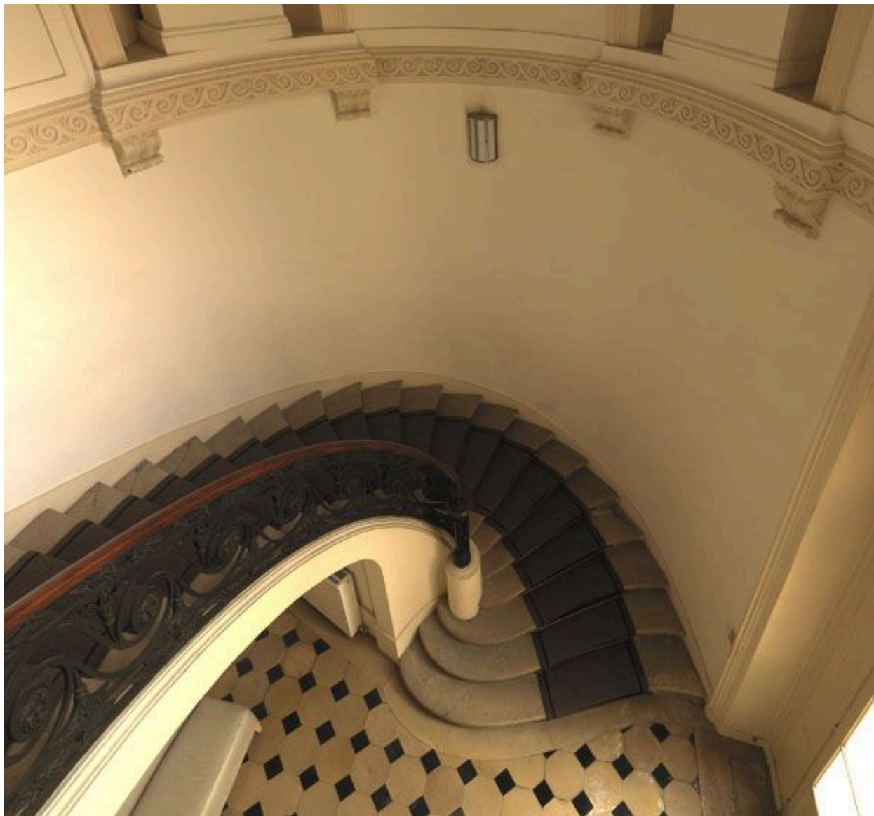
Partie de l'escalier en plongée.
