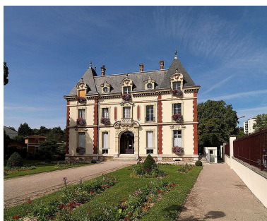
Vue de la façade, depuis le nord-est. Phot. Jean-Bernard Vialles IVR11_20137700234NUC4A
