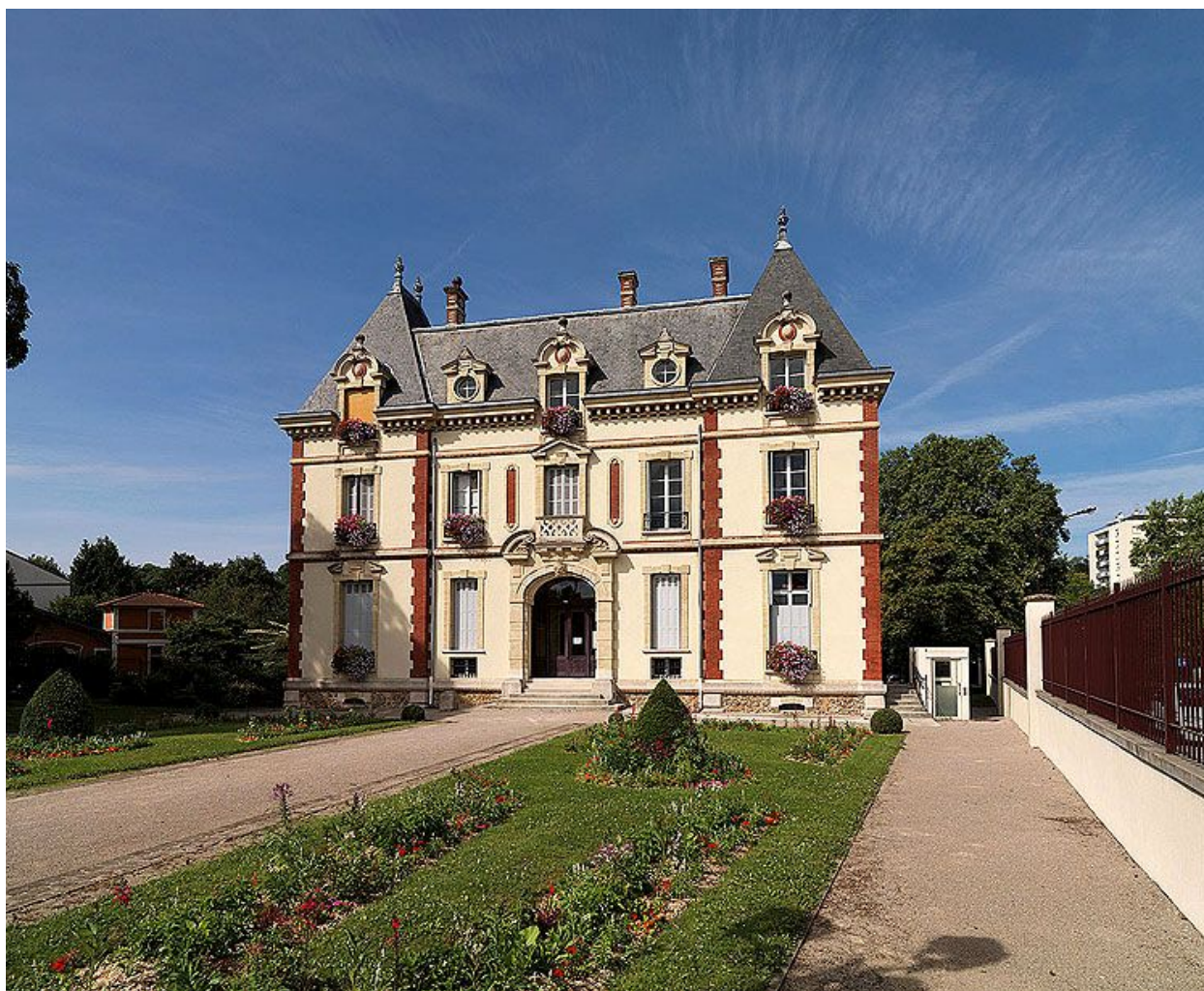
Vue de la façade, depuis le nord-est.
