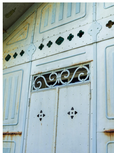
Détail d'une porte fenêtre en façade latérale.
