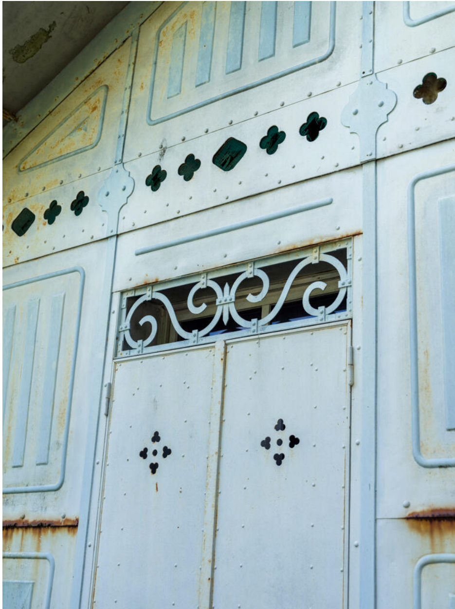
Détail d'une porte fenêtre en façade latérale.
