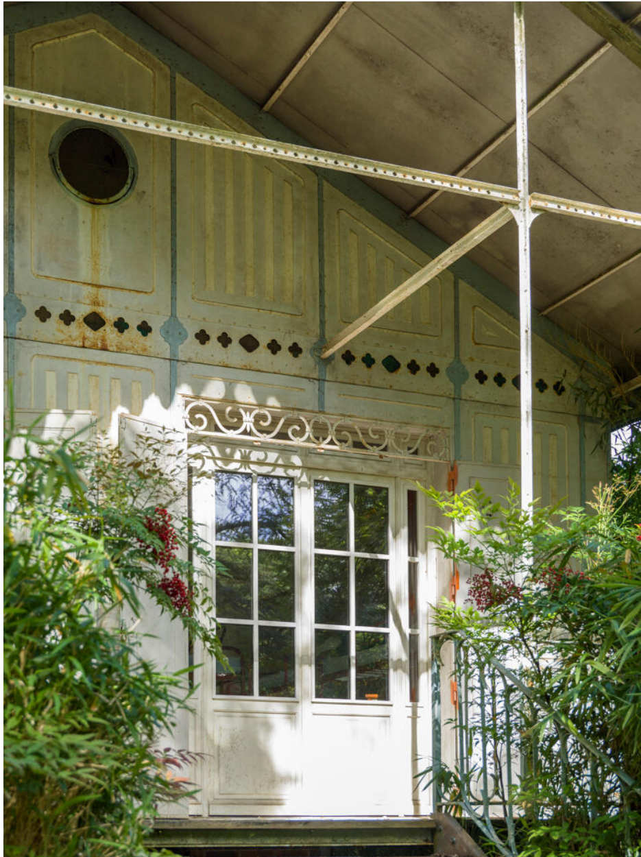
Détail de la varangue, soutenue par de fins poteaux.
