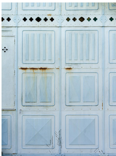
Panneaux en façade latérale.
