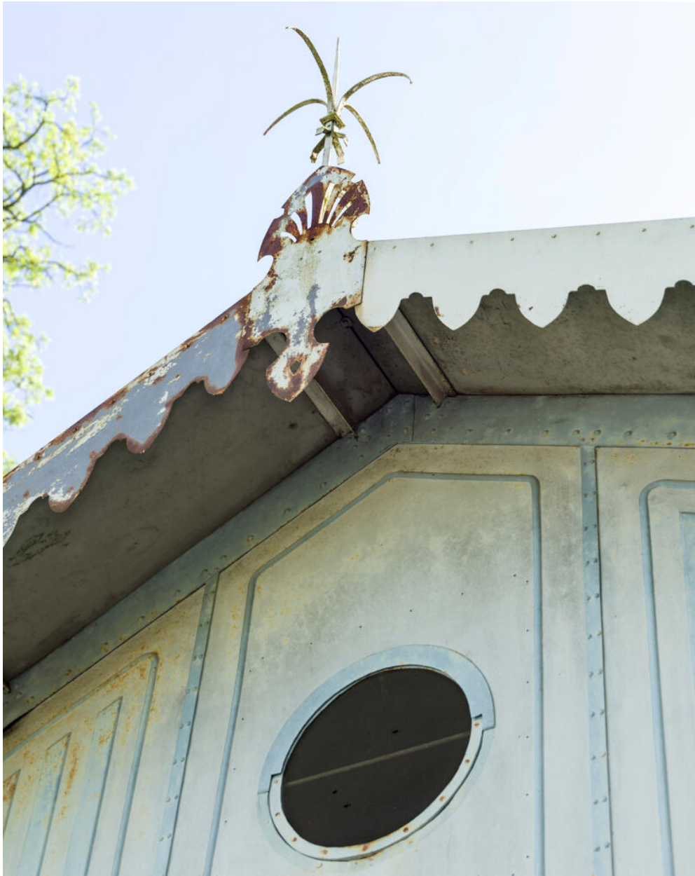
Détail de l'épi de faitage au droit du pignon postérieur à lambrequins.
