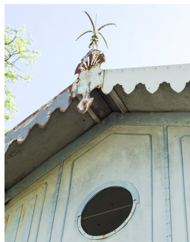
Détail de l'épi de faîtage au droit du pignon postérieur à lambrequins.
