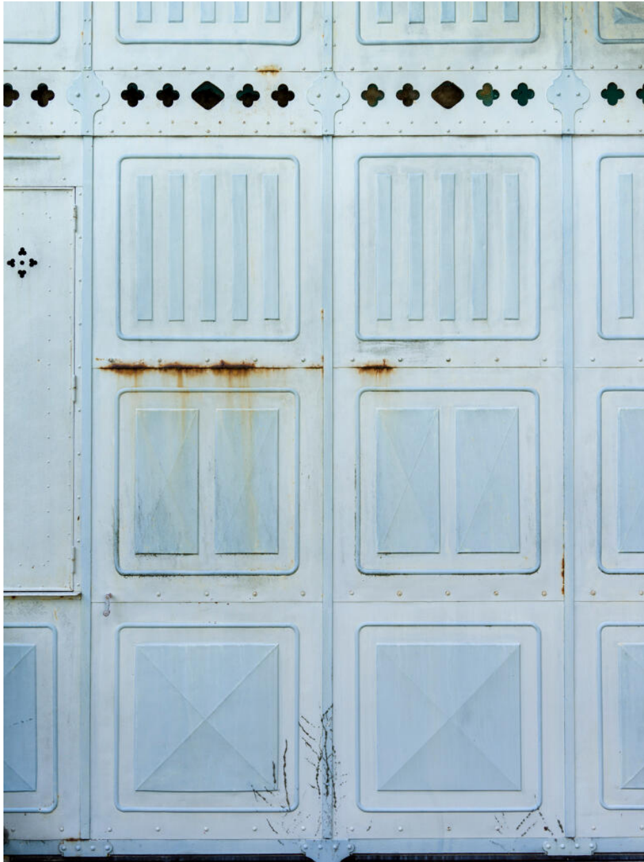
Panneaux en façade latérale.
