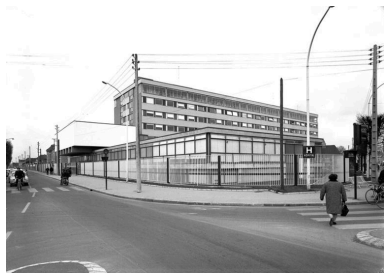
Le bloc construit par Lopez en cours d'achèvement. (Fonds Bertin). Phot. Bertin
