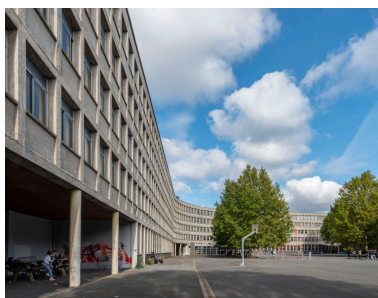
La barre courbe de l'externat est partiellement ouverte au rez-de-chaussée, pour ménager des préaux sous pilotis. Phot. Philippe Ayrault IVR11_20209300600NUC4A
