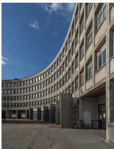
Les salles de classes du bâtiment de l'externat donnent toutes sur la cour et sont desservies par un long couloir placé à l'arrière. Phot. Philippe Ayrault IVR11_20209300605NUC4A
