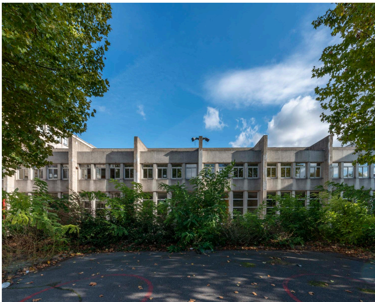
Le bâtiment abritant le réfectoire, à l'étage et le gymnase, au niveau bas.
