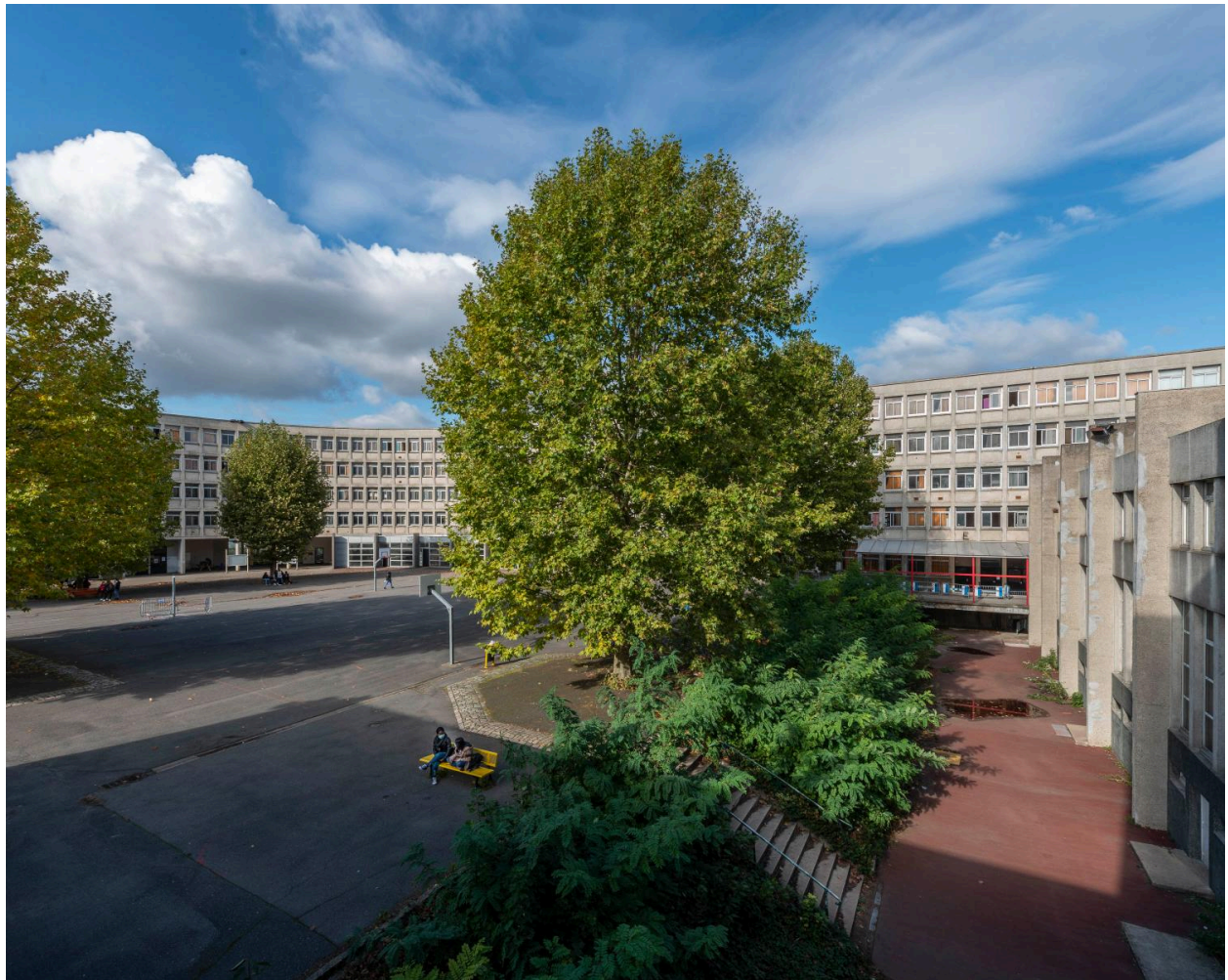
Vue d'ensemble de la cour basse, avec le bâtiment courbe de l'externat, au fond.
