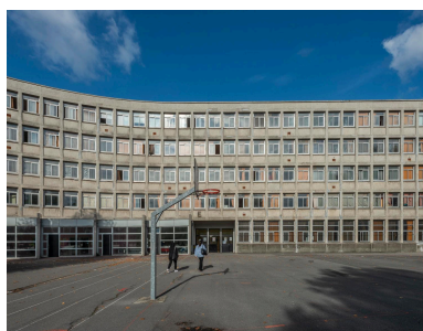
L'ossature du bâtiment d'enseignement est en béton armé et les panneaux de façade ont été préfabriqués en usine par l'entreprise La Rennaise de préfabrication. Phot. Philippe Ayrault IVR11_20209300603NUC4A
