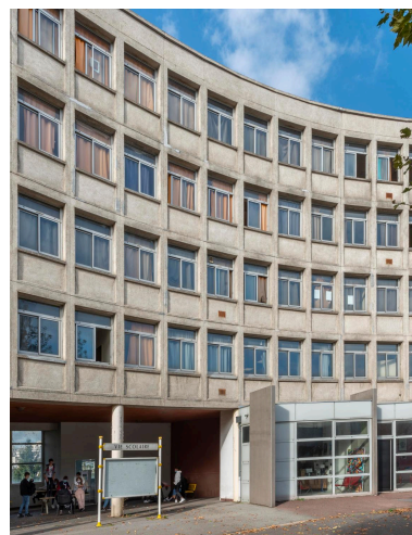
La barre longiligne s'incurve. L'effet de répétition est saisissant, les façades étant composées à partir de la trame d'1,75 m de côté mise au point par le ministère de l'Education nationale en 1952. Phot. Philippe Ayrault IVR11_20209300602NUC4A
