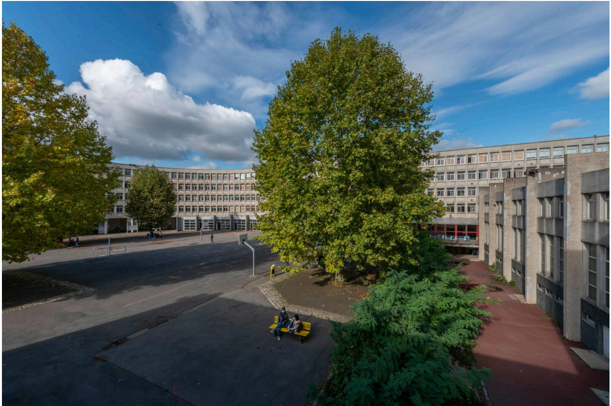
Vue générale sur la cour basse du lycée, avec au fond l'aile courbe de l'externat.
