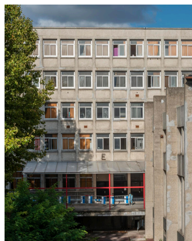
Détail de la trame régulière de l'externat, avec les panneaux de façade préfabriqués. Phot. Philippe Ayrault IVR11_20209300610NUC4A
