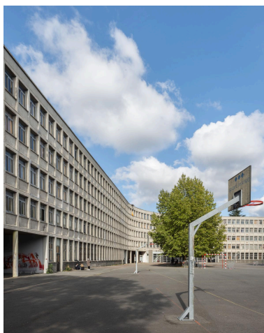
Vue générale de la longue barre courbe de l'externat. Phot. Philippe Ayrault IVR11_20209300597NUC4A
