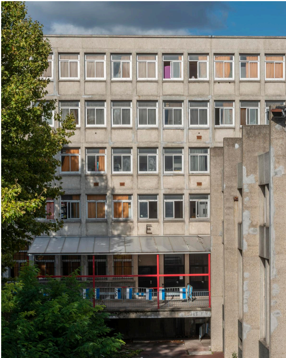
Détail de la trame régulière de l'externat, avec les panneaux de façade préfabriqués.
