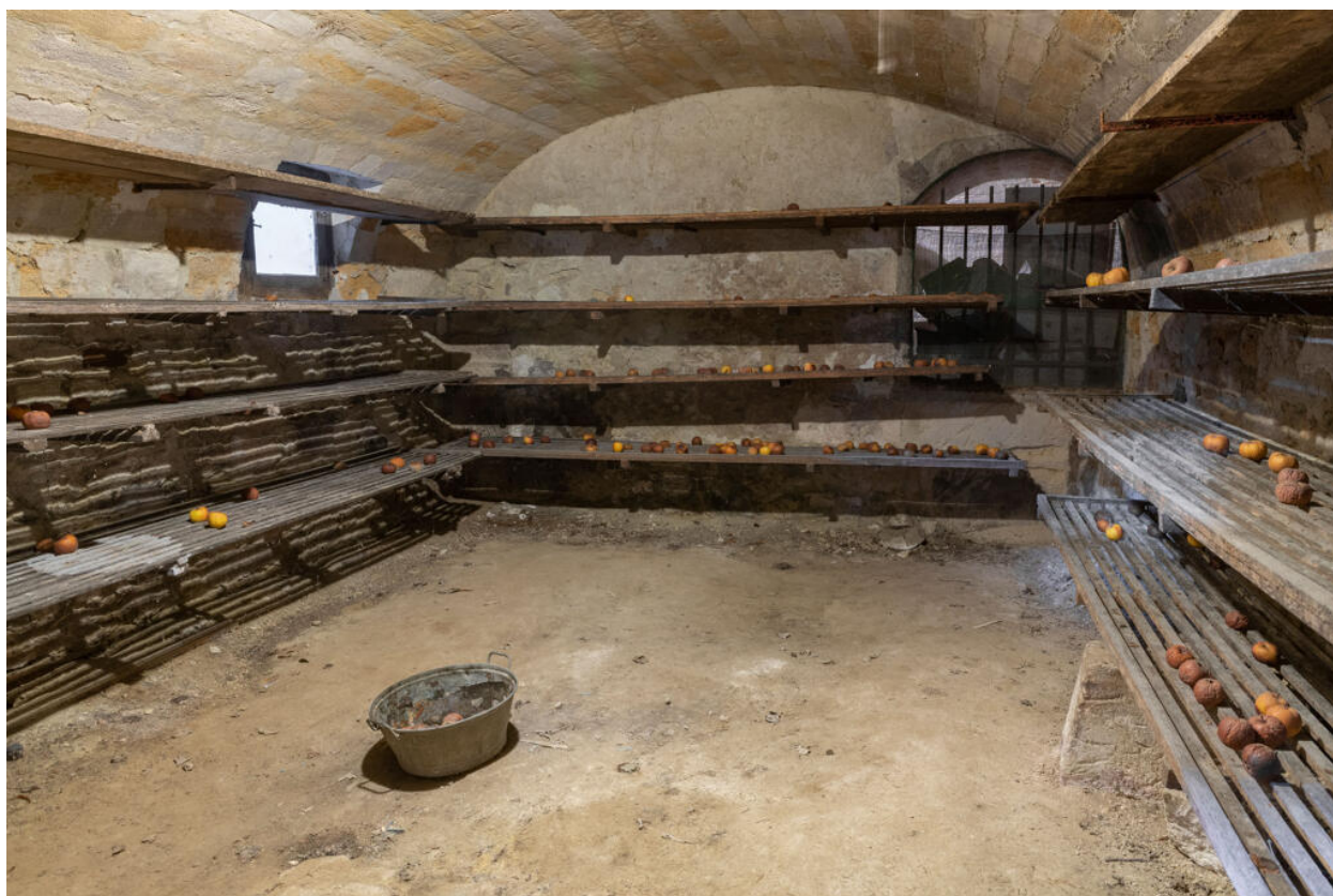
Le fruitier, à la voûte bien appareillée, dans la partie la plus ancienne du bâtiment.
