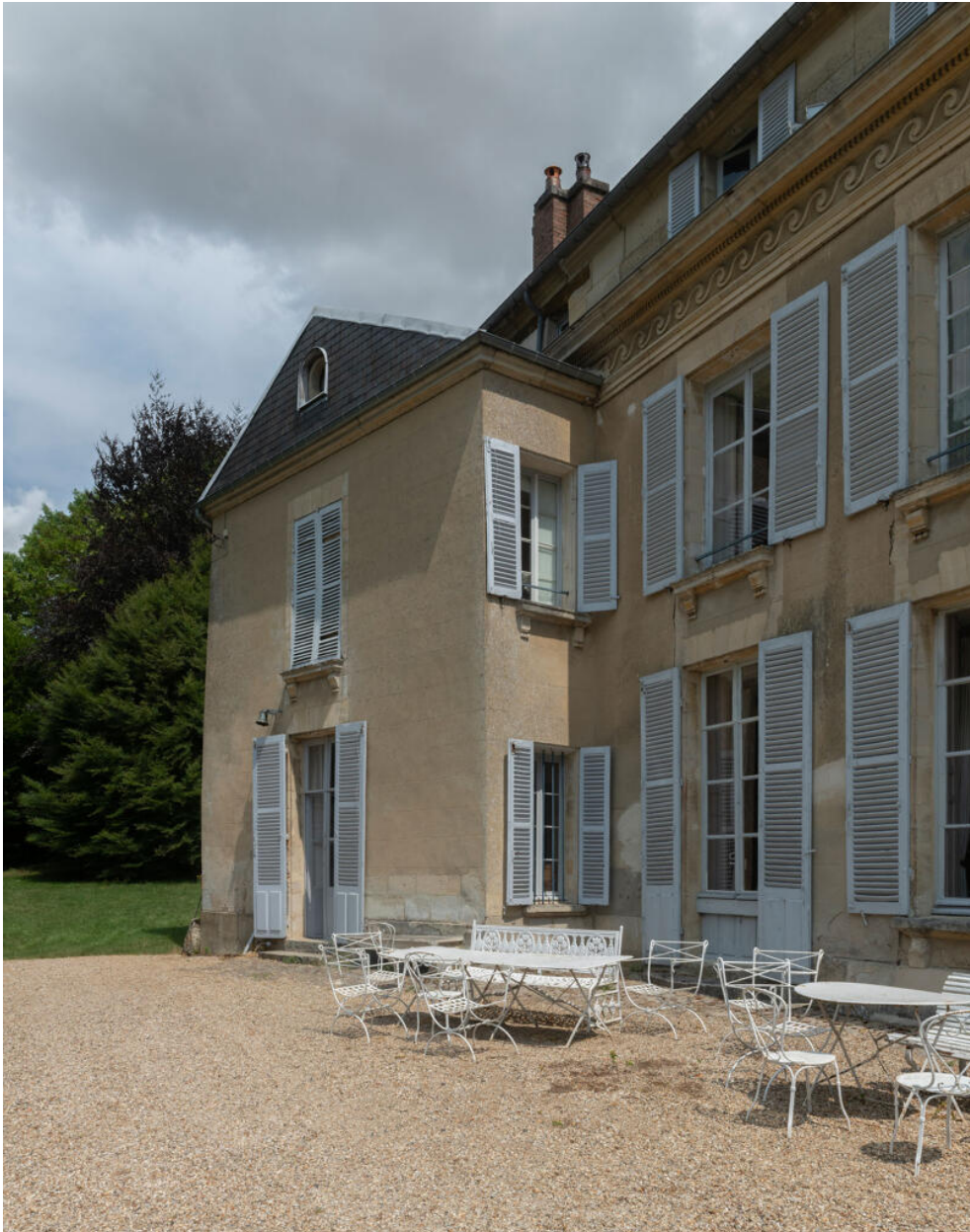
L'angle où se joignent le bâtiment primitif et la grande aile postérieure.
