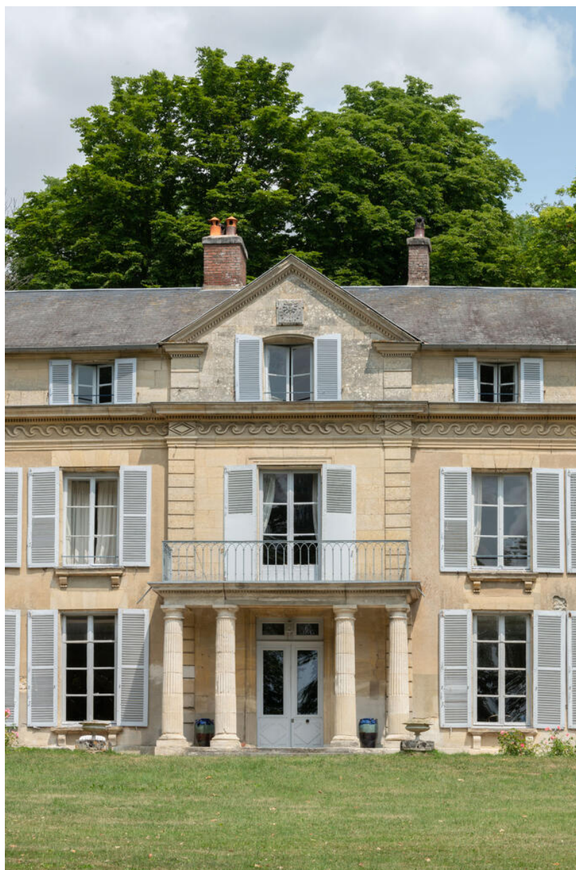
L'avant-corps central d'architecture néo-classique avec son porche à colonne surmonté d'un fronton triangulaire.
