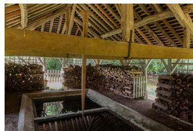
L'intérieur du lavoir séchoir. IVR11_20239500185NUC4A
