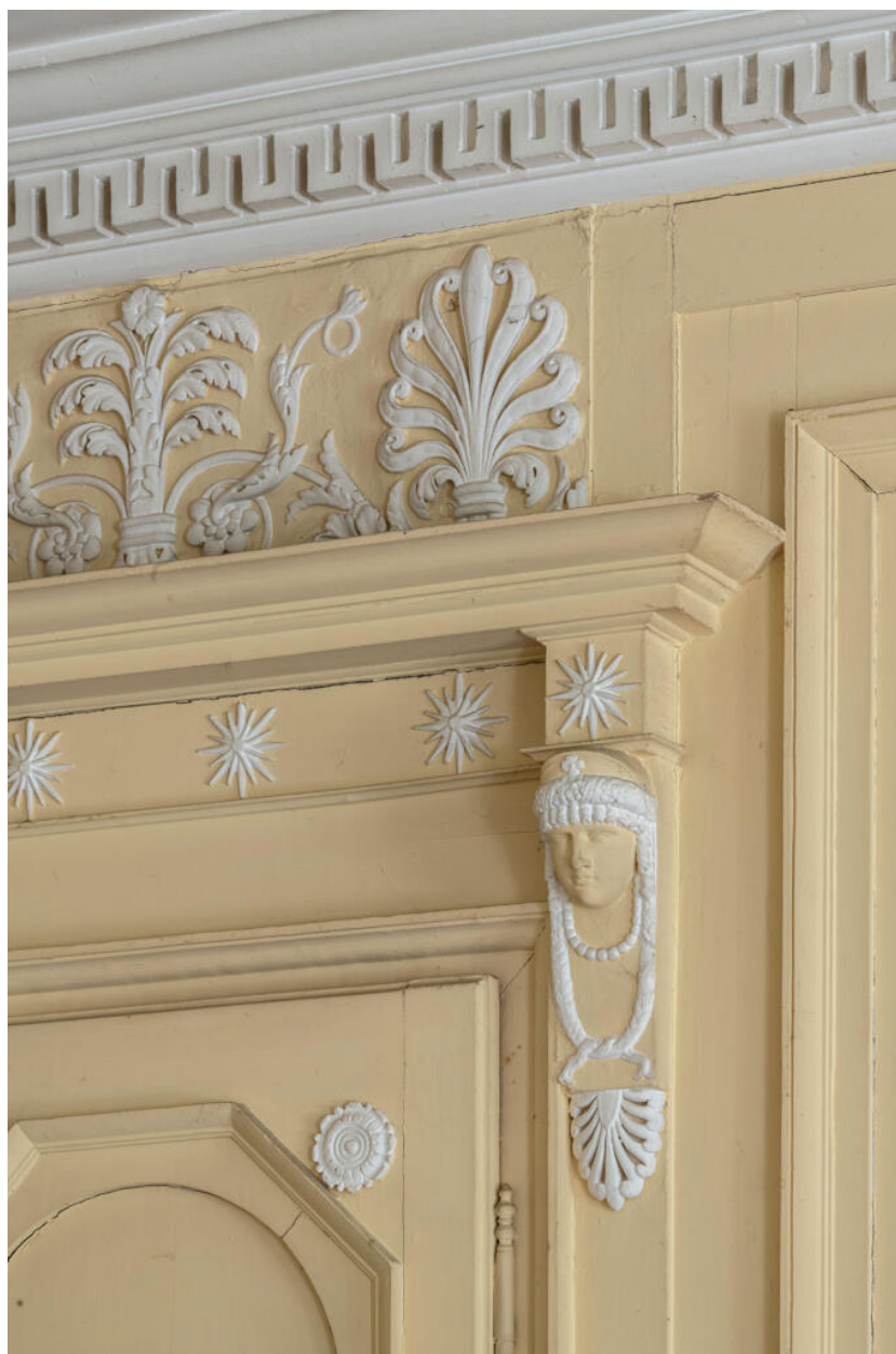
Détail du chambranle de la porte du salon.
