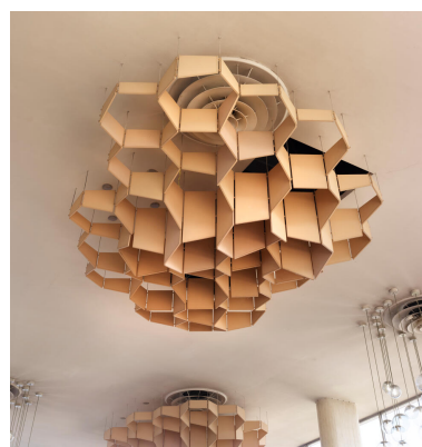
Salle des fêtes. Détail d'un nid d'abeille, destiné à atténuer l'effet de résonance. Phot. Asseline Stéphane IVR11_20249400447NUC4A
