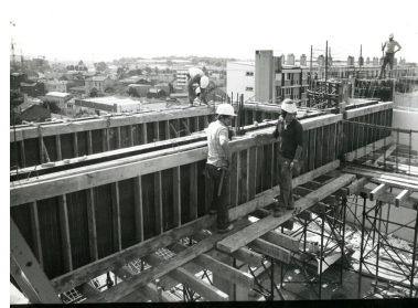
Ouvriers au travail sur le chantier. Tirage photographique noir et blanc, 18 x 24 cm, 22 juillet 1975, album de photographies de chantier réalisé par Gérard Guillaud - L'Image Contemporaine, pour l'entreprise Quillery (coll. Gilbert Picquenard).
