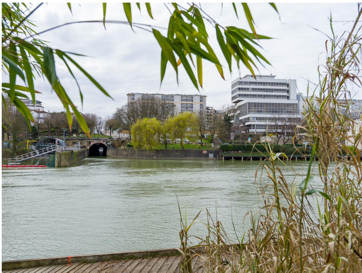
Vue générale depuis la rive gauche. À gauche, le tunnel du canal de Saint-Maur.
