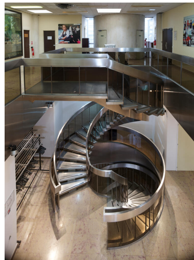
Vue de l'escalier en vis desservant les bureaux du deuxième étage. Limon, rampes et marches en acier inoxydable, garde- corps en verre fumé. Conçu par G. Picquenard, construit par l'entreprise Voisin (fabrication en atelier, puis remonté sur place). Phot. Asseline Stéphane IVR11_20249400424NUC4A
