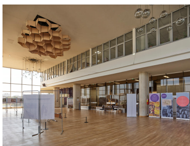
Salle des fêtes. Au plafond, des nids d'abeilles installés par G. Picquenard (sur conseil d'un acousticien), destinés à atténuer l'effet de résonance. Lustres dessinés par l'architecte. Phot. Asseline Stéphane IVR11_20249400443NUC4A
