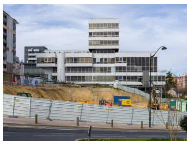
Façade est. En soubassement (premier et deuxième sous-sols),
