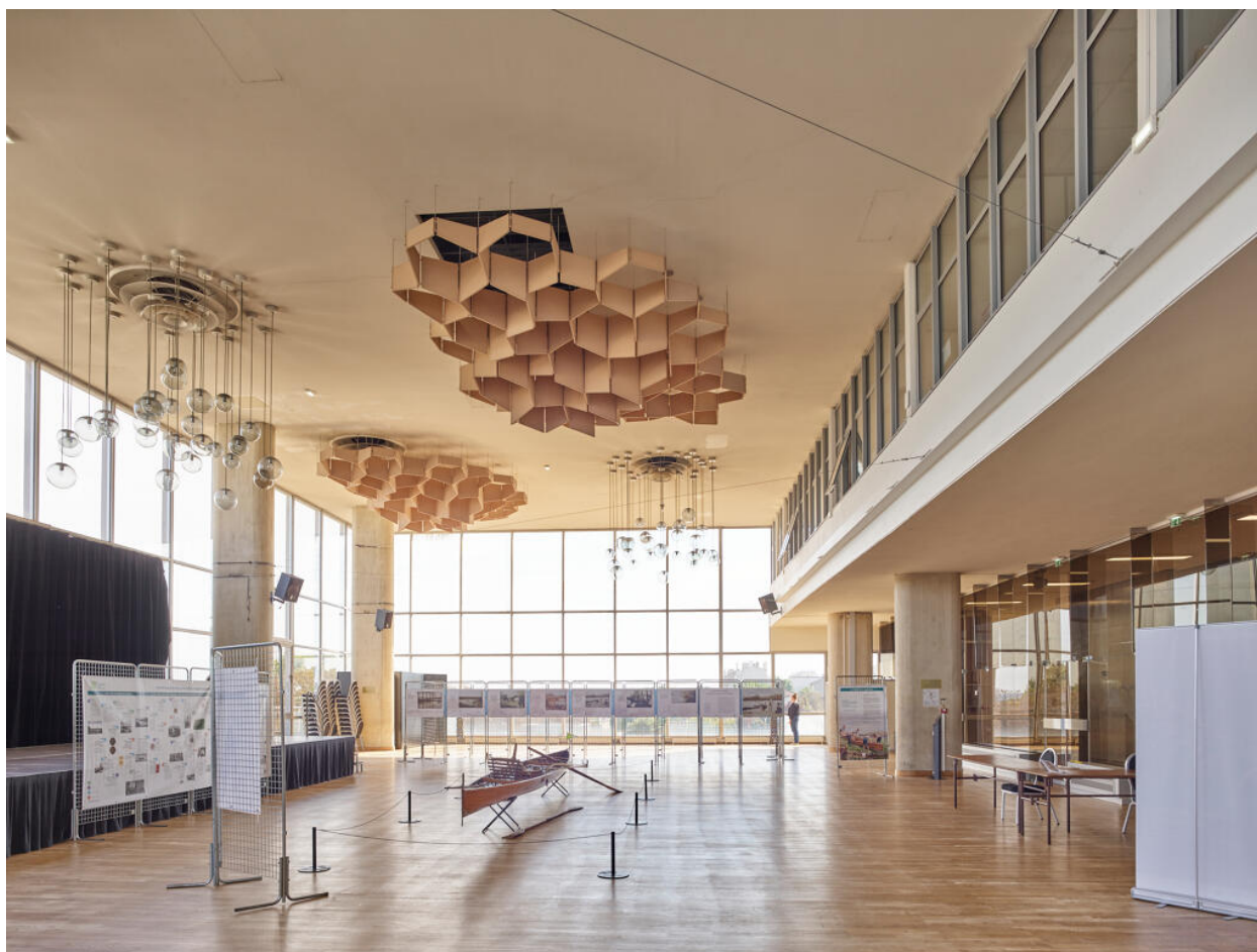
Salle des fêtes. Au plafond, des nids d'abeilles installés par G. Picquenard (sur conseil d'un acousticien), destinés à atténuer l'effet de résonance (provoqué par l'importance du vitrage dans la salle). Lustres dessinés par l'architecte.
