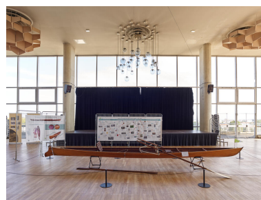
Salle des fêtes. Au plafond, des nids d'abeilles installés par G. Picquenard (sur conseil d'un acousticien), destinés à atténuer l'effet de résonance. Lustres dessinés par l'architecte. Phot. Asseline Stéphane IVR11_20249400444NUC4A
