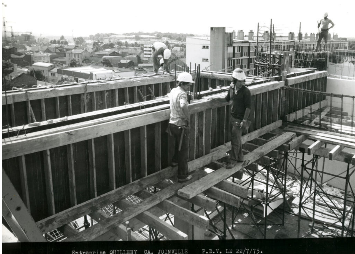
Ouvriers au travail sur le chantier. Tirage photographique noir et blanc, 18 x 24 cm, 22 juillet 1975, album de photographies de chantier réalisé par Gérard Guillet - L'Image Contemporaine, pour l'entreprise Quillery (coll. Gilbert Picquenard).
