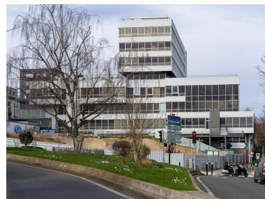
Façade est. En soubassement (premier et deuxième sous-sols), la salle de spectacle (initialement appelée "salle des congrès") et l'ancien commissariat. Au rez-de-chaussée, les services d'accueil et à l'arrière la bibliothèque. Au premier étage, la salle des fêtes. Au deuxième étage, le bureaux des élus (en encorbellement), la salle des mariages et la salle du conseil municipal. En partie supérieure, l'ancien restaurant du personnel puis trois étages de bureaux. Phot. Asseline Stéphane IVR11_20249400003NUC4A
