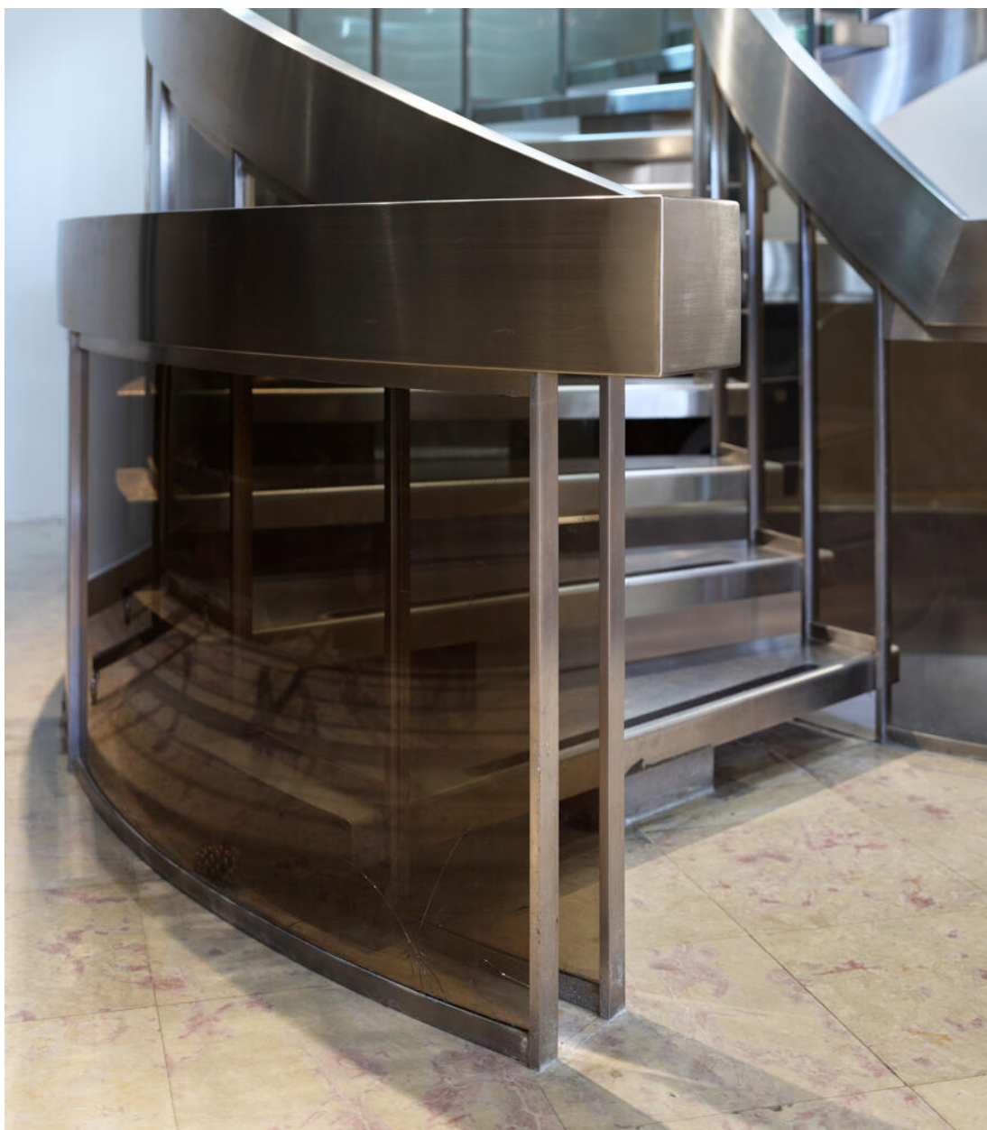
Escalier en vis desservant les bureaux du deuxième étage. Détail de finition de l'acier inoxydable. Double paroi.
