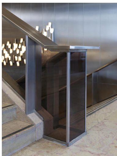
Poteau soutenant les deux rampes, au premier étage. Phot. Asseline Stéphane IVR11_20249400439NUC4A
