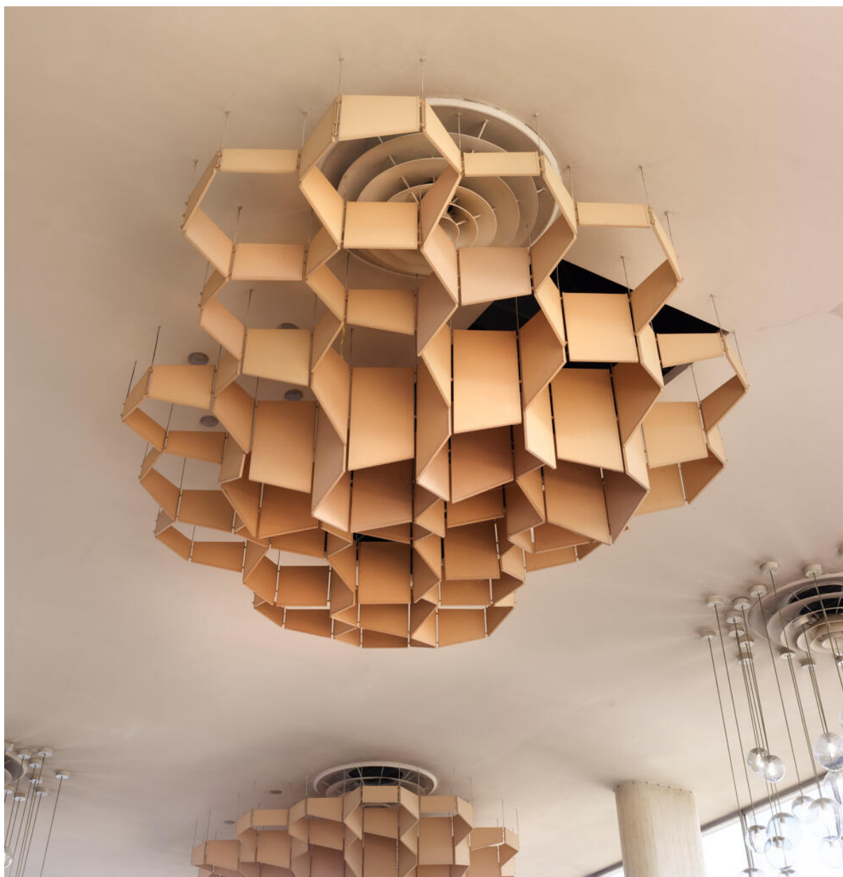
Salle des fêtes. Détail d'un nid d'abeille, destiné à atténuer l'effet de résonnance.
