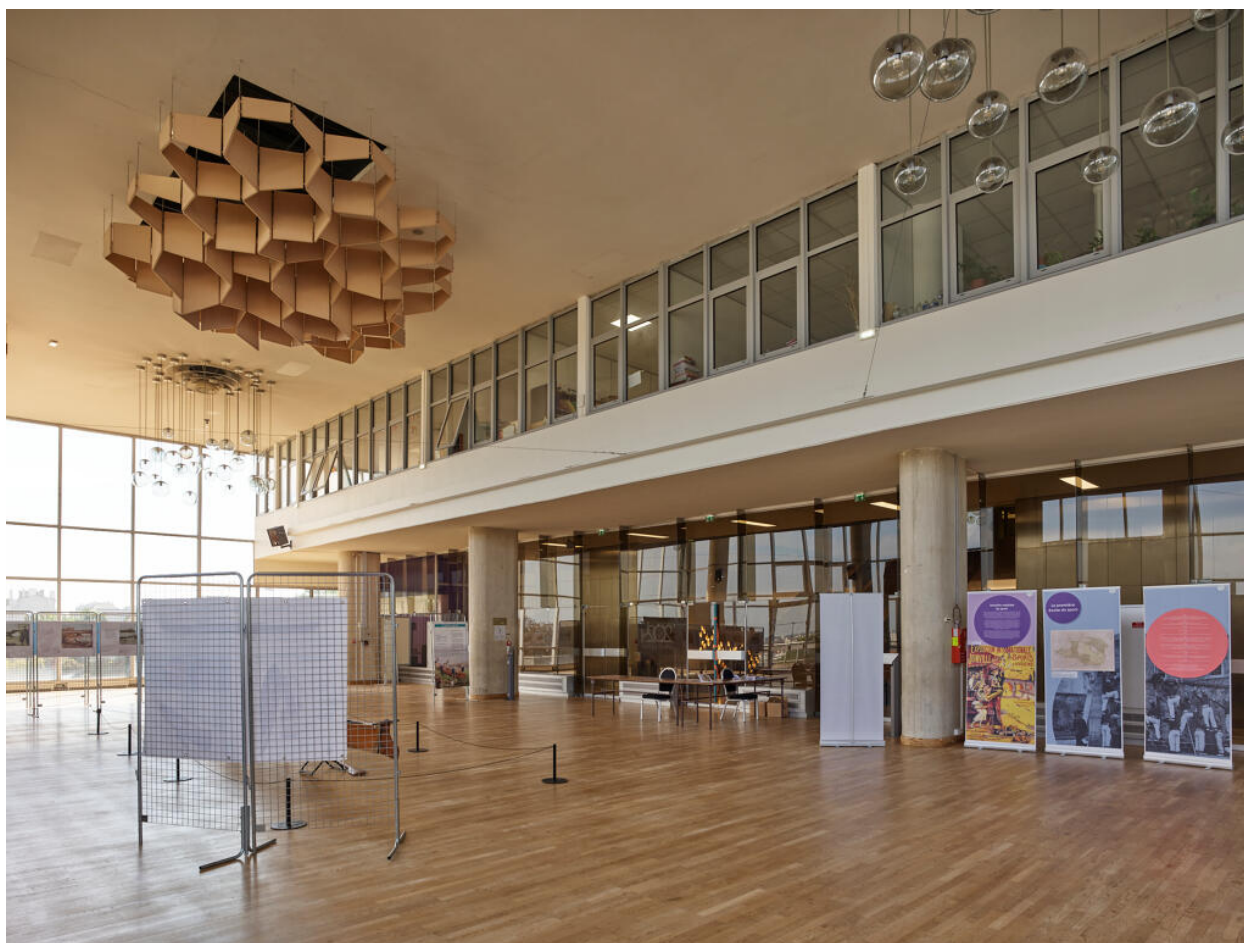
Salle des fêtes. Au plafond, des nids d'abeilles installés par G. Picquenard (sur conseil d'un acousticien), destinés à atténuer l'effet de résonance. Lustres dessinés par l'architecte.
