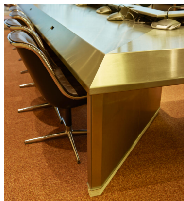
Salle du conseil municipal. Détail de finition en acier inoxydable légèrement brossé, sur la table conçue par l'architecte Gilbert Picquenard et réalisée par l'entreprise Voisin.
