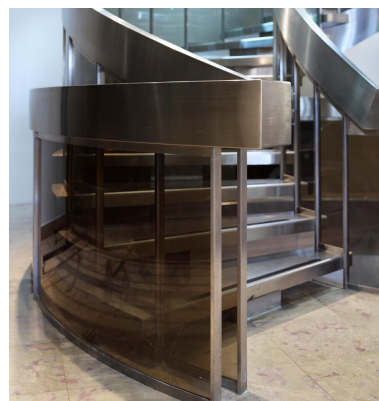
Vue de l'escalier en vis desservant les bureaux du deuxième étage. Limon, rampes et marches en acier inoxydable, garde- corps en verre fumé. Conçu par G. Picquenard, construit par l'entreprise Voisin (fabrication en atelier, puis remonté sur place). Phot. Asseline Stéphane IVR11_20249400424NUC4A
