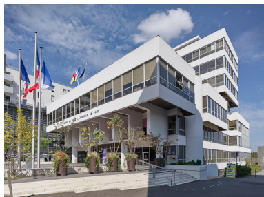
Le parvis et le flanc est de la mairie, vus depuis la rue de Paris. Phot. Asseline Stéphane IVR11_20249400400NUC4A
