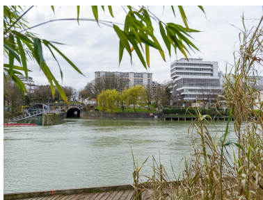
Vue générale depuis la rive gauche. À gauche, le tunnel du canal de Saint-Maur.
