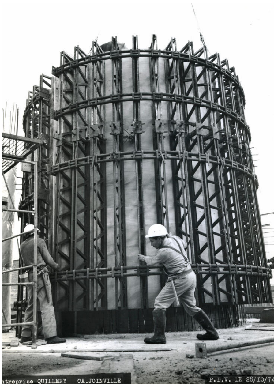
Coffrage de l'escalier hors-œuvre, ouvriers au travail. Tirage photographique noir et blanc, 18 x 24 cm, 25 février 1975, album de photographies de chantier réalisé par Gérard Guillat - L'Image Contemporaine, pour l'entreprise Quillery (coll. Gilbert Picquenard).
