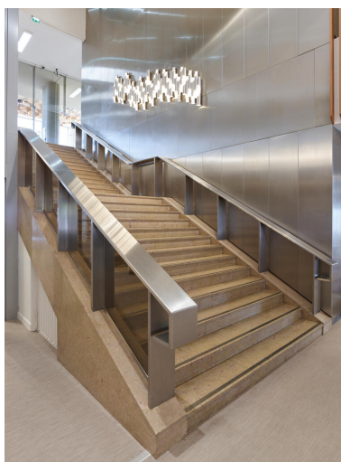
Escalier principal (escalier d'honneur), vue depuis le rez-de-chaussée. Phot. Asseline Stéphane IVR11_20249400441NUC4A
