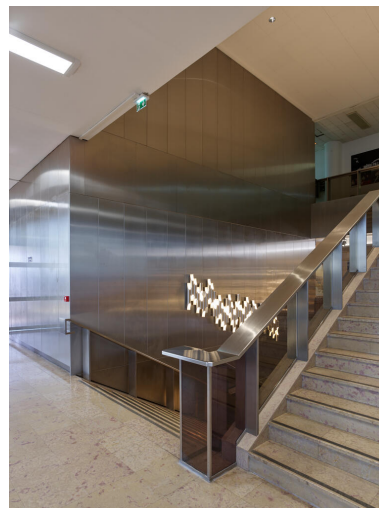
Escalier principal (escalier d'honneur), vue depuis le premier étage. Dessiné par G. Picquenard. Rampe en inox et garde-corps en verre fumé, revêtement en travertin. Luminaire composé par G. Picquenard à partir de tubes individuels préexistants. Phot. Asseline Stéphane IVR11_20249400432NUC4A
