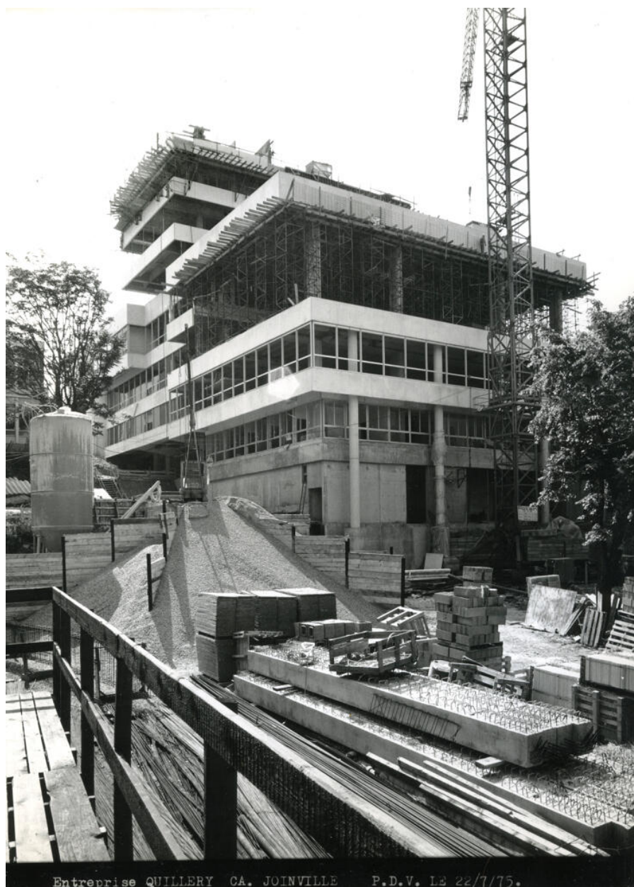
Vue de la façade nord en chantier. Tirage photographique noir et blanc, 18 x 24 cm, 22 juillet 1975, album de photographies de chantier réalisé par Gérard Guillaud - L'Image Contemporaine, pour l'entreprise Quillery (coll. Gilbert Picquenard).
