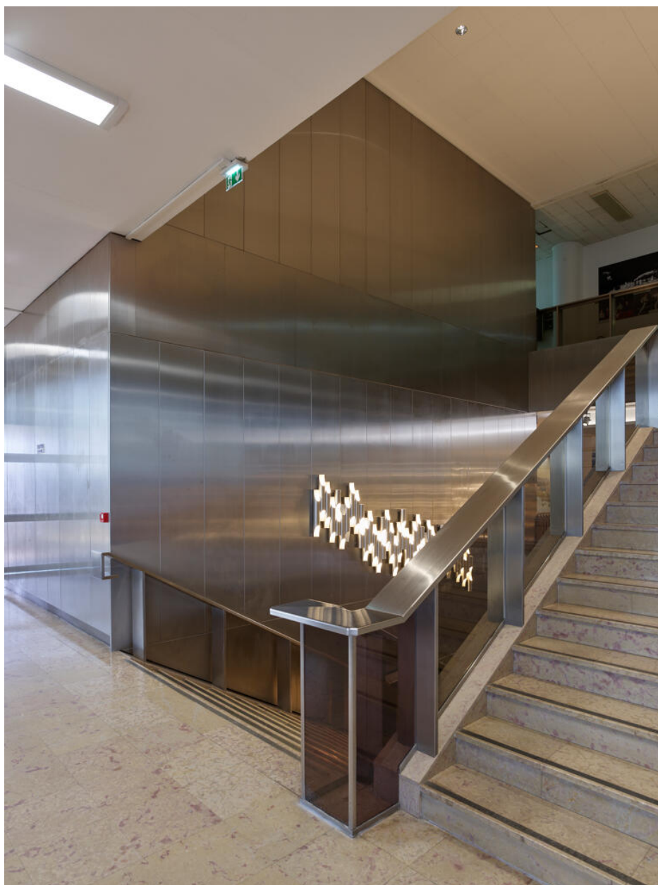
Escalier principal (escalier d'honneur), vue depuis le premier étage. Dessiné par G. Picquenard. Rampe en inox et garde-corps en verre fumé, revêtement en travertin. Luminaire composé par G. Picquenard à partir de tubes individuels préexistants.
