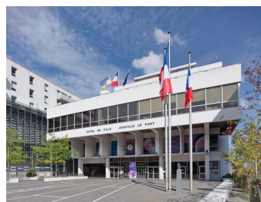
Le parvis, façade sud-ouest, dans son aménagement actuel. À l'origine, l'aménagement du parvis comprenait une fontaine, trois arbres, et trois fosses permettant l'accès au parking installé au premier sous-sol. Au deuxième étage, au centre, le bureau du maire. Au premier étage, l'horloge de l'ancienne mairie. Phot. Asseline Stéphane IVR11_20249400399NUC4A
