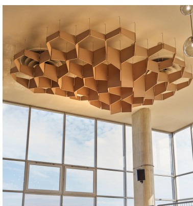
Salle des fêtes. Détail d'un nid d'abeille, destiné à atténuer l'effet de résonance. Phot. Asseline Stéphane IVR11_20249400446NUC4A
