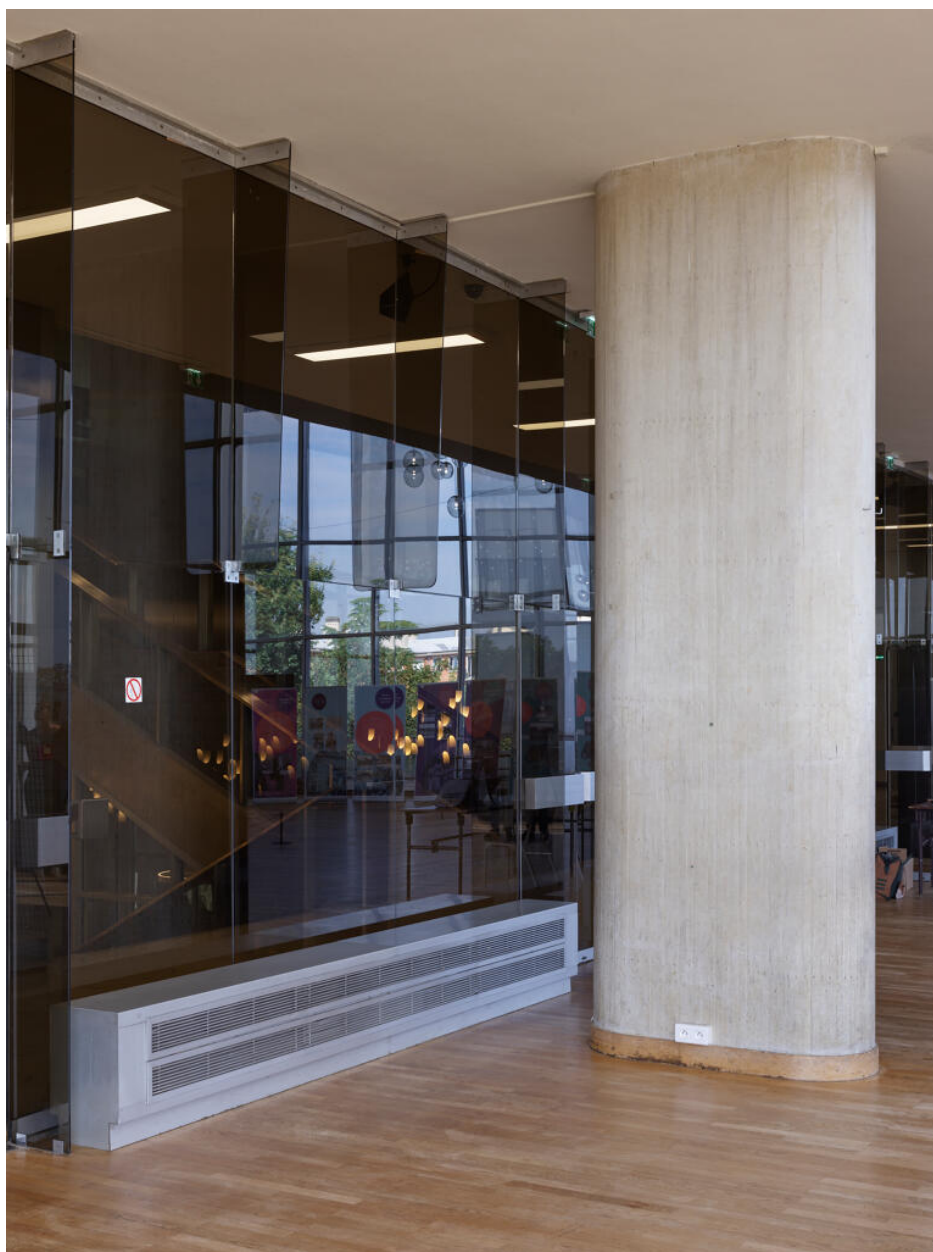
Salle des fêtes. Poteau en béton brut avec un coffrage soigné.
