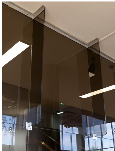
Salle des fêtes. Détail du contreventement du mur d'entrée de la salle, en verre fumé. Phot. Asseline Stéphane IVR11_20249400451NUC4A
