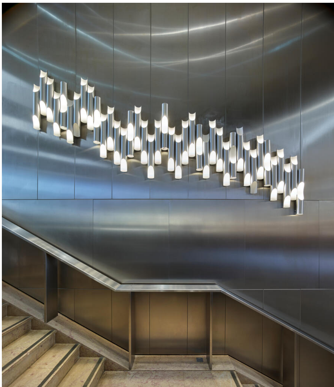
Escalier principal (escalier d'honneur), vue depuis le premier étage. Dessiné par G. Picquenard. Rampe en inox et garde-corps en verre fumé, revêtement en travertin. Luminaire composé par G. Picquenard à partir de tubes individuels préexistants. Les tubes reprennent le dessin de l'escalier. Mur en plaques de métal.
