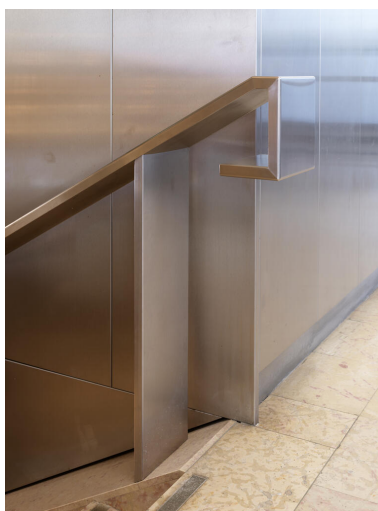
Détail de la rampe. Phot. Asseline Stéphane IVR11_20249400440NUC4A
