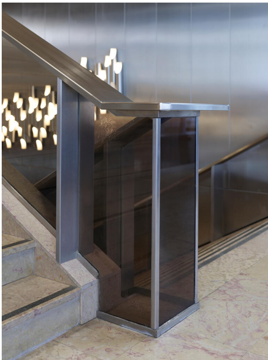
Poteau soutenant les deux rampes, au premier étage.
