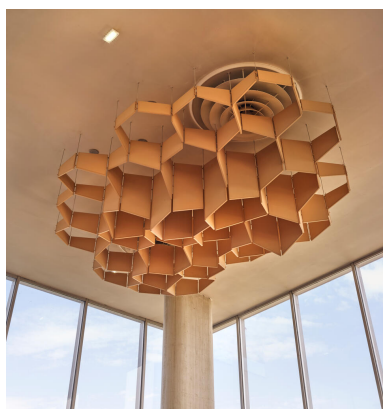
Salle des fêtes. Détail d'un nid d'abeille, destiné à atténuer l'effet de résonance. Phot. Asseline Stéphane IVR11_20249400448NUC4A
