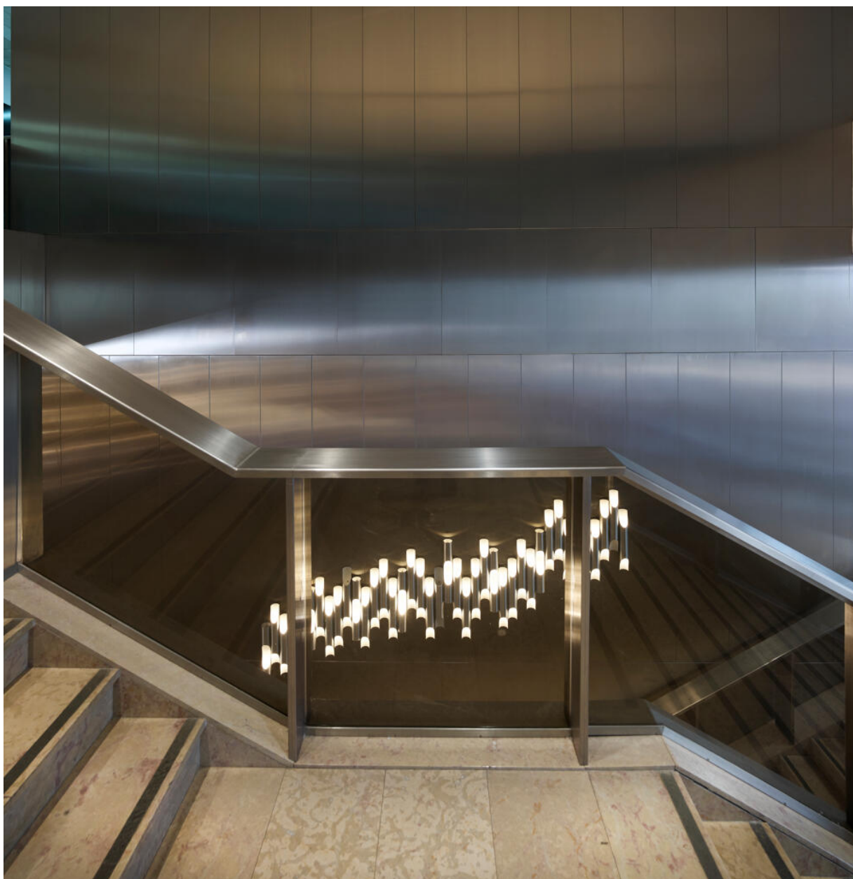
Escalier principal (escalier d'honneur), vue depuis le premier étage. Dessiné par G. Picquenard. Rampe en inox et garde-corps en verre fumé, revêtement en travertin. Luminaire composé par G. Picquenard à partir de tubes individuels préexistants. Les tubes reprennent le dessin de l'escalier. Mur en plaques de métal.
