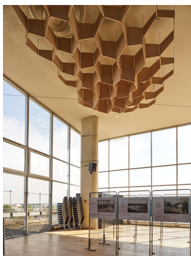
Salle des fêtes. Au plafond, des nids d'abeilles installés par G. Picquenard (sur conseil d'un acousticien), destinés à atténuer l'effet de résonance. Lustres dessinés par l'architecte. Phot. Asseline Stéphane IVR11_20249400445NUC4A
