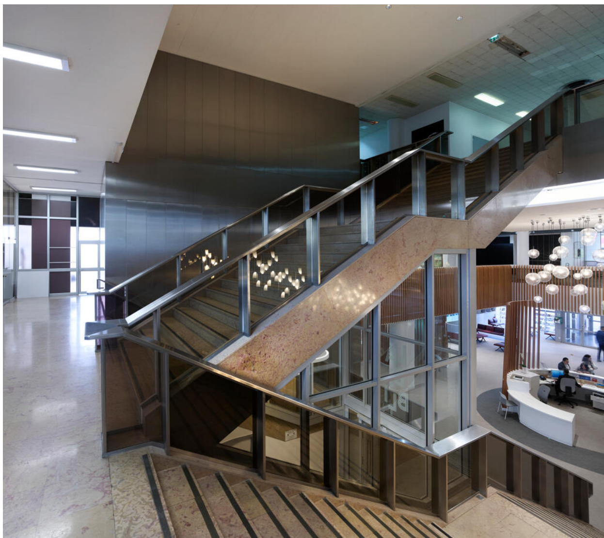
Escalier principal (escalier d'honneur), vue depuis le premier étage. Dessiné par G. Picquenard. Rampe en inox et garde-corps en verre fumé, revêtement en travertin. Luminaire composé par G. Picquenard à partir de tubes individuels préexistants.
