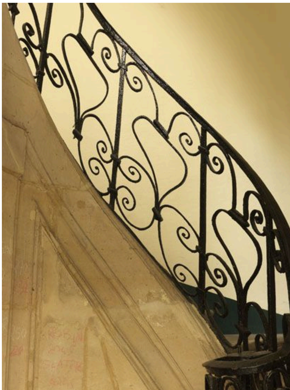
Vue des premiers balustres.
