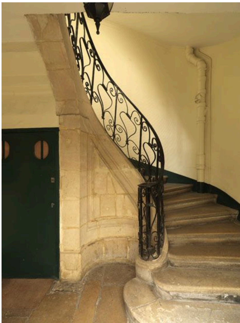
Vue de la console de départ et de la première volée.
