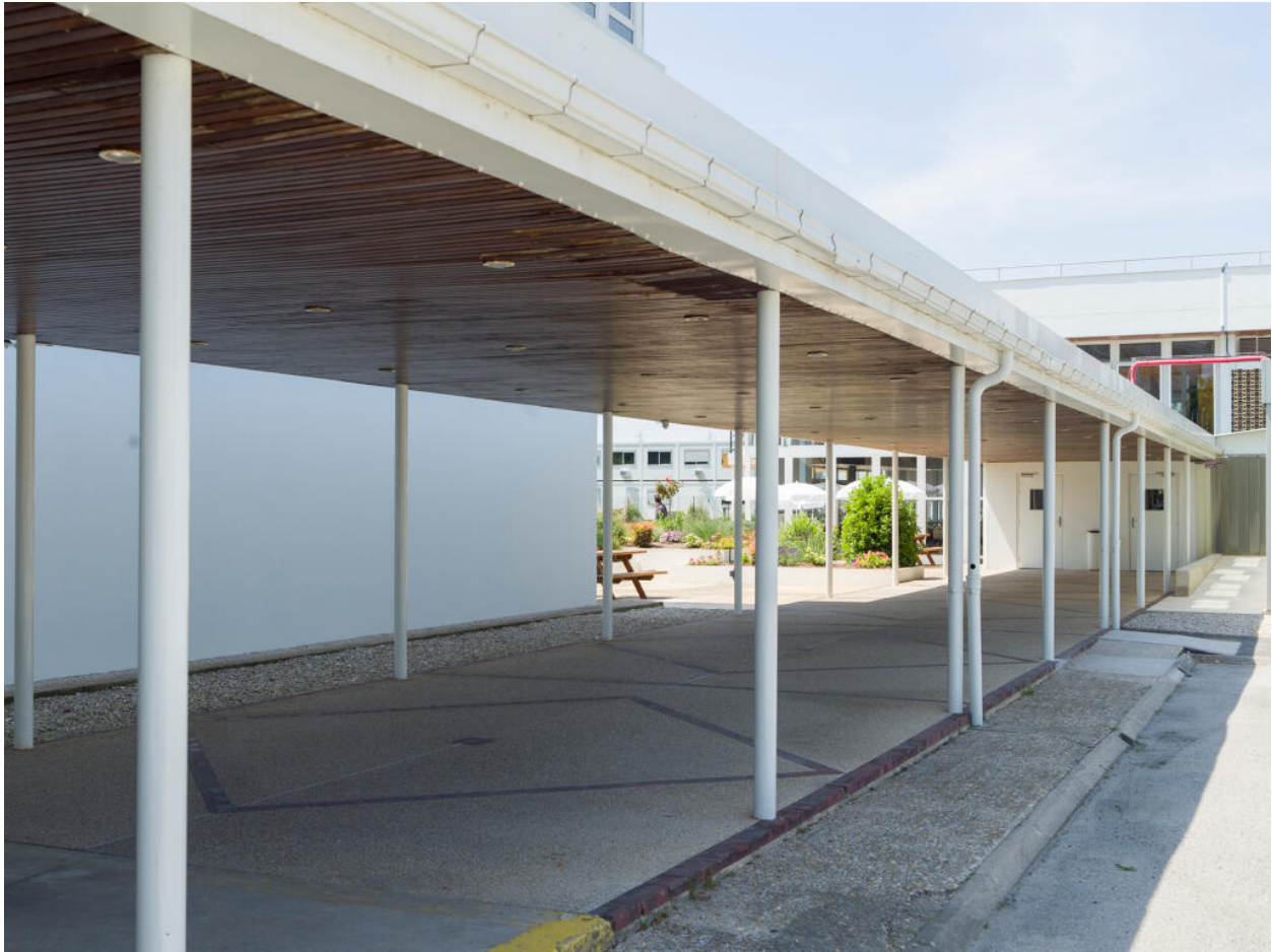
Galerie couverte entre le bâtiment administratif et le bâtiment de restauration, vu depuis le bâtiment administratif.
