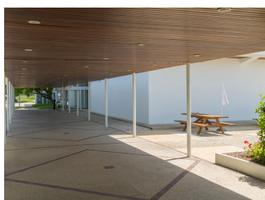
Galerie couverte entre le bâtiment administratif et le bâtiment de restauration, vue depuis le bâtiment de restauration.
