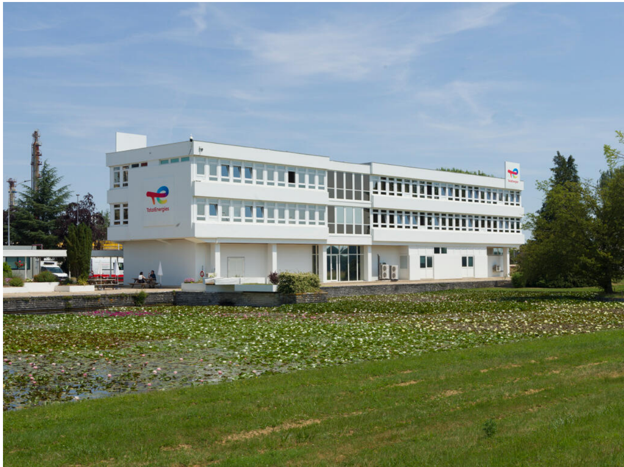
Vue sur le bâtiment administratif (angle sud-ouest) et son bassin, depuis l'extérieur du site.
