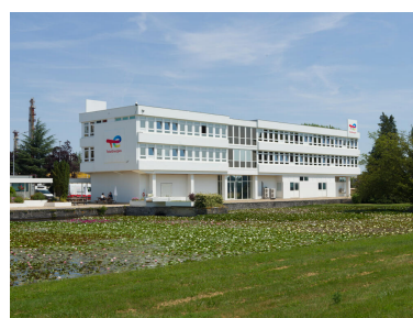
Vue sur le bâtiment administratif (angle sud-ouest) et son bassin, depuis l'extérieur du site. Phot. Stéphane Asseline, Phot. Stéphane Asseline IVR11_20237700735NUC4A
