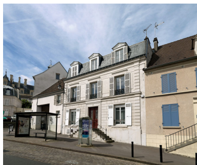
Vue d'ensemble depuis la rue. Phot. Jean-Bernard Vialles IVR11_20169500113NUC4A
