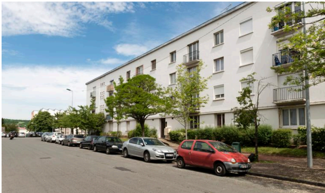
Vue de la façade sur rue de l'immeuble 1. On reconnaît les travées d'escaliers marquées par de petites fenêtres carrées.
