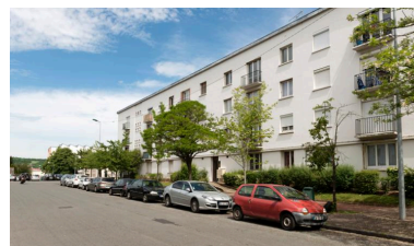
Vue de la façade sur rue de l'immeuble 1. On reconnaît les travées d'escaliers marquées par de petites fenêtres carrées. Phot. Philippe Ayrault IVR11_20177800389NUC4A
