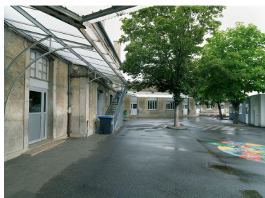
Vue de la cour à l'arrière, depuis l'ouest. Phot. Jean-Bernard Vialles IVR11_20147700330NUC4A
