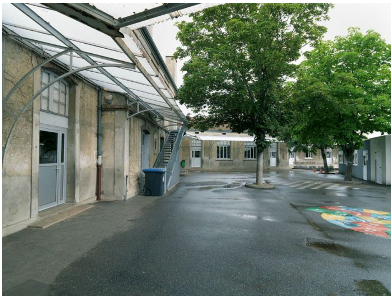
Vue de la cour à l'arrière, depuis l'ouest.
