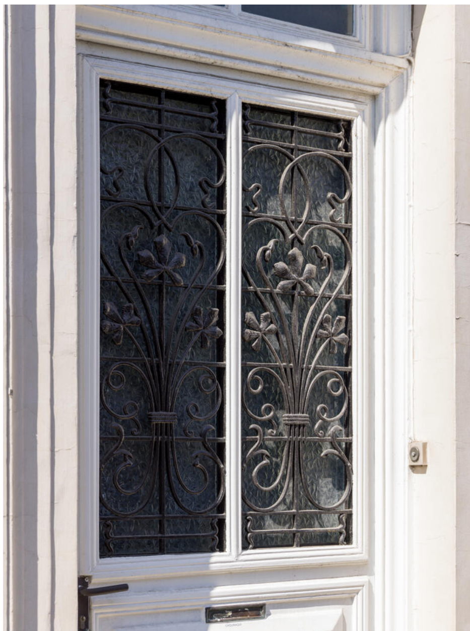
Ferronnerie de la porte d'entrée de la partie est.
