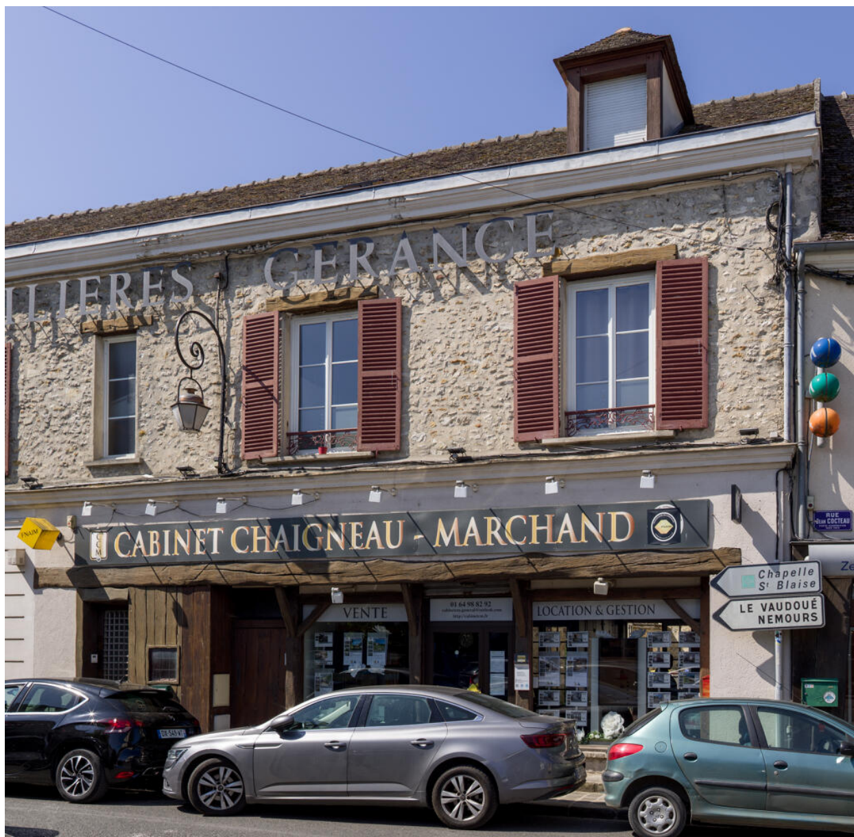
Partie ouest de la façade.
