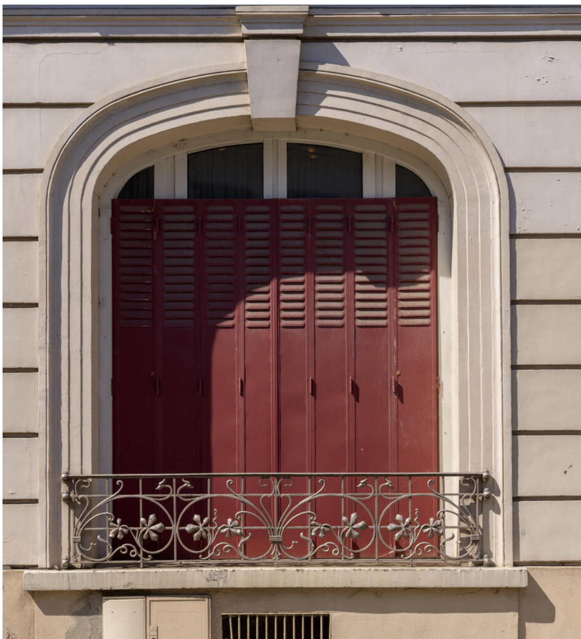
Détail de la baie est de la façade.
